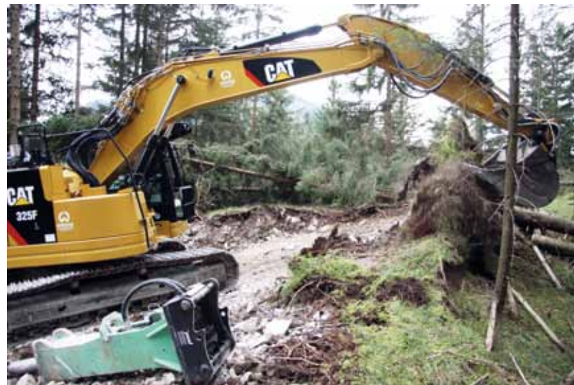
Der Bagger muss den Weg von Bäumen, Wurzeln oder Felsbrocken befreien.
