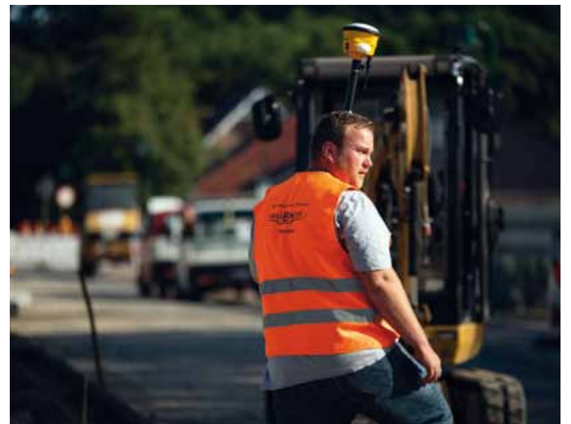
Baustellenvermessung mit Trimble-Roverstab SPS986. Foto: Sitech
