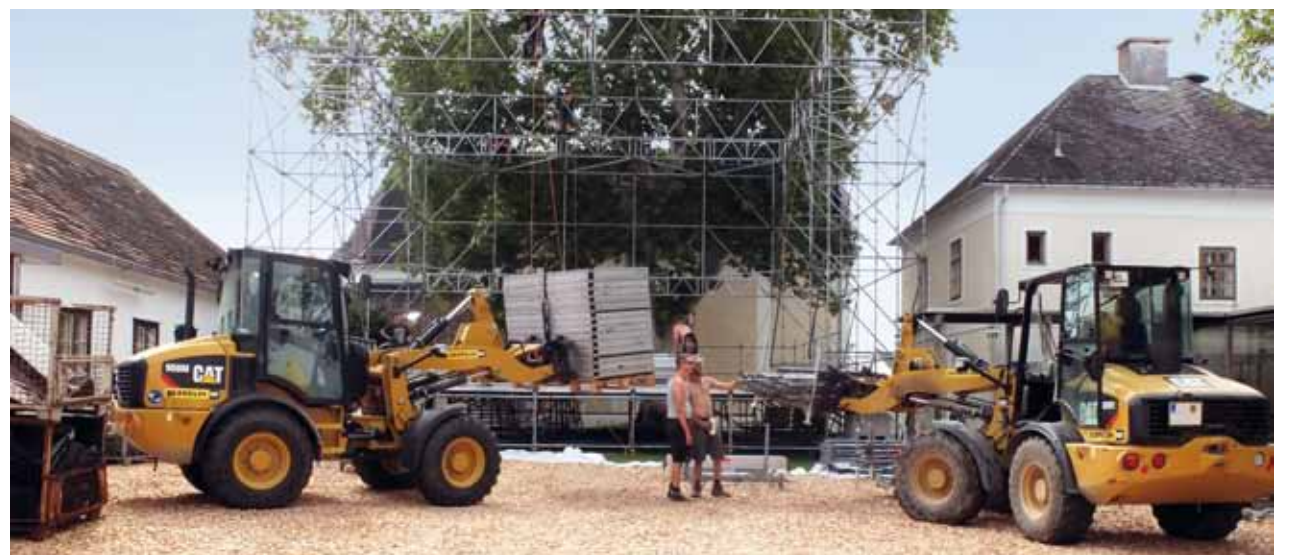
Die kompakten Cat Radlader 908M und 908H2 beim Aufbau der Großbühne.
