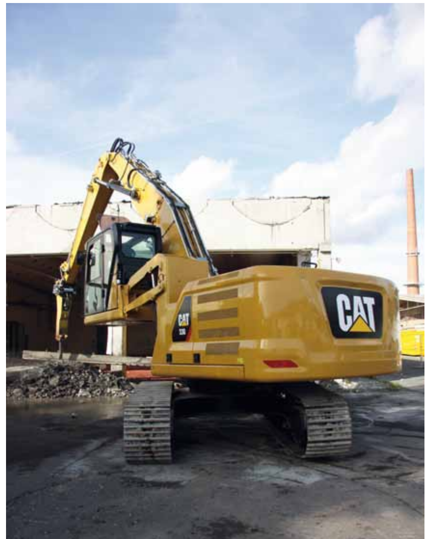
Start der Rückbauarbeiten.
