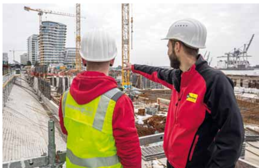
Zeppelin Rental führt die Elektro-Baustelleneinrichtung beim Bau des neuen Quartiers Strandkai in Hamburg durch. Fotos: action press/Ibrahim Ot
