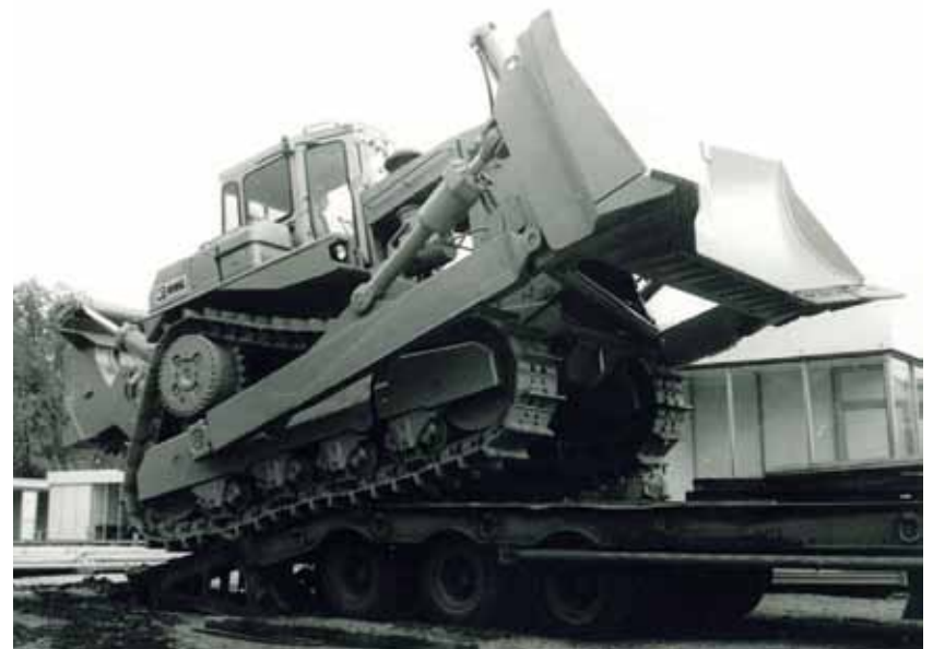
Aufbau Ost: Cat Maschinen halfen in Tschechien beim Bau von Fabriken, Chemiewerken, Kraftwerken und Wohnsiedlungen mit.
