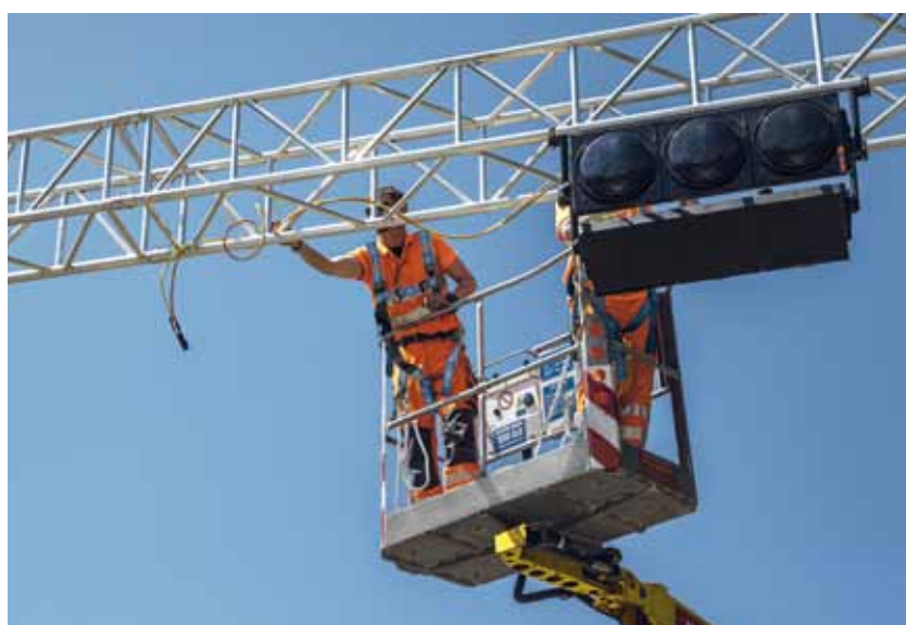
Zeppelin Rental bei der Einrichtung der Verkehrsführung in der zweiten Bauphase an der Bergedorfer Straße in Hamburg. Hier wird unter anderem die Fahrstreifensignalisierung an der temporären Verkehrszeichenbrücke angebracht. Foto: x21de – Tatjana Dachsel
