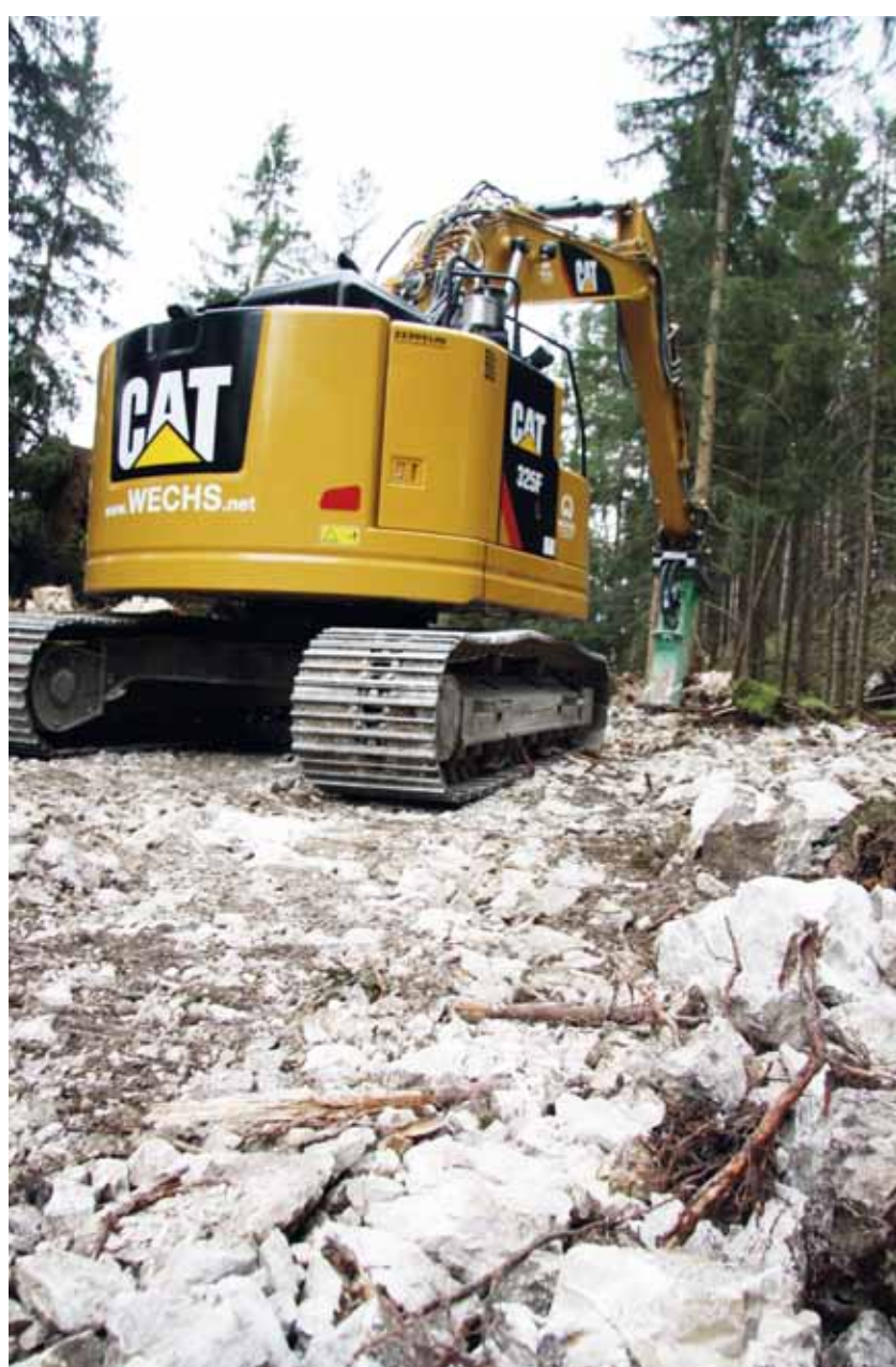
Mit einem Meißel arbeitet sich der Bagger Meter für Meter vor.
