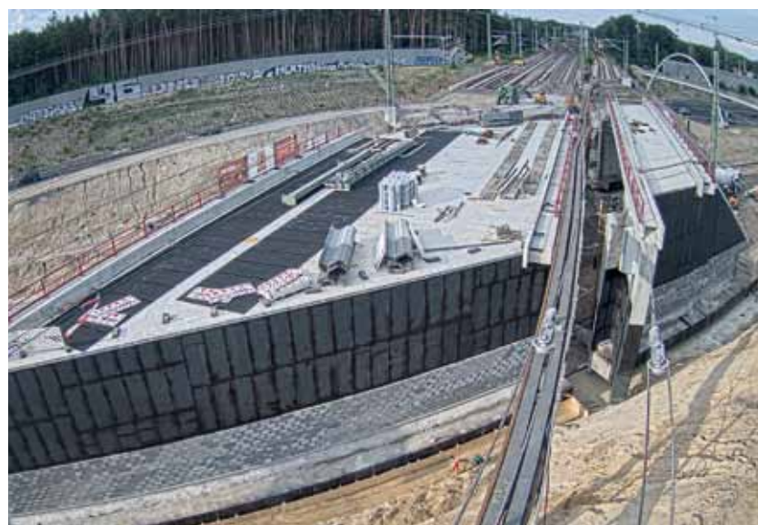
Hydraulisch werden die neuen Brückenbauwerke mittels Teflon-Platten auf Verschubbahnen eingesetzt.
