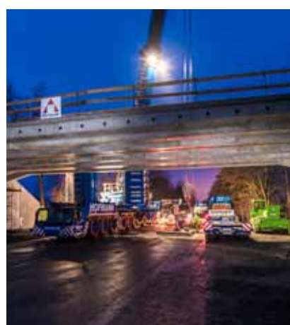
Die bis zu 110 Tonnen schweren Teile am Einbauort. Foto: HeidelbergCement/Steffen Fuchs
