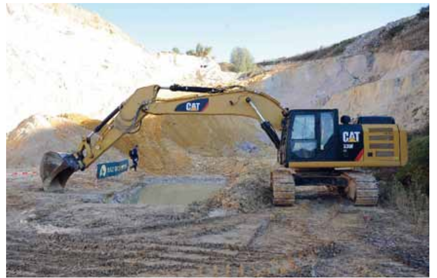
Baumaschinen waren selbst Teil der Hindernisse.
