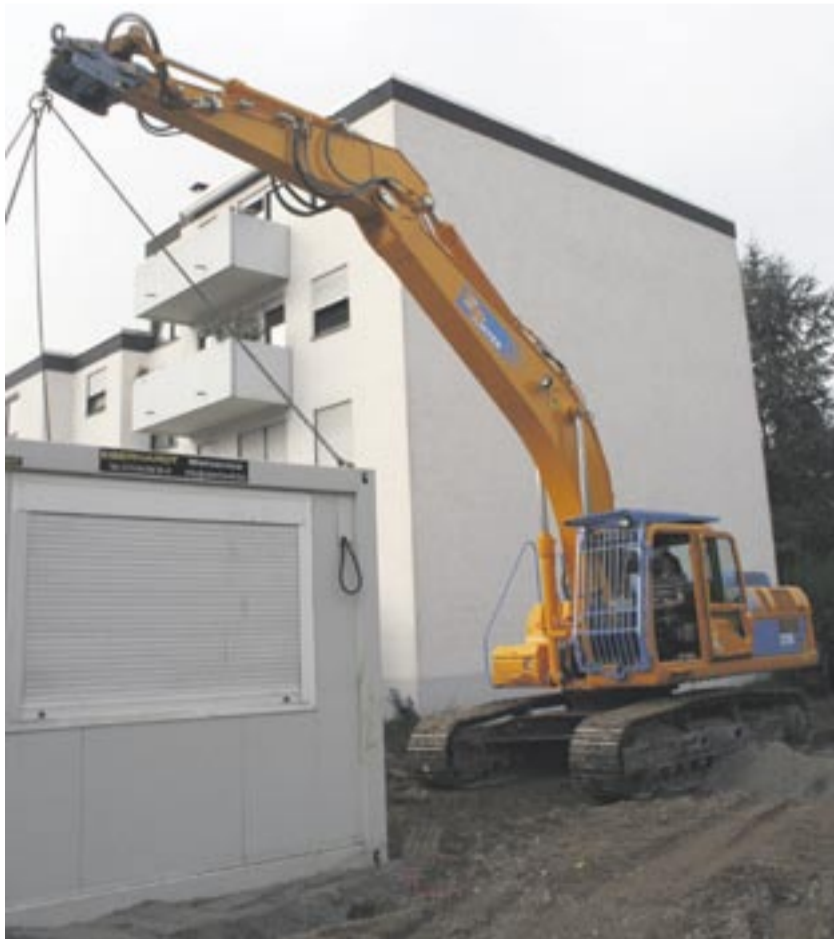
Der neue Cat Kettenbagger 329D LN hilft beim Einrichten einer Baustelle.
