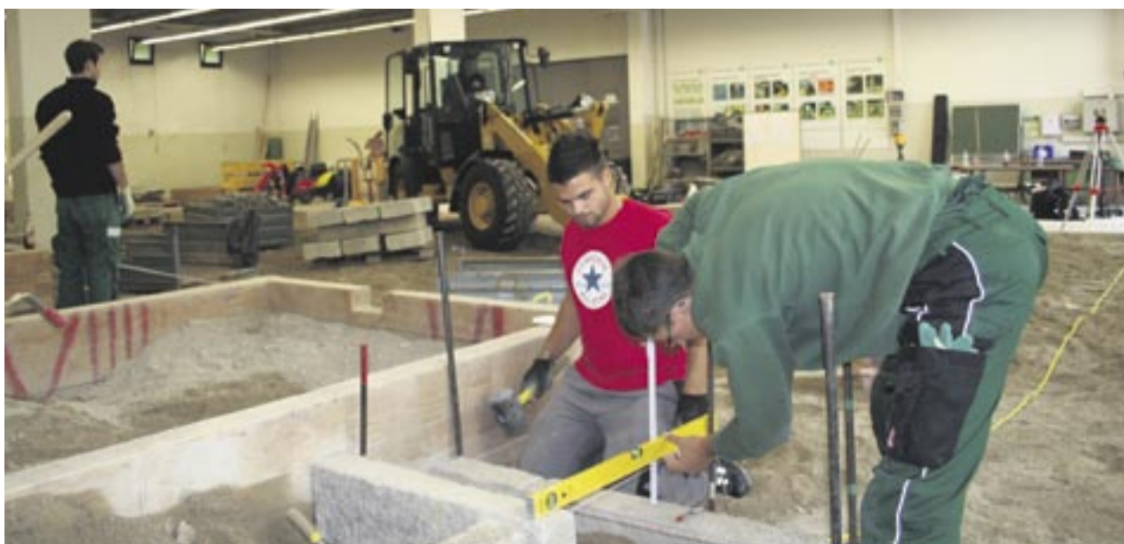
Unterstützt werden die angehenden Galabauer bei den unterschiedlichsten Arbeiten von den Cat Baumaschinen.
