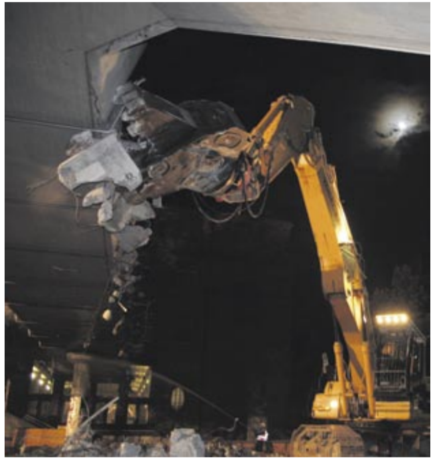
Knöpfte sich den Stahlbeton vor: der Cat 345BL.
