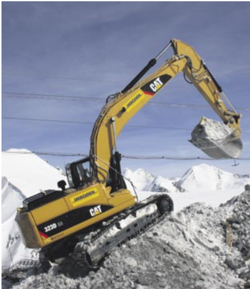
Baumaschineneinsatz 3 800 Meter über dem Meeresspiegel.
