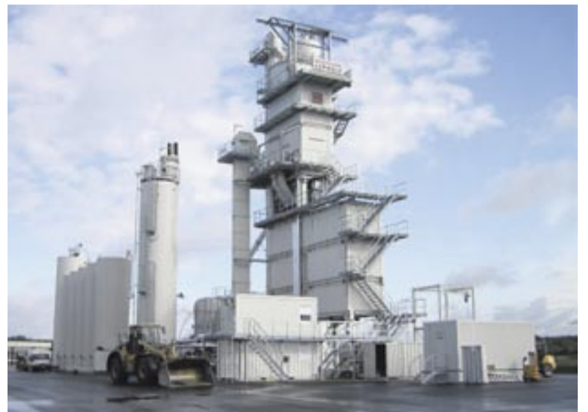
Innerhalb von vier Monaten wurden die neue Asphaltmischanlage in Ludwigsfelde errichtet.
