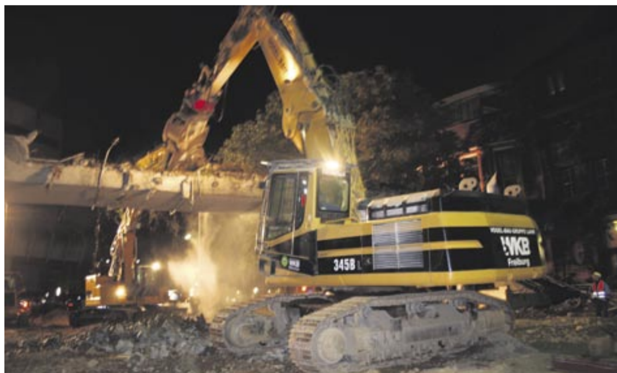
Von zwei Seiten aus beackerten Cat Maschinen samt Abbruchwerkzeuge wie Sortiergreifer und Schere die Brücke.
