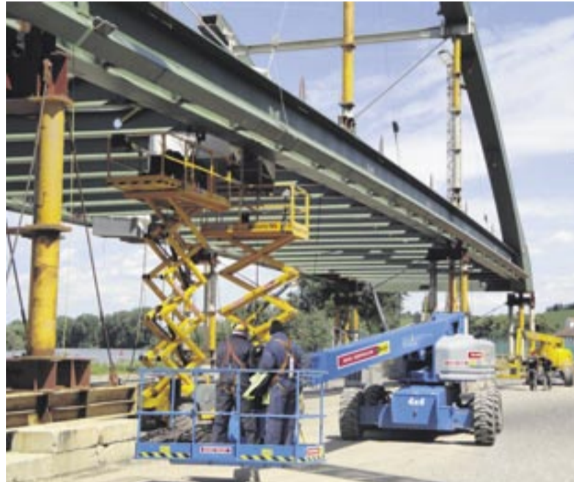
Effizienz in jeder Höhe – mit Scheren-, Teleskop- und Gelenkteleskopbühnen von MVS Zeppelin war die Donges SteelTec für sämtliche Montagearbeiten an der Mainbrücke bestens ausgerüstet. Foto: MVS Zeppelin
