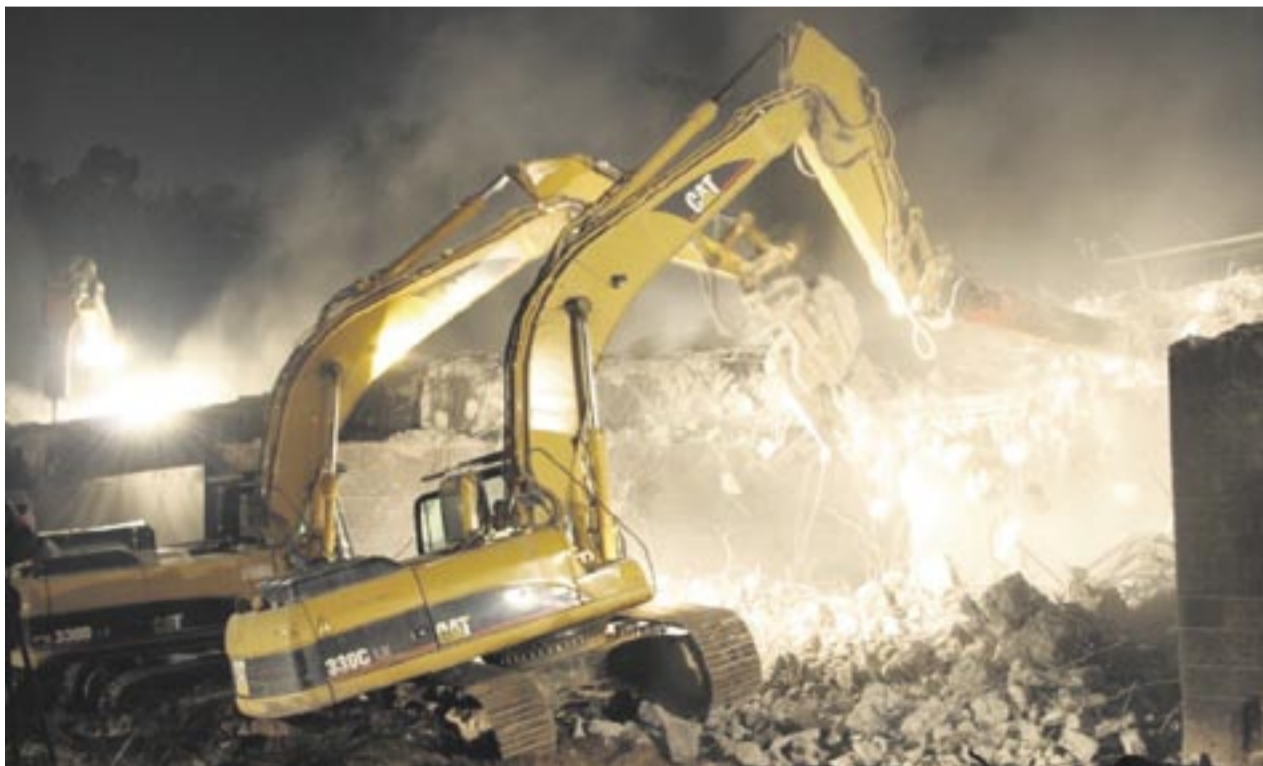
Nachtschicht ist angesagt, wenn es an die Brückenüberführungen geht.
