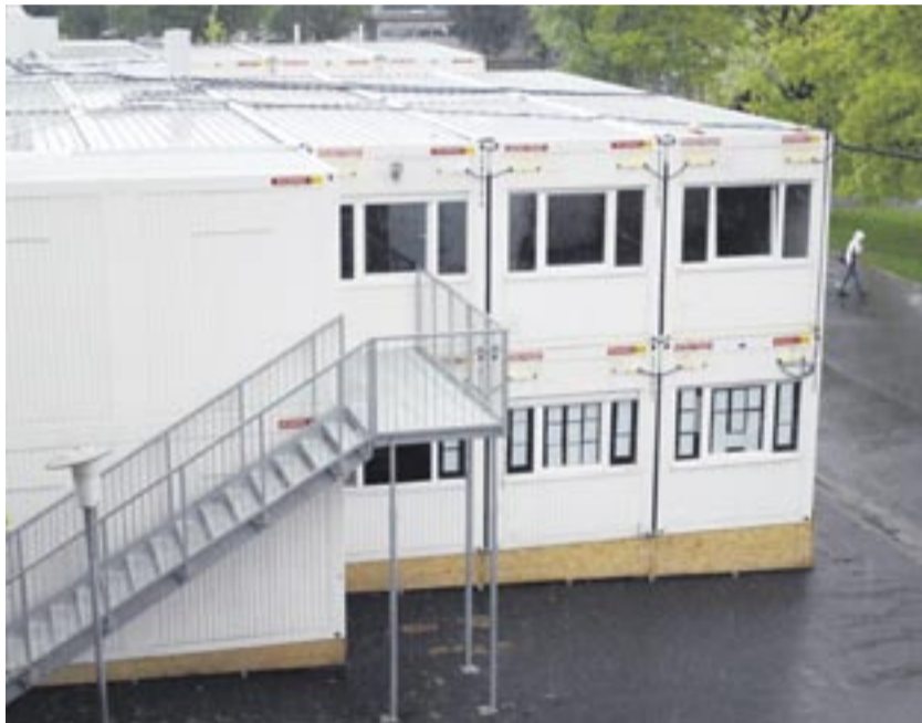
Mit den „mobilen Klassenzimmern“ wird der Schulbetrieb an der Theo-Koch-Schule in Grünberg trotz Sanierungsarbeiten gewährleistet. Fotos: MVS Zeppelin
