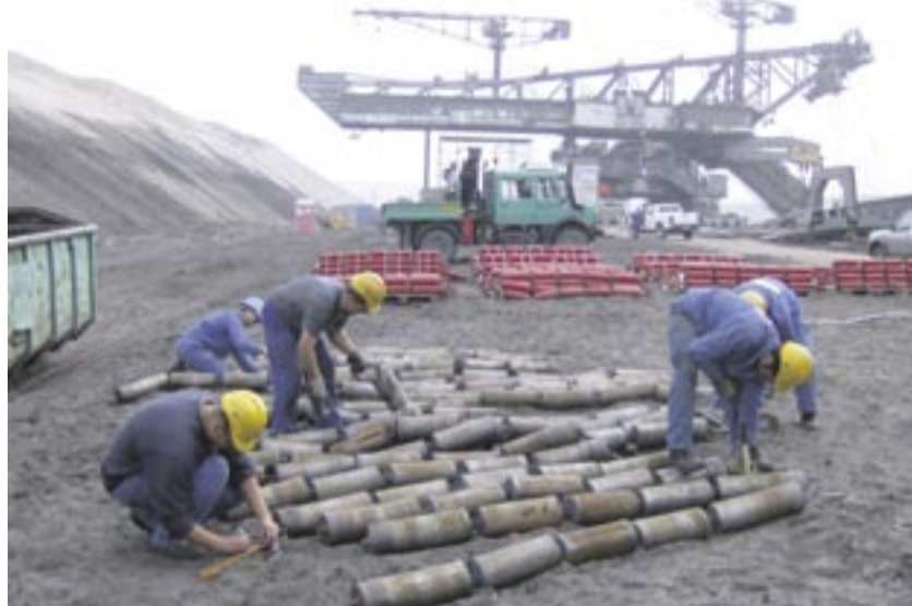
Die Abteilung Projekte Tagebau der GMB bietet ihren Kunden die Ausführung bergtechnischer Aufgabenstellungen an, wie zum Beispiel das Wechseln der Obertrumtragrollen am Oberen Zubringer der Abraumförderbrücke F60 im Tagebau Nochten. Foto: Gesellschaft für Montan- und Bautechnik mbH, Senftenberg
