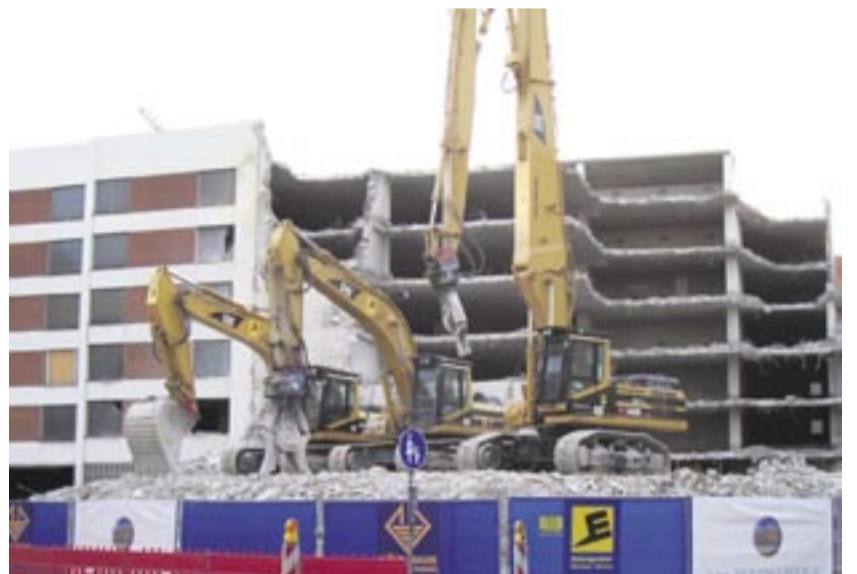
Innerstädtische Abbrüche sind die Spezialität von Ettengruber, wie hier am Oberanger in München, wo 85 000 Kubikmeter umbauter Raum abgebrochen wurde.
