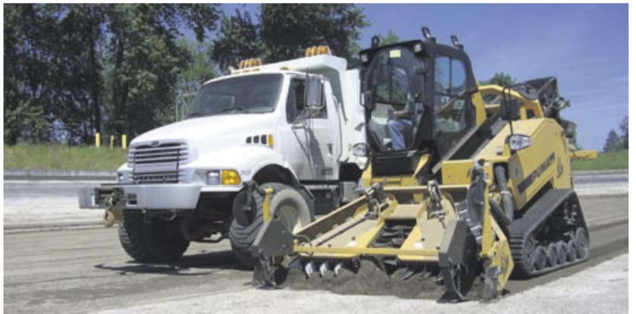
Die Puma 2400 bei ihren ersten Arbeiten in Oregon.
