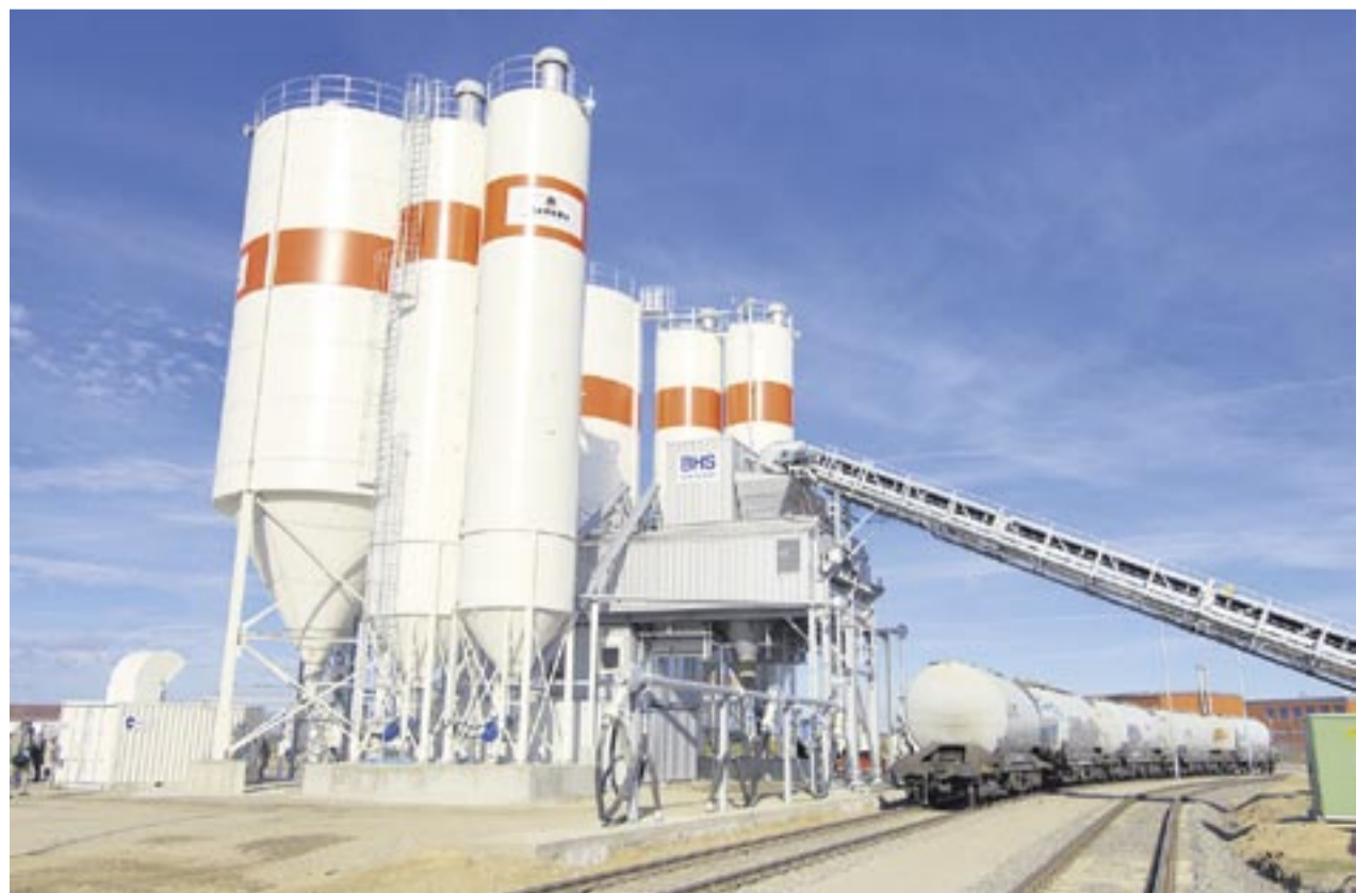
Fotos (5): Zeppelin Europas modernstes Betonwerk am BBI.
