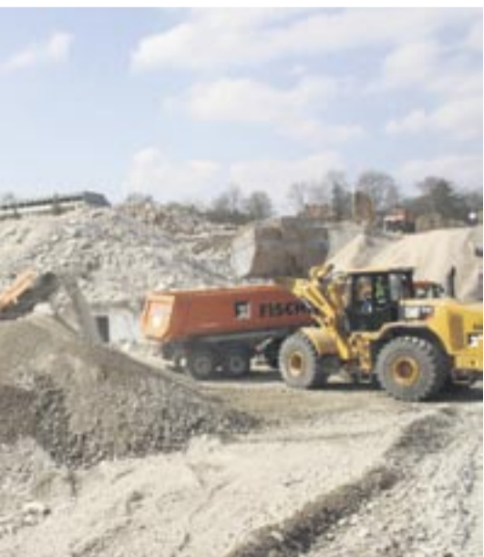
Abbrüche, wie etwa der Abbruch der neun alten Messegebäude sowie zwei Cat Longfrontbagger 365B und 330D, ein Cat Mobilbagger M318D, sowie Radlader Cat 966H und Cat Kettenlader 963C zur Seite.
