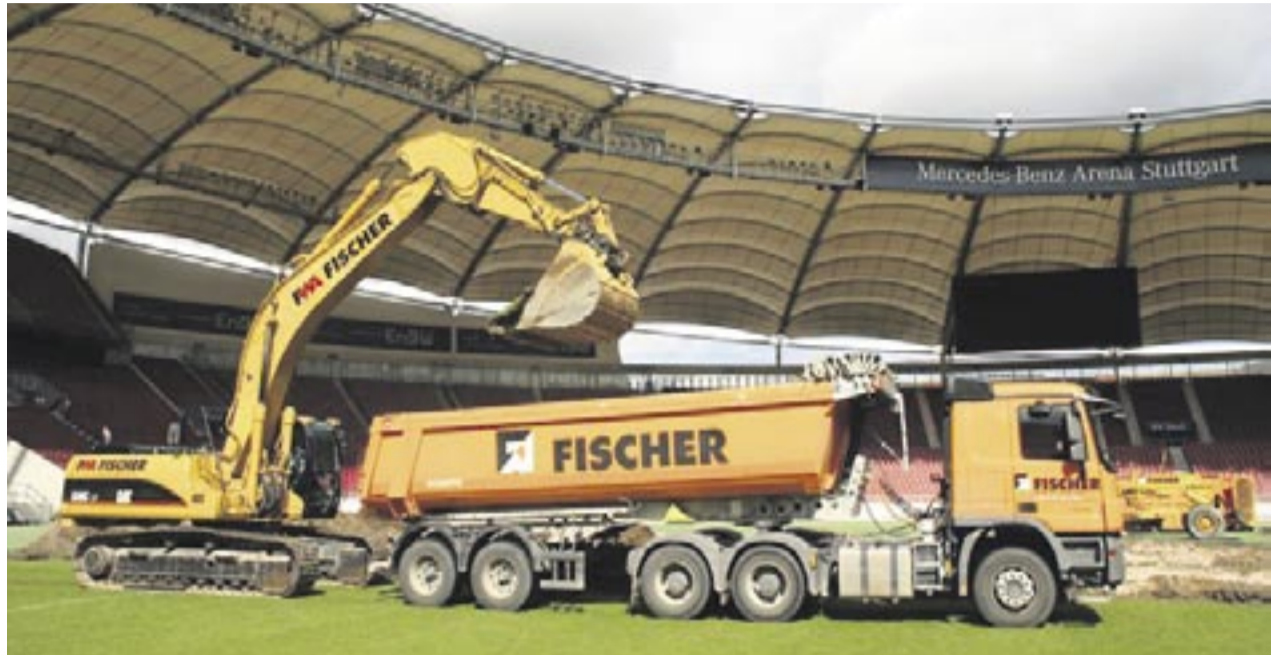
Hohe Anforderungen stellt derzeit die Tieferlegung des Spielfeldes in der Mercedes-Benz-Arena in Stuttgart.
