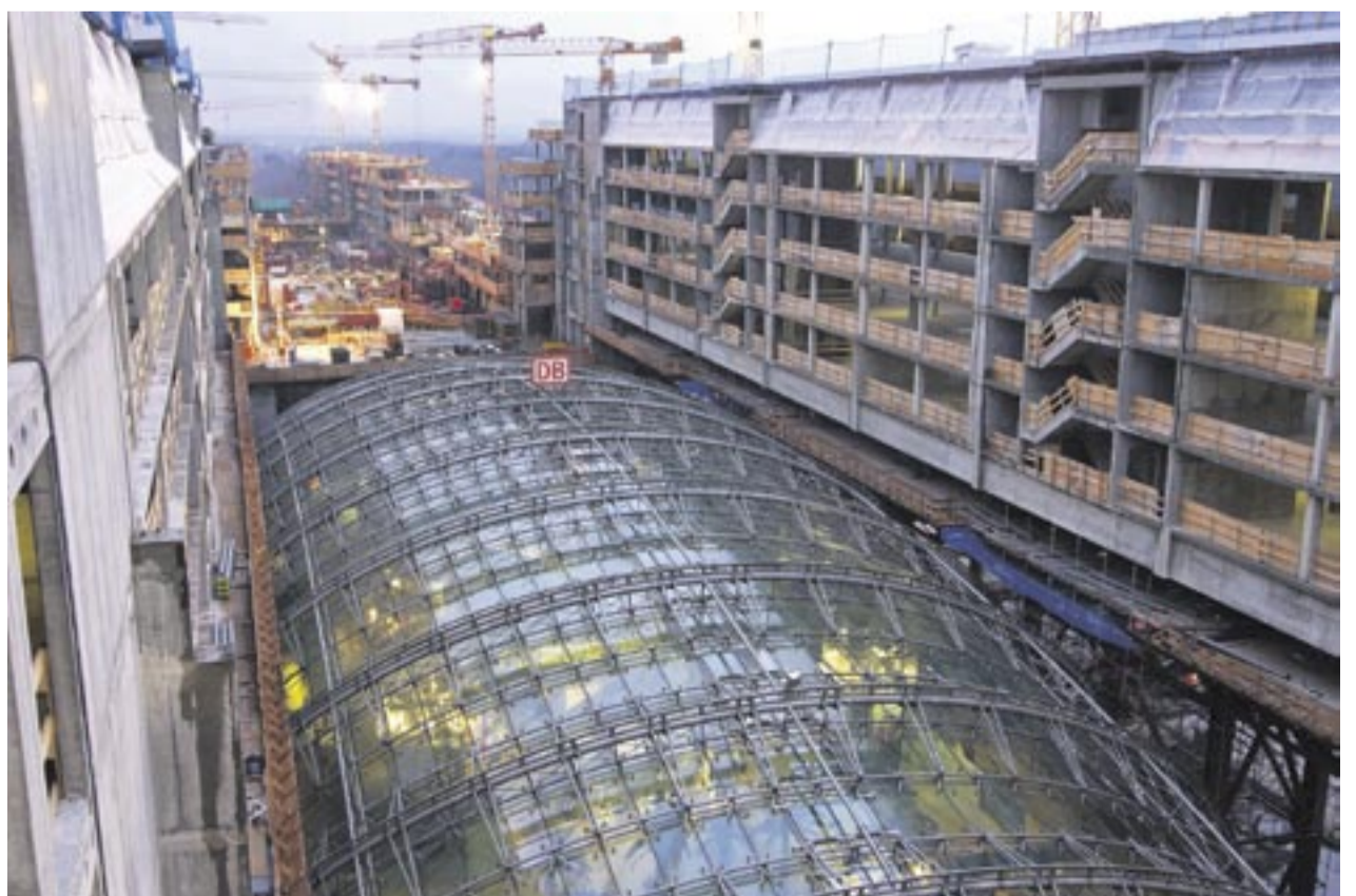
Blick auf die Halle des Fernbahnhofs Frankfurt Flughafen. Während oben gebaut wird, läuft unten der Bahnbetrieb unbeirrt weiter. Das bestehende Glasdach bleibt erhalten und wird in den Neubau integriert.
