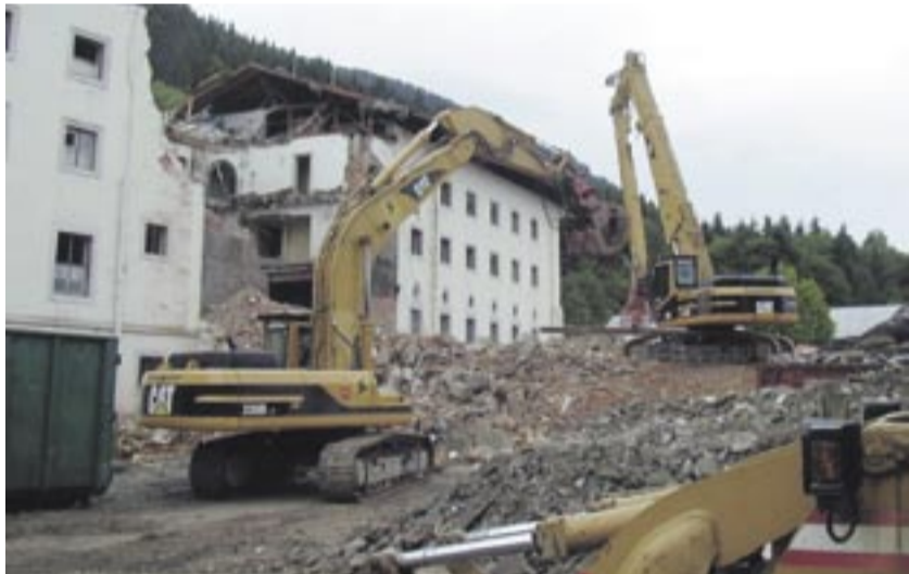
Die Herausforderungen im Abbruch, wie beim Hotel Platterhof am Obersalzberg Berchtesgaden, wurden mit Cat Maschinen gemeistert.
