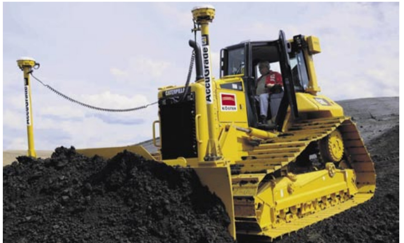
Cat Dozer D6N mit AccuGrade beim Abdichten der Sonderabfalldeponie in Leverkusen-Bürrig. Foto: Zeppelin/ Oliver Andres
