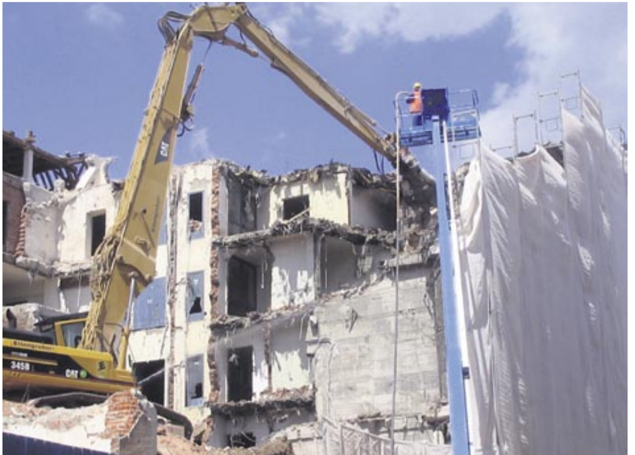
Sauberkeit auf den Baustellen und bei den eingesetzten Baumaschinen: Bei innerstädtischen Abbrucharbeiten wird stets darauf geachtet, die Staubentwicklung mittels Wasser und einer Einhausung einzudämmen.
