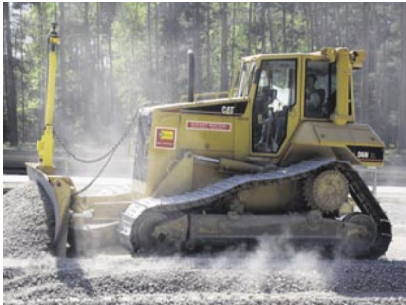
Präzision und Effizienz – Mit Hilfe der intelligenten ATS-Steuerung AccuGrade kann der Cat Dozer D6N XL von MVS Zeppelin die Schottertragschicht millimetergenau einbauen. Foto: MVS Zeppelin
