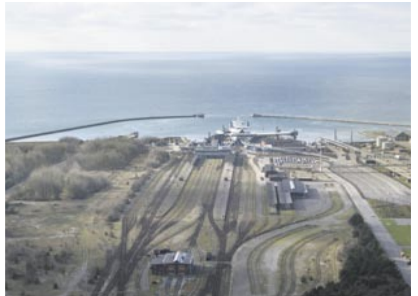
Bestehender Bahnterminal und Fährhafen im dänischen Rødby.
