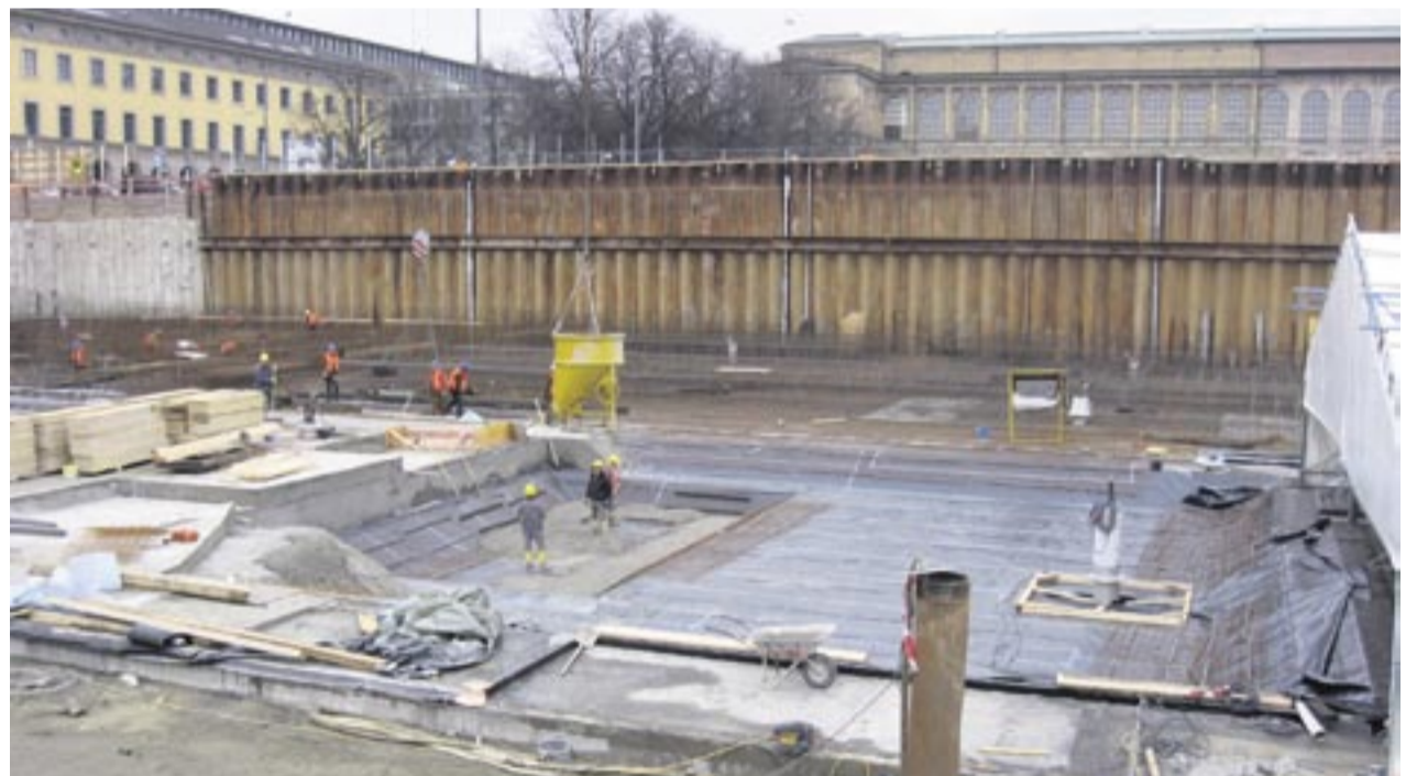
Alle Außenwände wurden je nach Beanspruchung fachgerecht abgedichtet.
