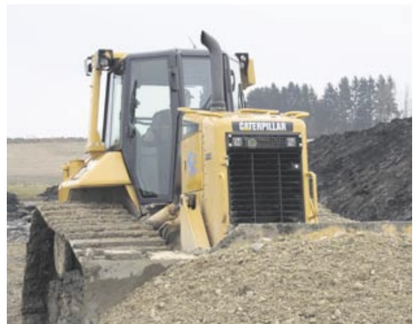
Einer der drei Cat Dozer beim Herstellen des Planums für den Teilabschnitt der neuen Isental-Autobahn.
