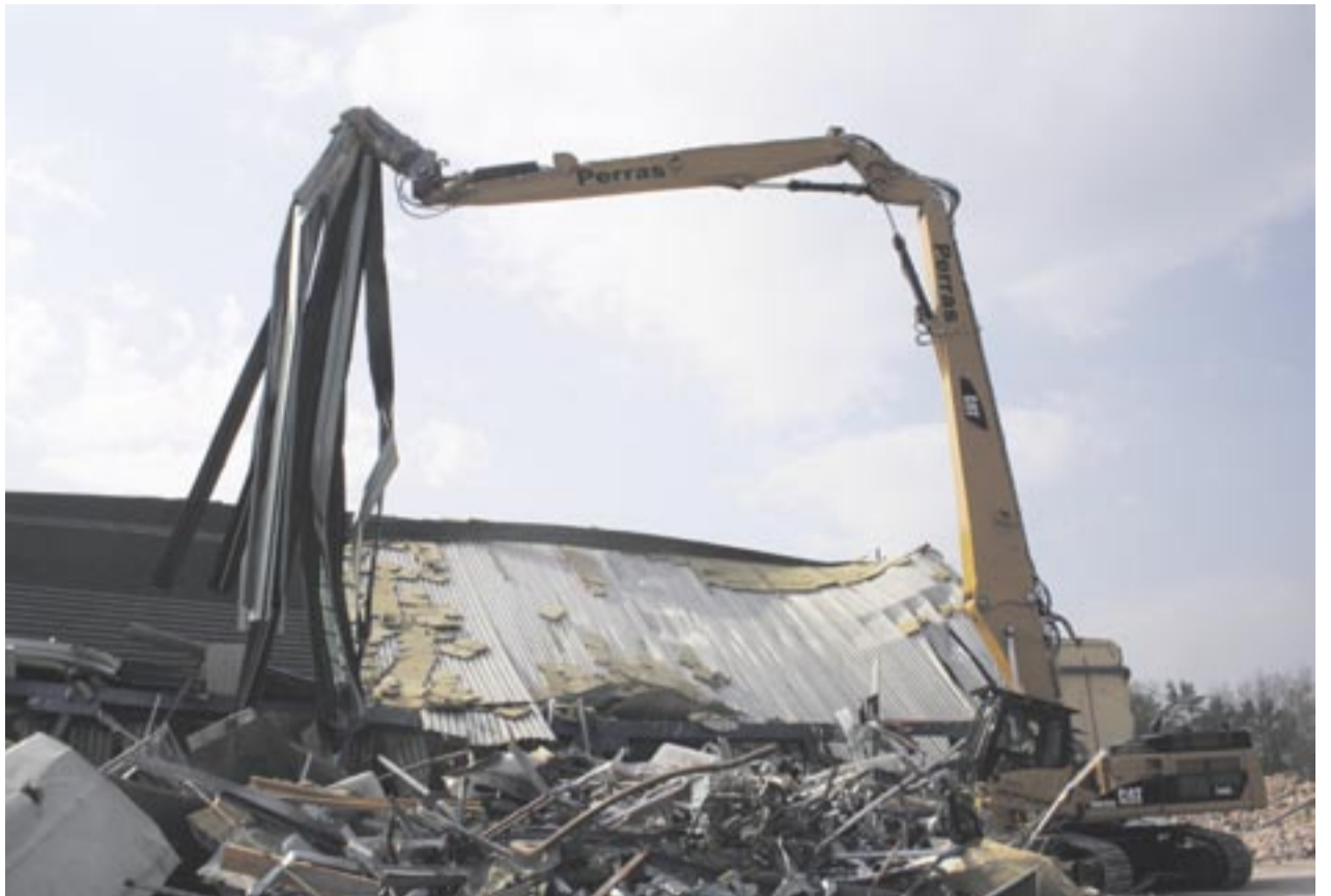
Aus der Halle schneidet der Cat Longfrontbagger 345 CL UHD mit seiner Schrottschere Stück für Stück der verbauten Materialien.
