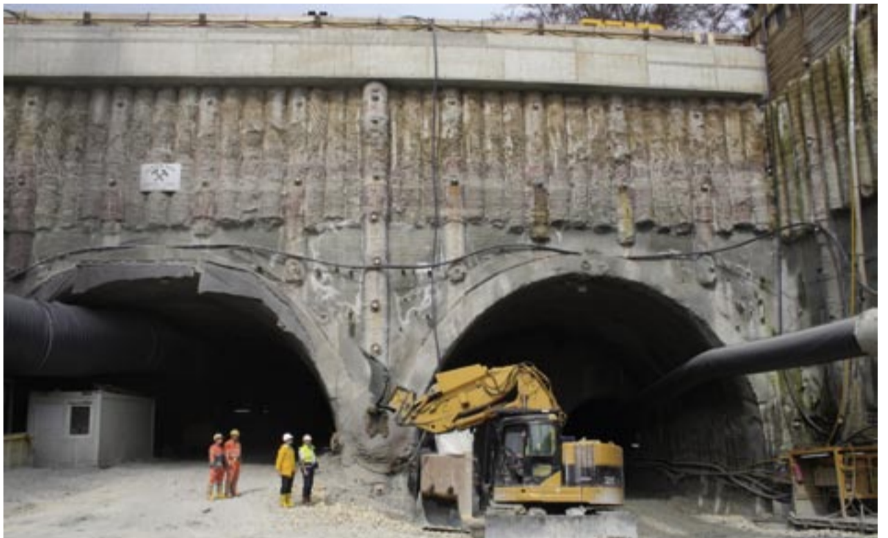
Links der 1 685 Meter lange Haupttunnel, rechts der Rettungstollen.
