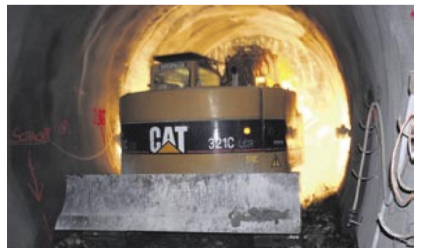
Gerade einmal ein 20 Quadratmeter großer Querschnitt bleibt dem Cat Tunnelbagger 321C LCR im Rettungstollen, um das Material zu lösen. Fotos: Zeppelin
