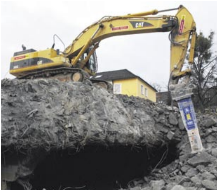
Schweres Gerät zur Miete: Der Cat 345C L von MVS Zeppelin rückt der meterdicken Betondecke des Bunkers zu Leibe. Foto: MVS Zeppelin
