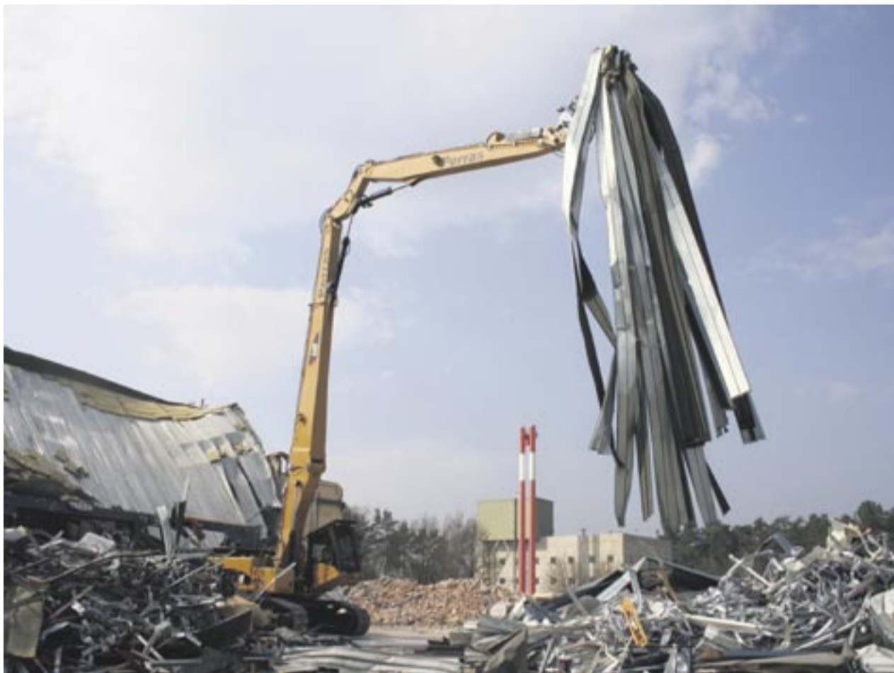
Auf der Baustelle in Roth wird mit dem Cat 345 CL UHD der Schrott mehrere Sekunden lang in der Luft balanciert, bis er auf dem Boden abgelegt wird.
