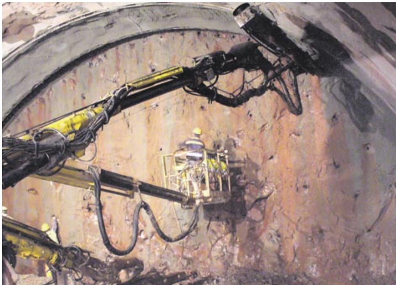
Vortriebsarbeiten im Tunnel.
