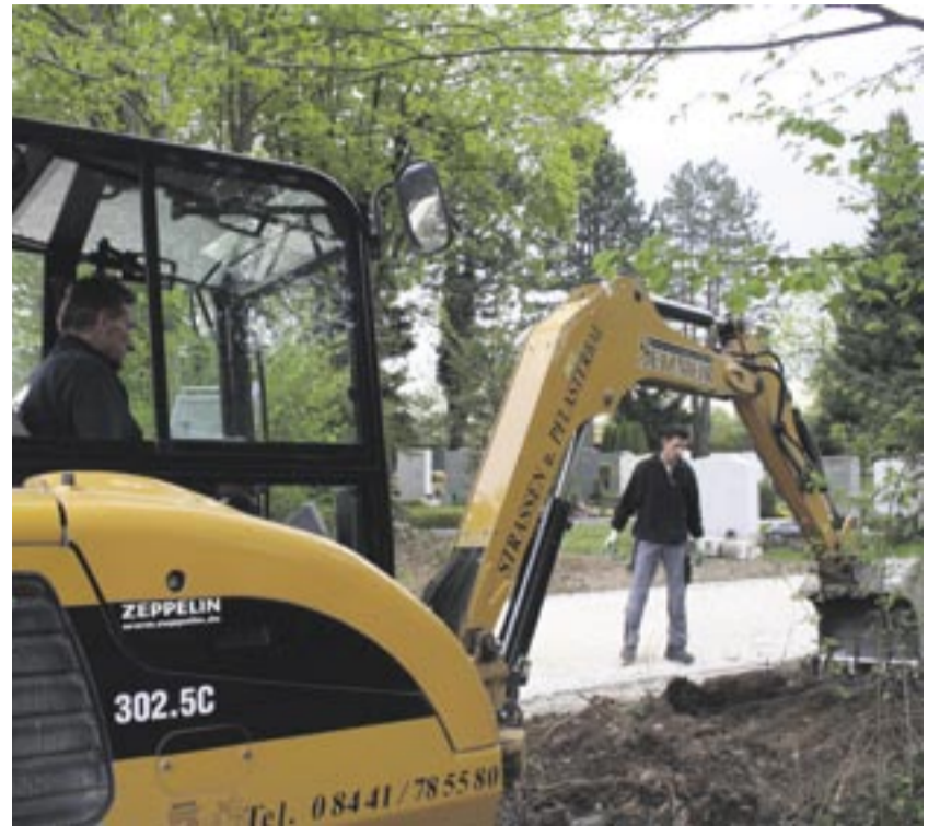
„Gerade dort, wo es eng war, war der Cat Minibagger gefragt, weil er besser in die Ecken kommt“, meint der Polier Harald Seger. Fotos: Zeppelin
