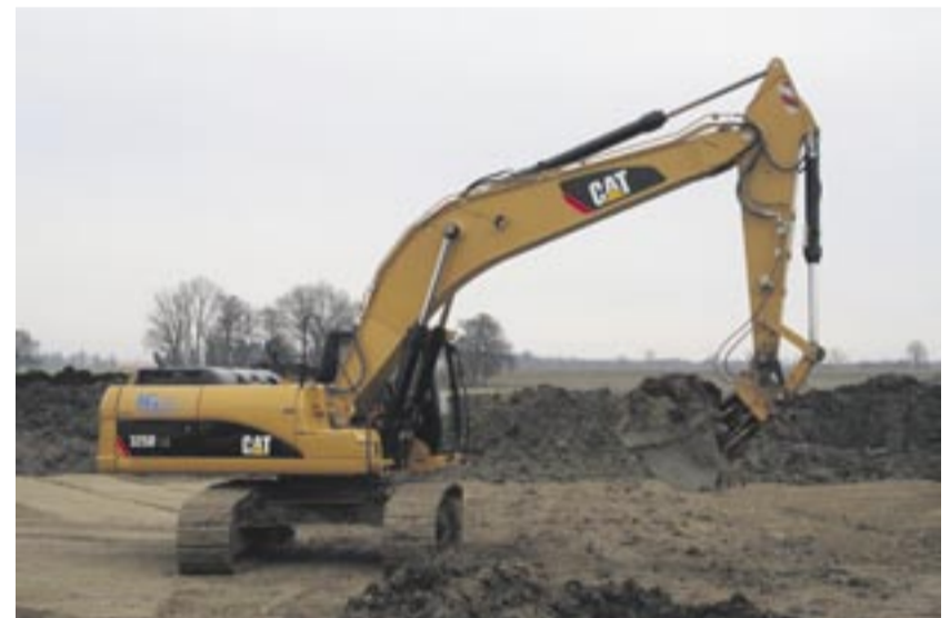
Der Cat 325 D beim Abtragen des Oberbodens.
