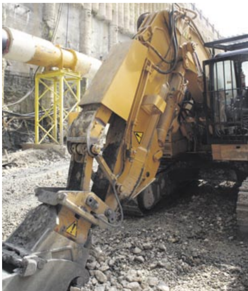
Angepasst an die Einsatzbedingungen im Tunnel haben Servicemitarbeiter von Zeppelin den Ausleger des Tunnelbaggers.
