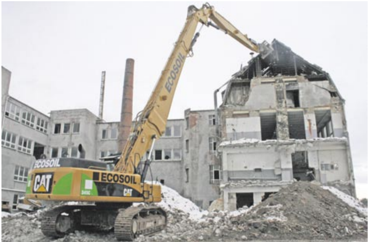
Mit seinem 28 Meter langen Ausleger erreicht der Cat Longfrontbagger die Firsthöhe von 22 Meter problemlos.
