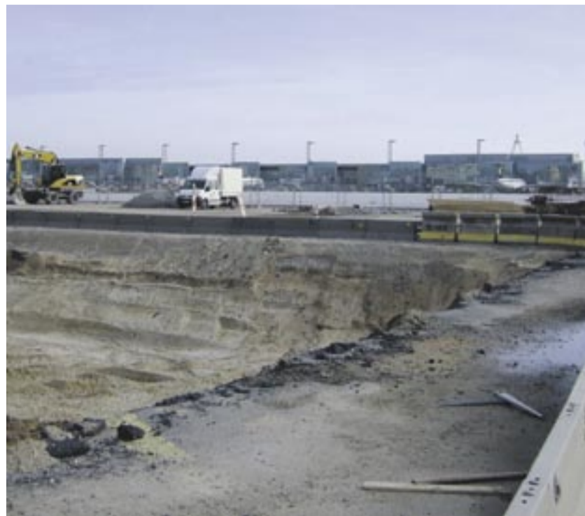
Nur wenige Meter und ein Bauzaun trennen die Baustelle vom Vorfeld des Frankfurter Flughafens. Dies bringt besondere Sicherheitsauflagen mit sich, die Streif Baulogistik bei der Einrichtung und Koordination der Baustelle berücksichtigen muss. Foto: Streif Baulogistik
