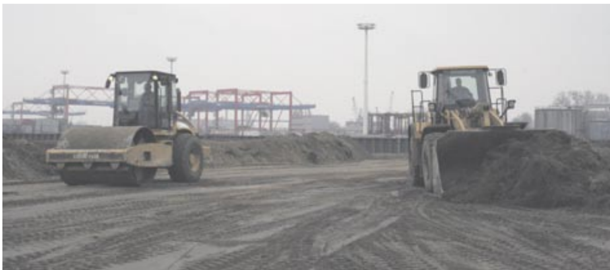
Mit dem Cat Radlader 966H wird die Baugrube wieder verfüllt und mit dem Cat Walzenzug CS 563E verdichtet.
