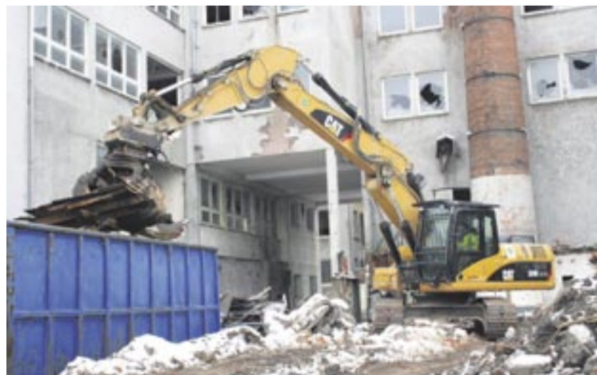
Knöpft sich das Holz vor, das in dem Jäckle-Gebäude verbaut wurde: der Cat Kettenbagger 324D. Fotos: Zeppelin
