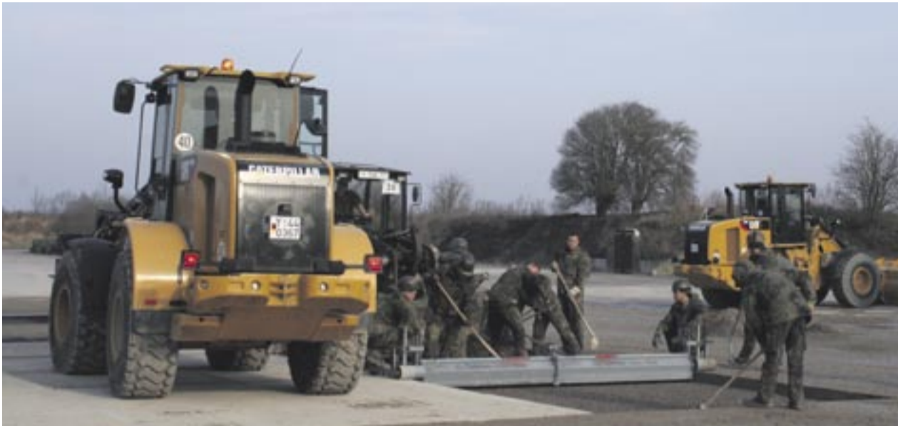
Sollen beschädigte Verkehrsflächen instand setzen: die neuen Cat Radlader 930H.
