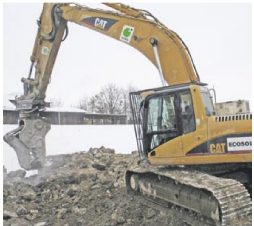
Erledigt die Feinarbeit und knackt den Stahlbeton: der Cat Kettenbagger 330C.
