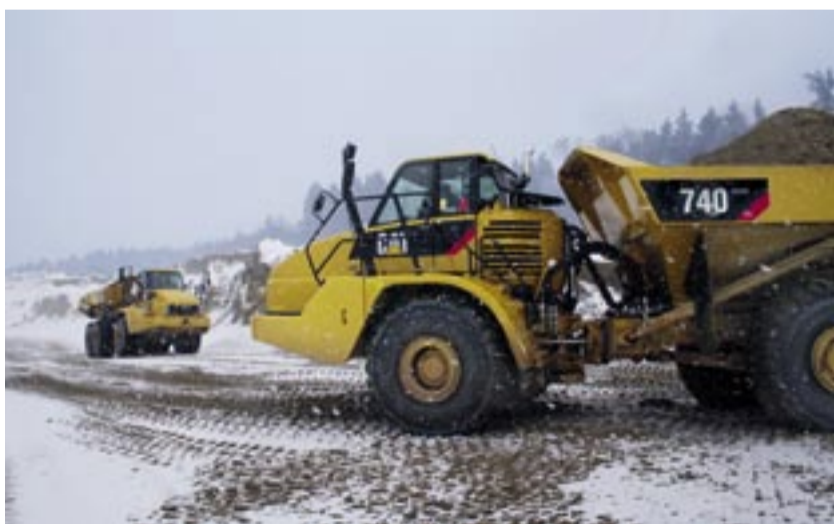
Trotz dichtem Schneefall kann der Rohkiestransport mit den beiden neuen Cat Dumpfern 740 bei der Nord-Moräne auch im Winter reibungslos erfolgen.
