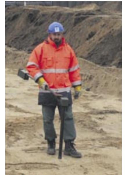
Mit einem Metalldetektor untersucht ein Mitarbeiter das Baufeld nach Kampfmitteln.
