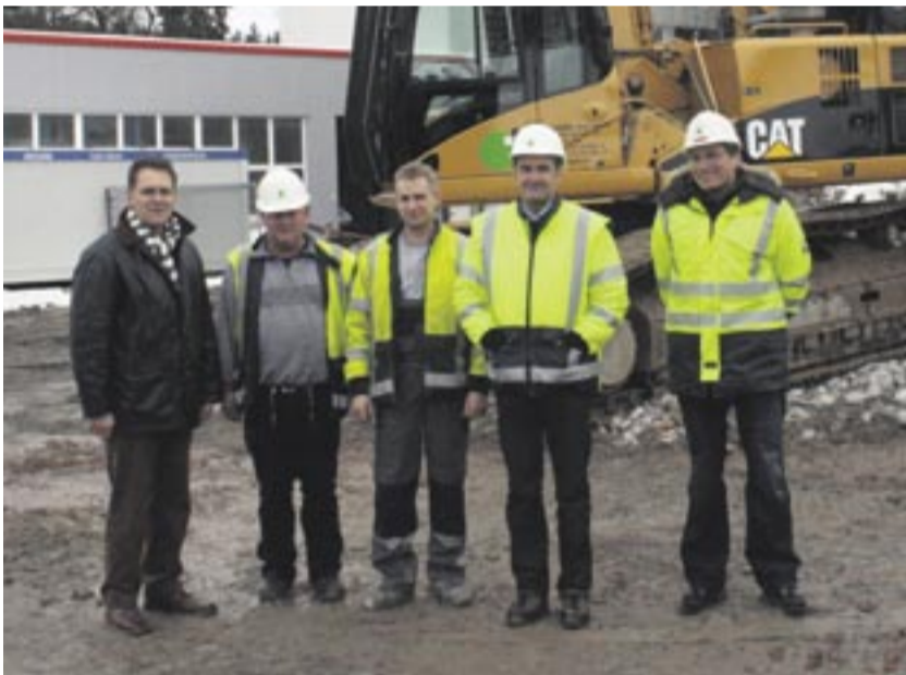
Informierten sich über die komplexen Rückbauarbeiten (von links): Ulrich Barth, Zeppelin Verkaufsleiter Konzernkunden, Volkhard Gessner, Polier, Dirk Blokesch, Fahrer des Abbruchbaggers, Albrecht Rempis-Wandrey, Geschäftsbereichsleiter von Ecosoil Süd GmbH und Bernd Schober, Bauleiter.
