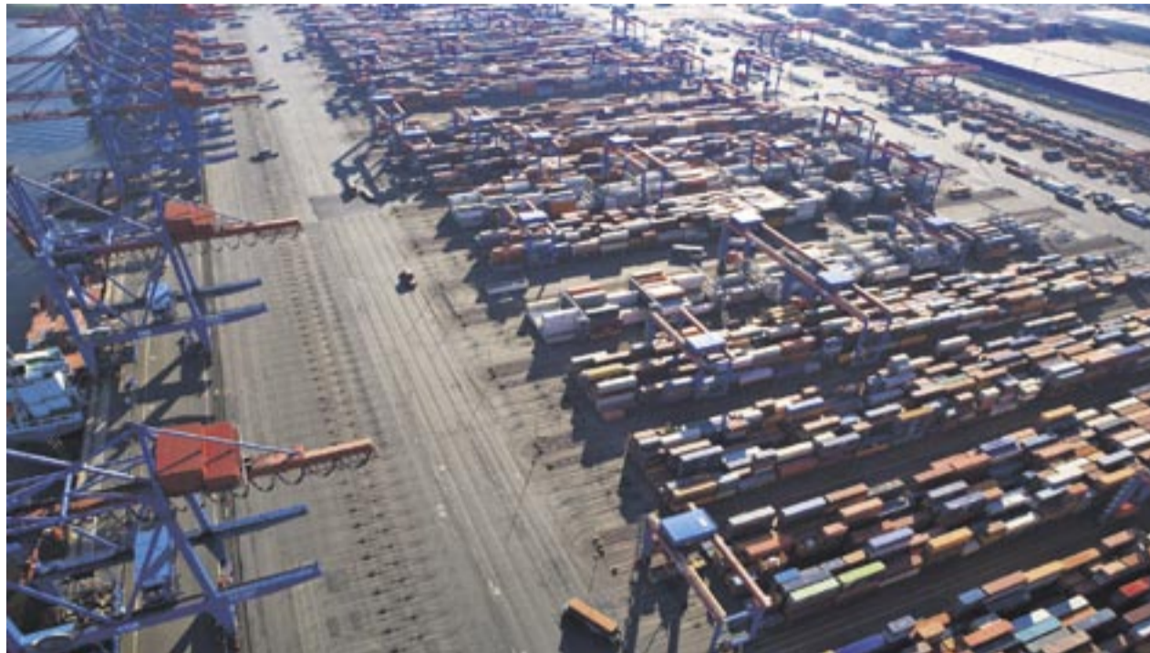
Der HHLA Container Terminal Altenwerder (CTA) gilt weltweit als einer der modernsten Containerterminals.
