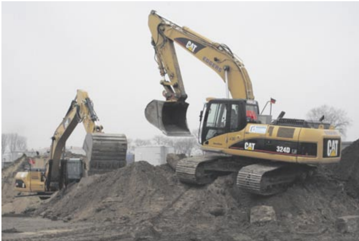
Schicht für Schicht tragen die beiden Cat Kettenbagger 324D LN das Erdreich ab.
