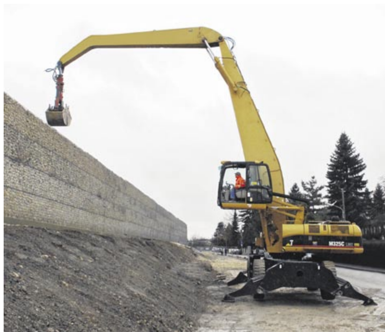
Spezialtechnik im Einsatz: Erst der Cat M325C LMH mit Industriestiel und Greifer macht das Befüllen der vierten Gabionenschicht möglich. Foto: MVS Zeppelin
