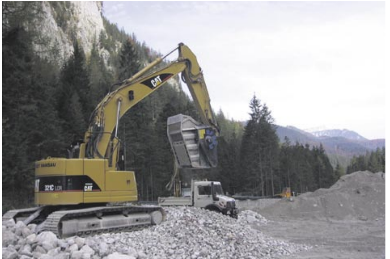
Mit seinem Backenbrecherlöffel zerkleinert der Cat Kurzheckbagger 321CLCR das Geröll in Korngrößen von 120 Millimeter.
