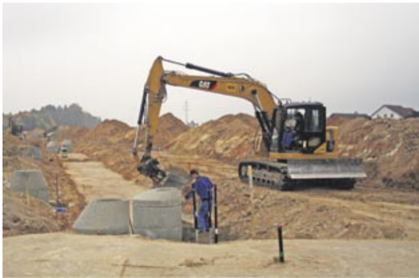
Derzeit erschließt die Hans Münnich Bau GmbH & Co. KG ein 70 000 Quadratmeter großes Baugebiet mit einer Flotte von Cat Maschinen.
