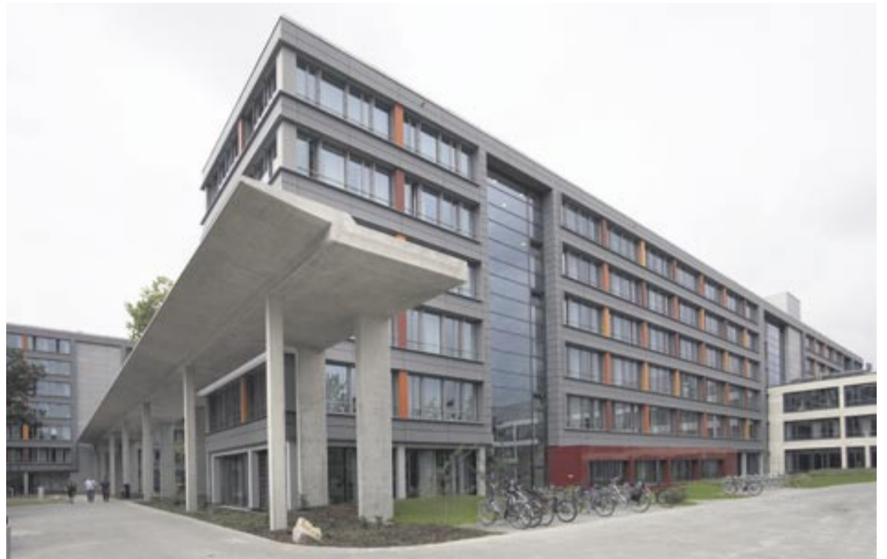
Der Neubau des Deutschen Wetterdienstes bietet Platz für 900 Mitarbeiter und den neuen Großrechner, mit dessen Abwärme das Gebäude beheizt wird. Foto: DWD
