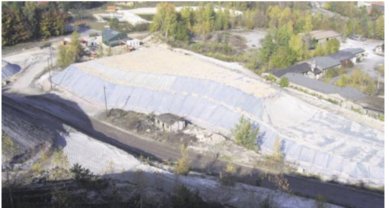
Betrieb des Zwischenlagers für die Deponieersatzbaustoffe.
