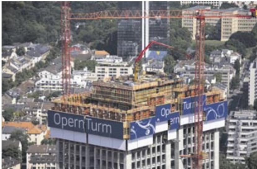
Die Selbstklettersysteme ACS und RCS bilden die Grundlage der maßgeschneiderten Peri-Schalung
