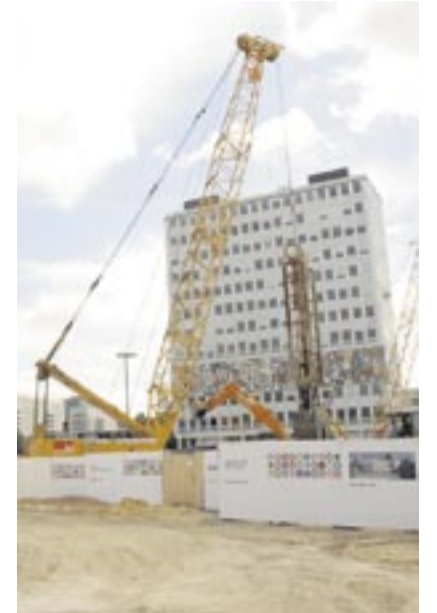
Baurechtler beraten ihre Mandanten während der gesamten Bauphase.
