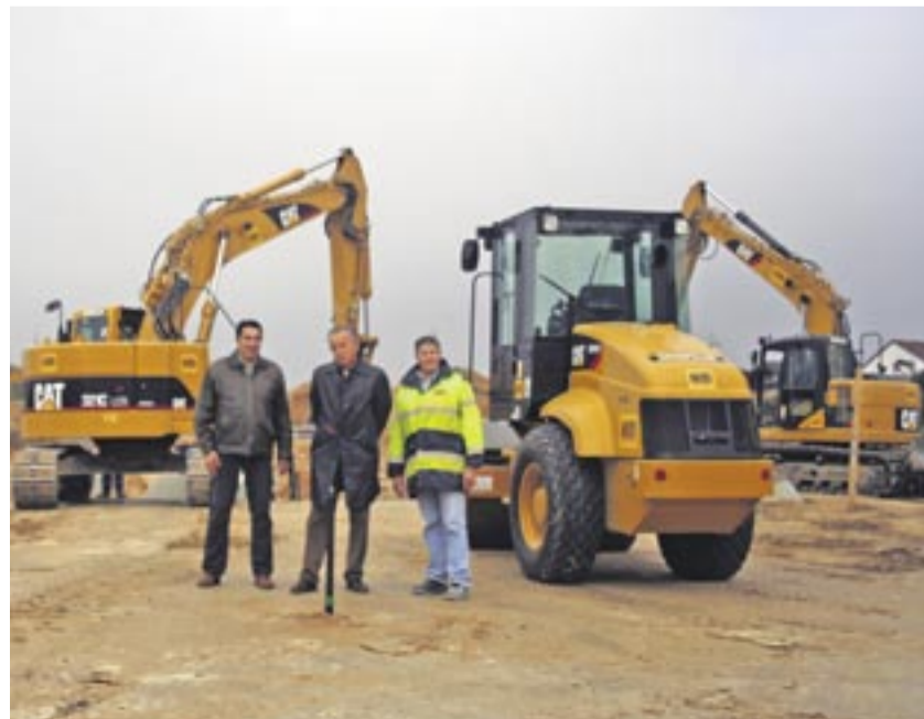
Setzen ausschließlich auf Cat Baumaschinen und das seit vielen Jahren: Geschäftsführer Hans Münnich (Mitte) sowie seine langjährigen Mitarbeiter Ralf Zahradnik, Bauleiter, (links) und Hans Birkenseer, Schachtmeister (rechts).
