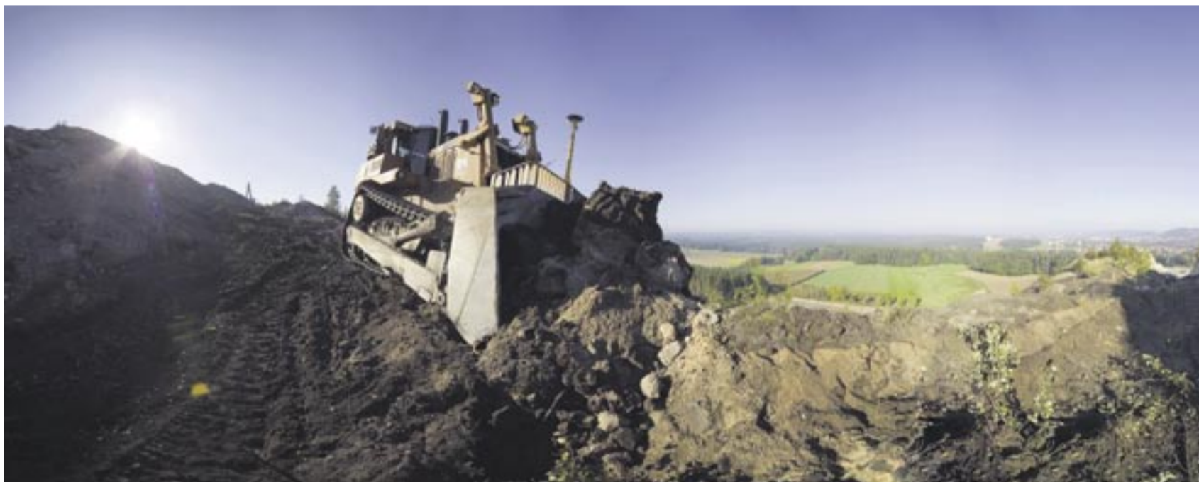
Lösen der verfestigten Schlacken mit einer Cat Raupe.
