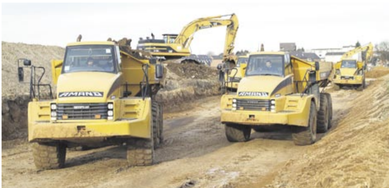
Amand erschließt das neue Stadtviertel mit Cat Baumaschinen.
