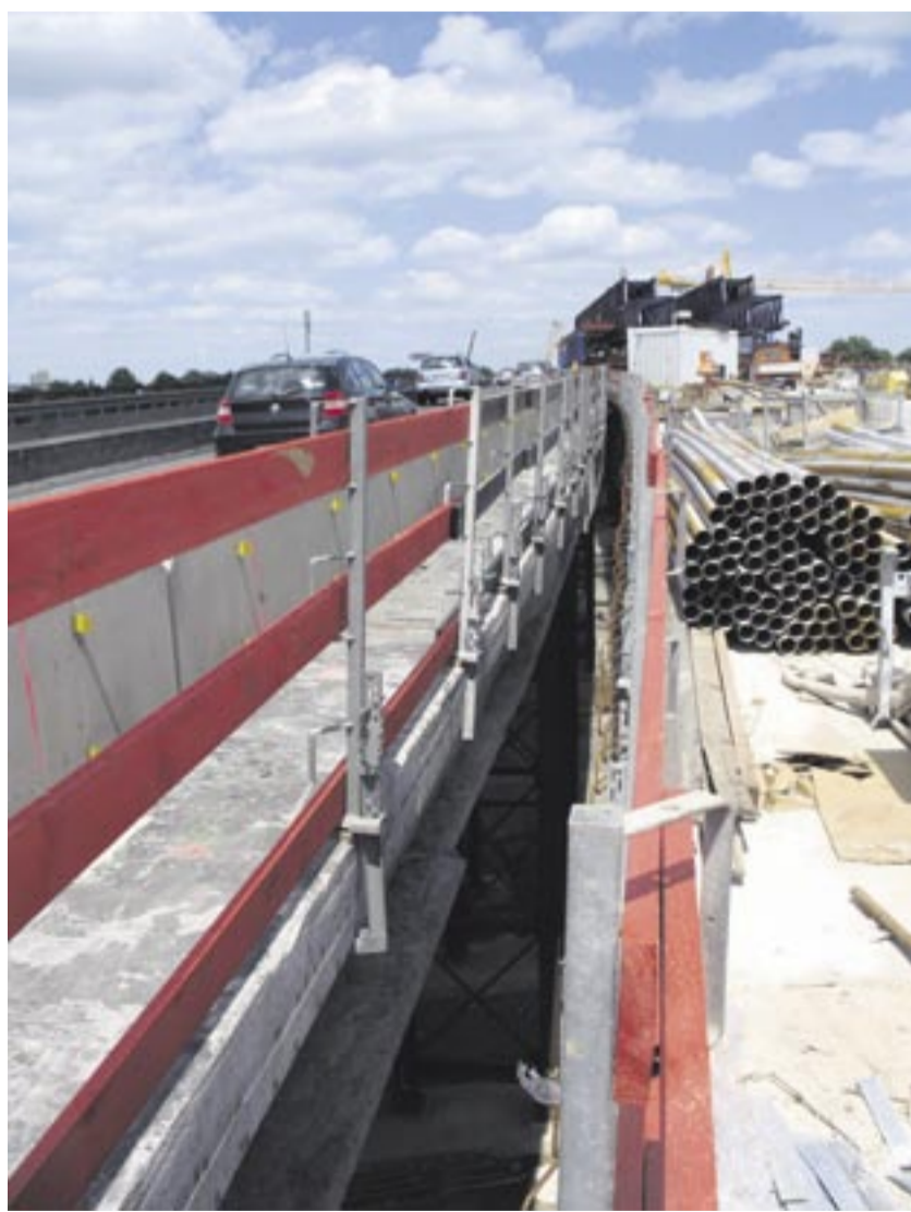
Eine Brückenhälfte bleibt befahrbar, während auf der Gegenseite Abbruch und Neubau beginnt.
