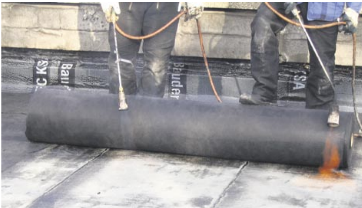
Einflämmen der elektrisch leitfähigen Kontaktlage.
