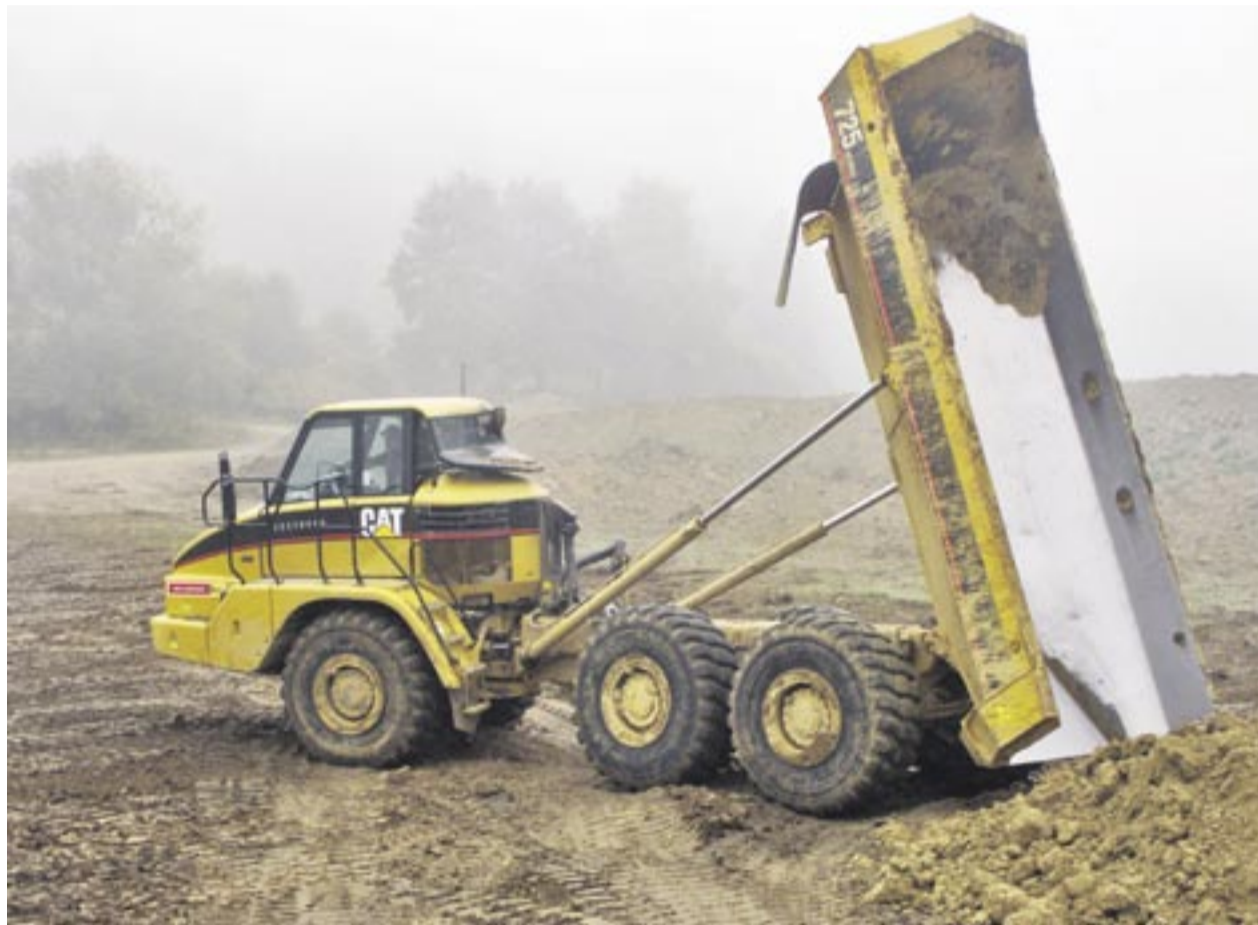
Die Halle drei des „Logistikparks Moosthenning“ ist gerade im Bau: Bis zu 14,3 Kubikmeter Muldeninhalt bewegen die beiden Cat Dumper 725 aus der Mietflotte von MVS Zeppelin pro Fahrt. Foto: MVS Zeppelin
