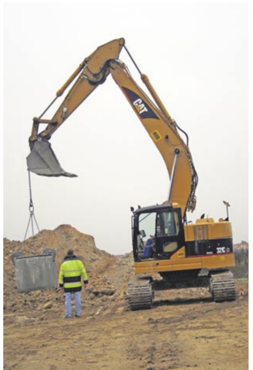
Inzwischen hat das Bauunternehmen seinen Maschinenpark auf Cat Kurzheckbagger umgestellt.
