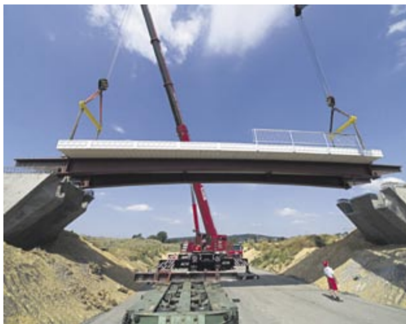
Innerhalb weniger Stunden wurde die fertig vormontierte Brücke per Kran auf die Fundamente gehoben. Foto: Hessisches Landesamt für Straßen- und Verkehrswesen
