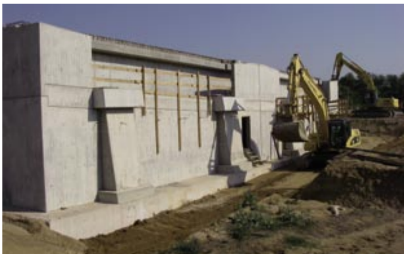
Kafril wurde mit dem Erdbau zu den Brückenbauwerken beauftragt.
