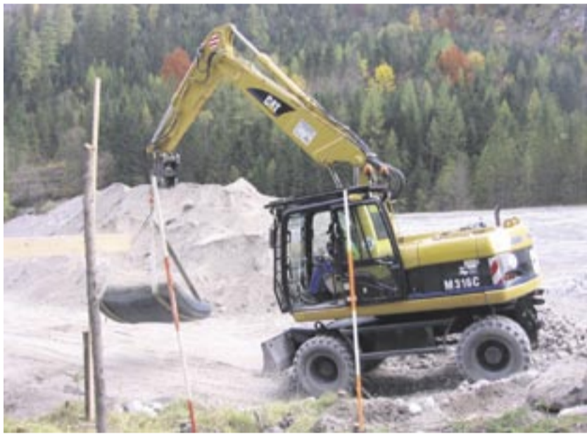
Der Cat Mobilbagger M316C transportiert das Material für die Gabione.
