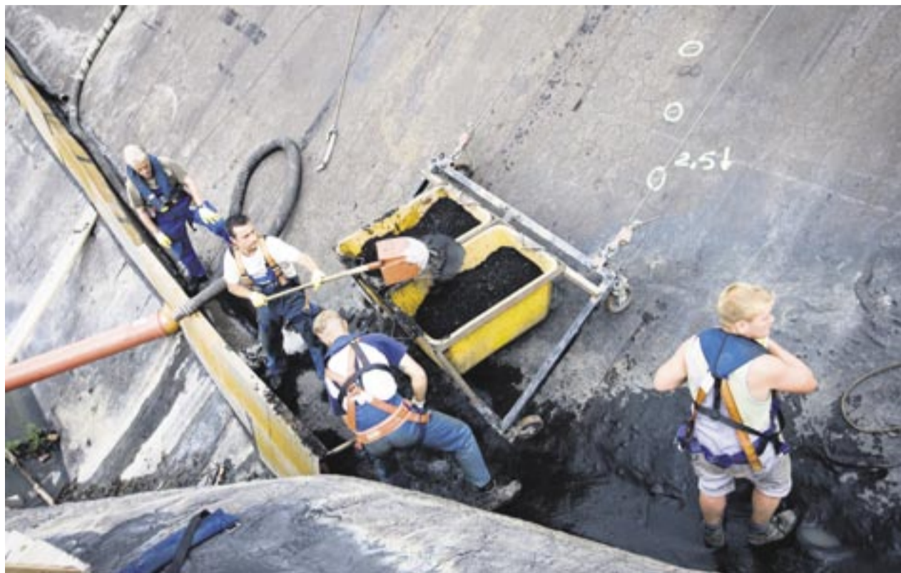
50 Jahre hielt die Außenhaut dicht, nun wurde sie einer Sanierung unterzogen.
