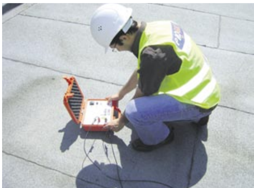
Dichtungskontrolle der Bitumenabdichtung mit dem Handprüfgerät.
