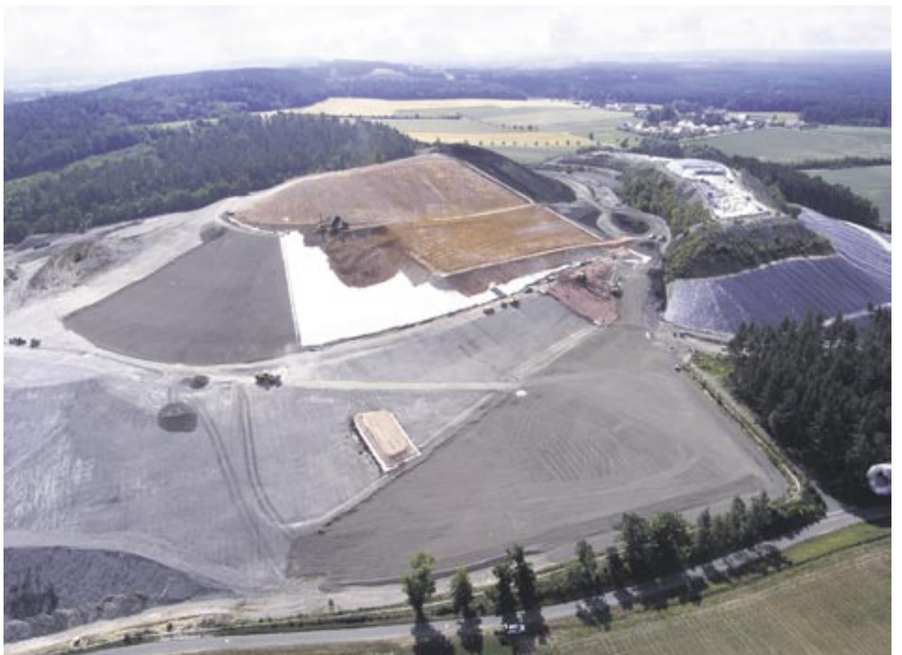
Sukzessiver Einbau der Dichtungselemente.
