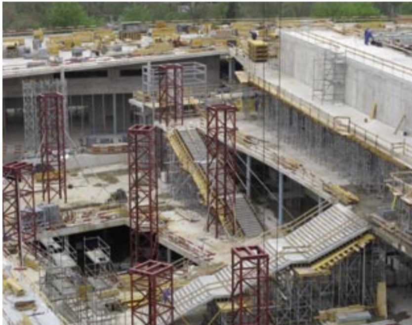
Bauteil A mit Treppen, im später mit einem stützenfreien Kristalldach überspannten Foyerbereich.
