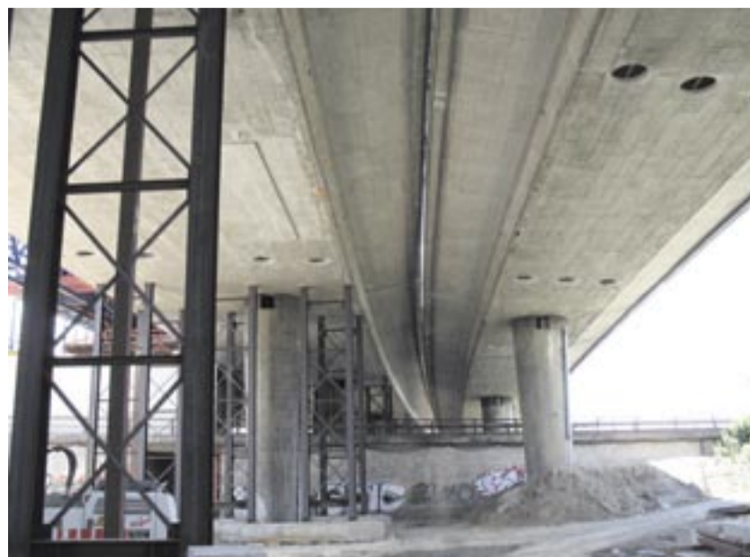
Das bestehende Bauwerk musste provisorisch unterstutzt und in zwei Hälften getrennt werden, um den Verkehrsfluss am Laufen zu halten.
