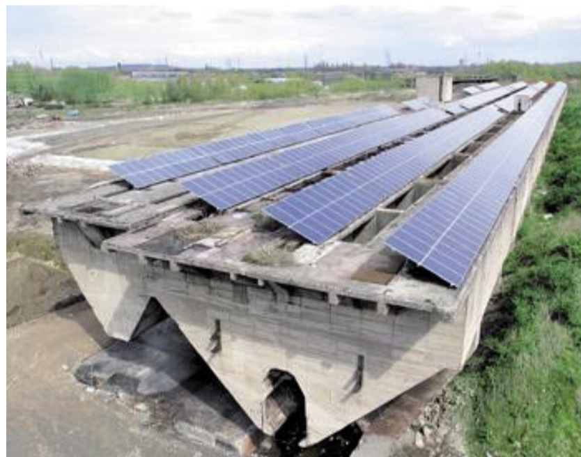
Vor den Solarmodulen klaffen die Einfüllöffnungen auf dem Dach des ehemaligen Erz- und Kohlebunkers Schalker Verein. Foto: Designfaktor
