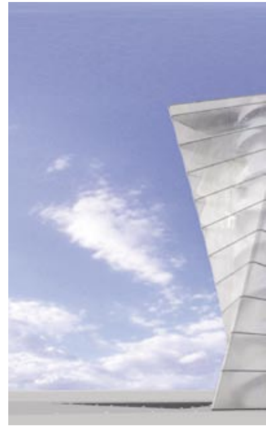
Der BBI-Infotower zeichnet sich durch eine ungewöhnliche Drehung der dreieckigen Grundform entgegen der konventionellen Perspektiven. Die Hülle besteht aus einer transparenten Membran, die tagsüber in blau-weiß bedruckt und präsentiert sich nachts mit Hilfe farbiger Leuchtdioden in eine eindrucksvolle Bauzeit ein sichtbares Symbol für den BBI sein.
