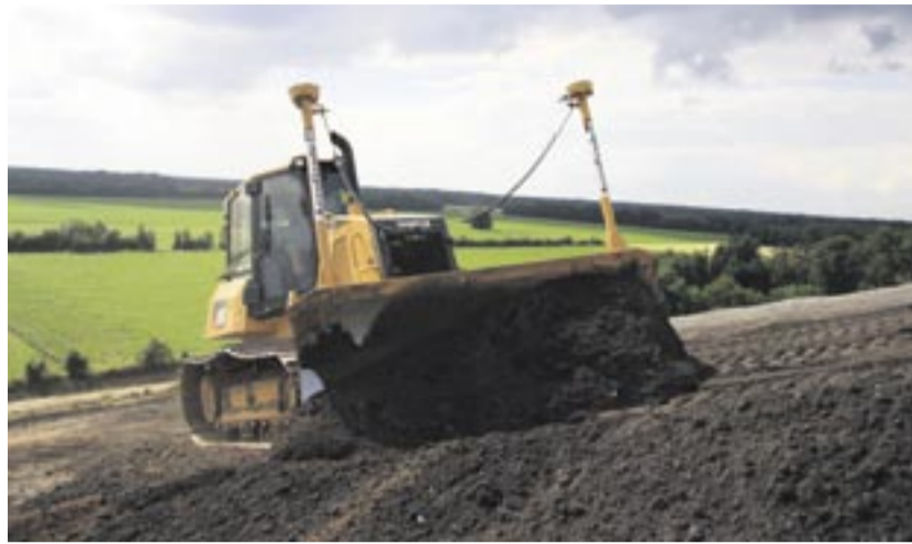
USG konnte mit dem Cat-Dozer D6K und der AccuGrade Dual-GPS-Steuerung schneller seine Arbeit erledigen. Foto: Zeppelin
