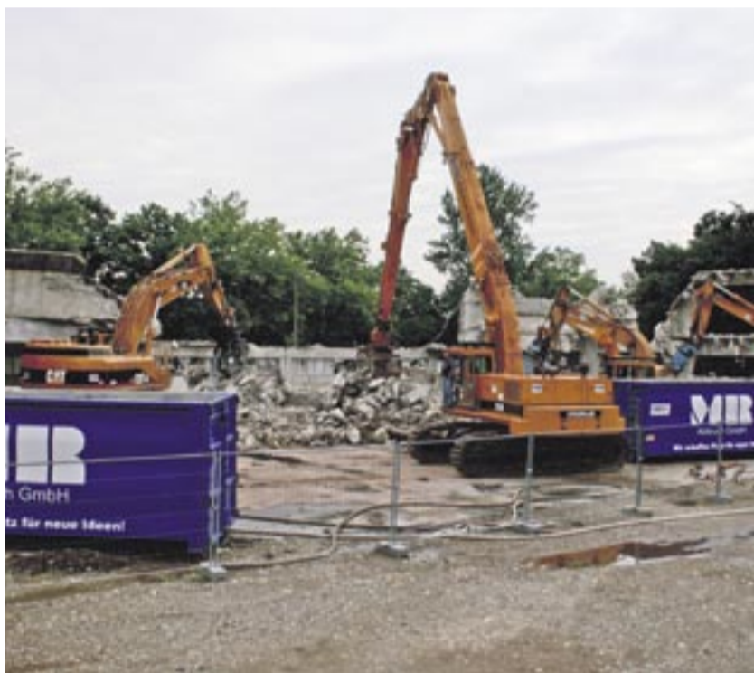
Das Deggendorfer Unternehmen MR Abbruch GmbH ist aktuell mit dem Abbruch von ehemaligen Panzerhallen auf dem Areal des Sheridan-Parks beschäftigt.
