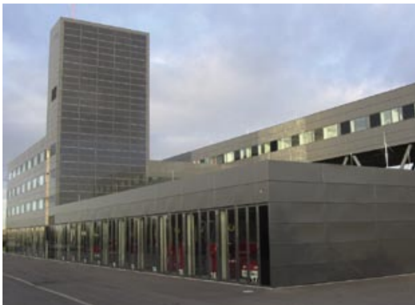
Als erste Feuerwache Deutschlands wurde das Gebäude teilweise als Passivhaus errichtet. Foto: Vedag
