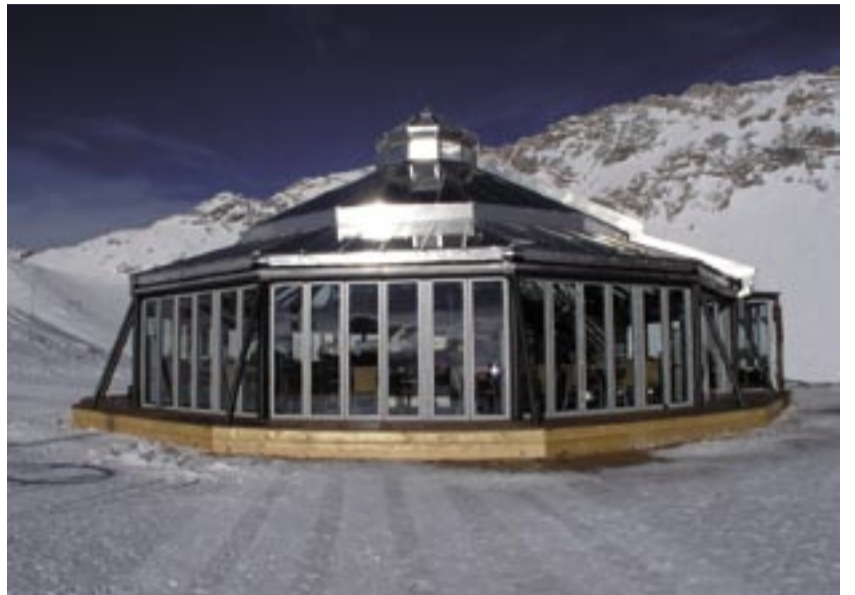
Durch die insgesamt 108 Neutralux advance-Gläser von Arnold Glas für die Fassade haben die Gäste einen Panorama-Blick über bis zu 250 Kilometer.
