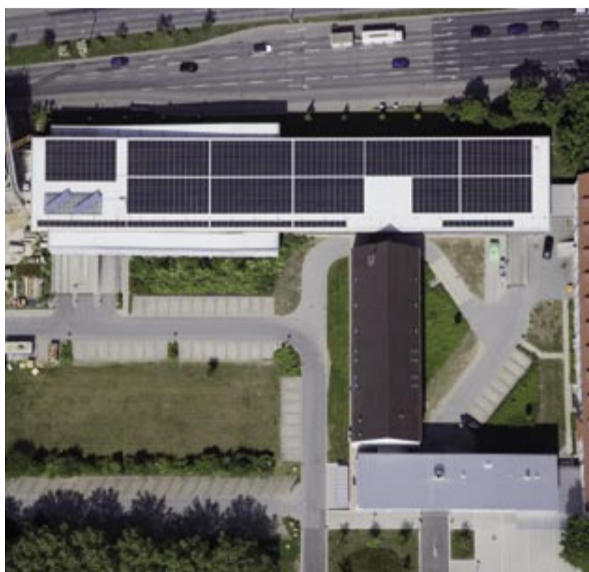
1 832 Solarmodule wurden bis Mai auf dem Dach der Polizeidirektion Regensburg montiert. Fotos: Carpevigo AG
