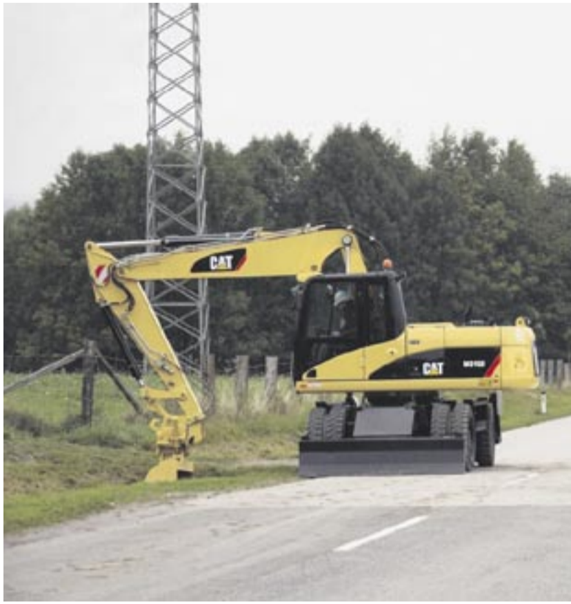
Wenn der Cat-Mobilbagger Grabenräumarbeiten entlang der Straße verrichtet, wird von ihm Produktivität erwartet. Dabei sollte er noch möglichst wenig Kraftstoff verbrauchen, so wie es beim Cat M315 D der Fall ist. Foto: Zeppelin
