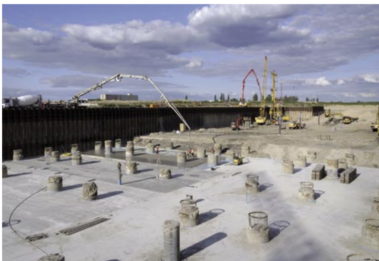
Auf 236 Säulen wird der BBI-Bahnhof einmal stehen. Der Überblick zeigt einige dieser Säulen und Arbeiter beim Gießen der Betonsohle. Foto: Marion Schmieding / Alexander Obst
