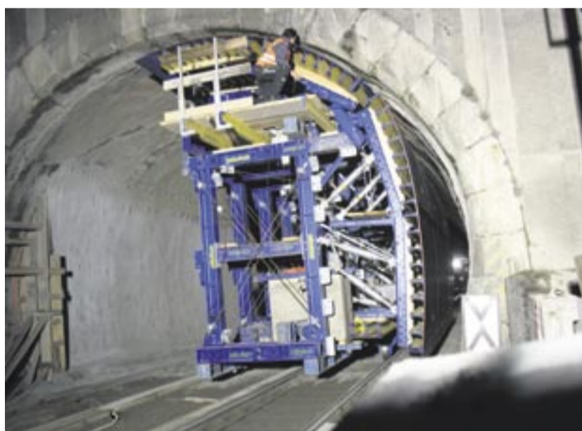
Für den in Ortbeton zu sanierenden Abschnitt kam eine schnell zu handhabende Schalungskonstruktion zum Einsatz. Fotos: Franz Kassecker GmbH, Waldsassen
