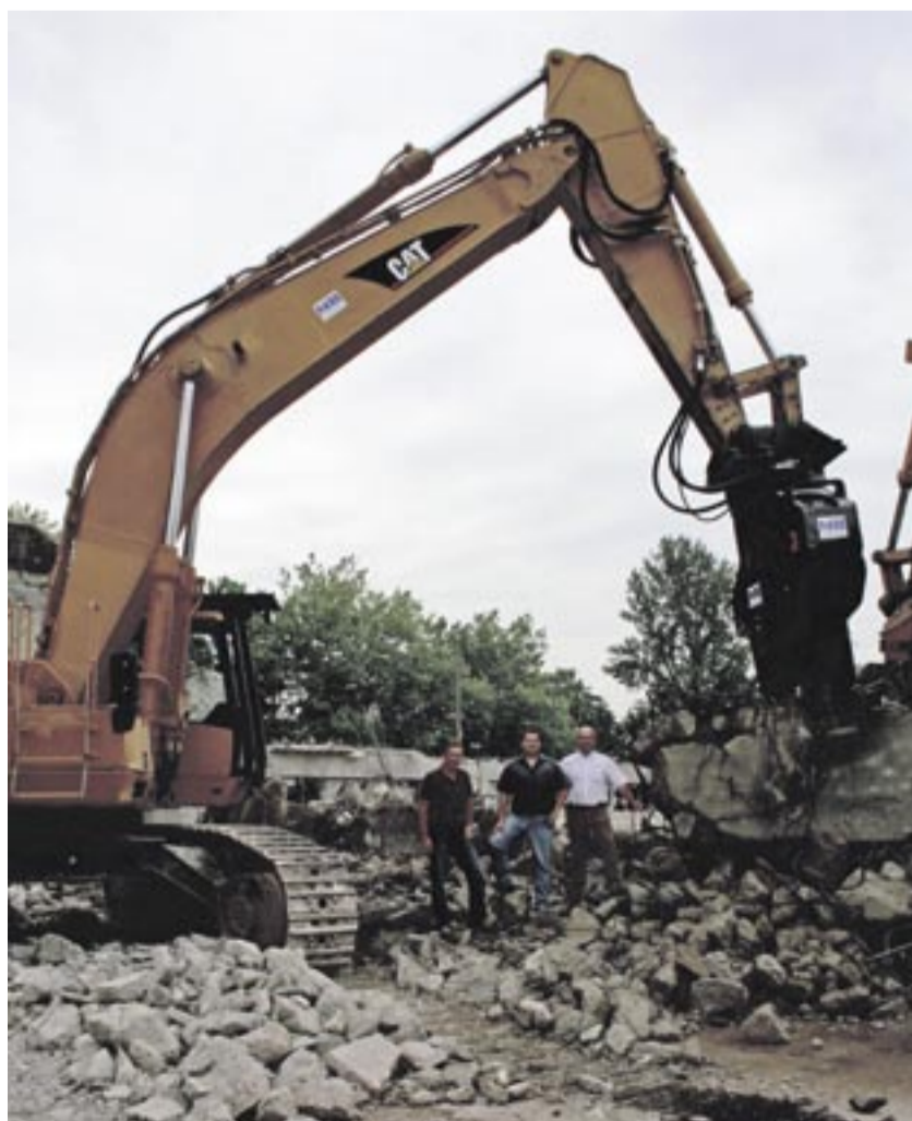
Auf der Baustelle der ehemaligen Sheridan-Kaserne (von links): Zeppelin Verkaufsrepräsentant der Niederlassung Straubing, Rainer Stumbeck, Geschäftsführer der MR Abbruch GmbH, Reinhold Meister jun. und Zeppelin Verkaufsleiter der Niederlassung Straubing, Franz Bösl.
