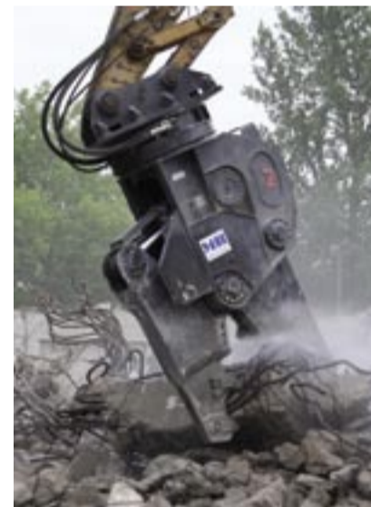
Die Verachttert-Abbruchscheren VT 60 B-Backe zerkleinert die Teile problemlos.
