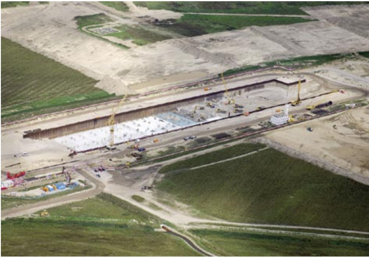
Ein Jahr BBI-Baustelle. Ein Überblick aus der Luft über den Fortschritt der Bauarbeiten.
