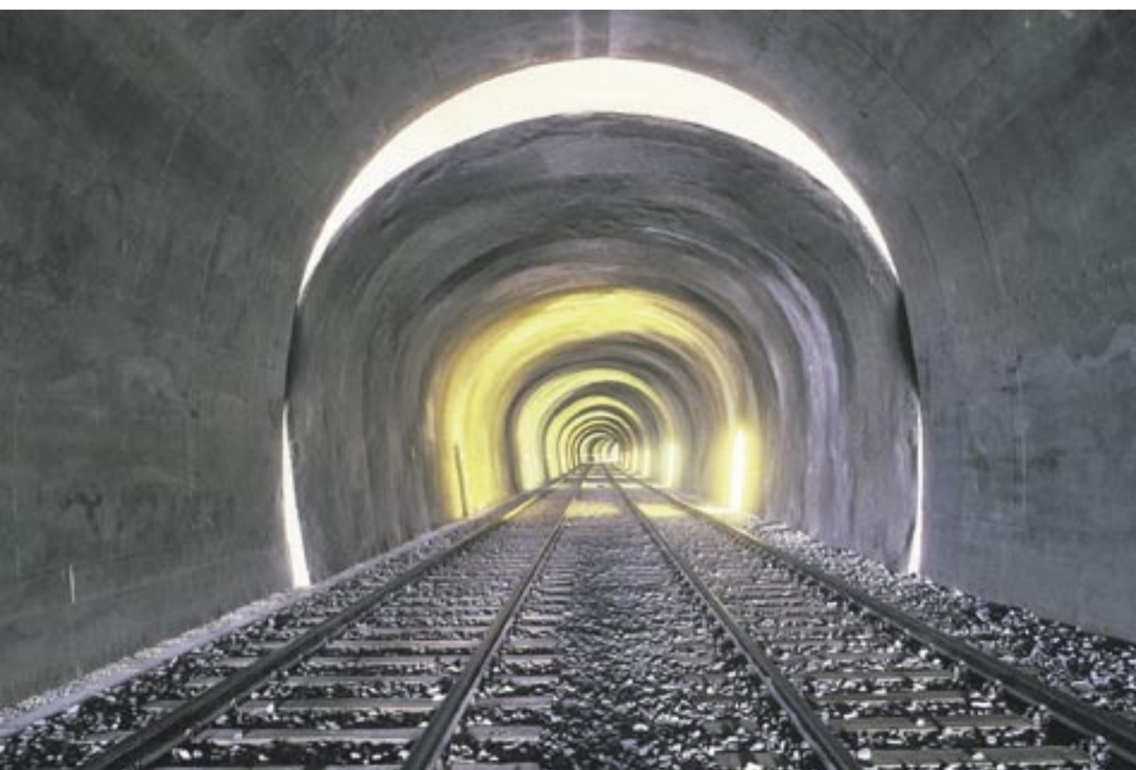
Der 494 Meter lange Ennericher Tunnel, erbaut 1882, wurde einer gründlichen Sanierung unterzogen.
