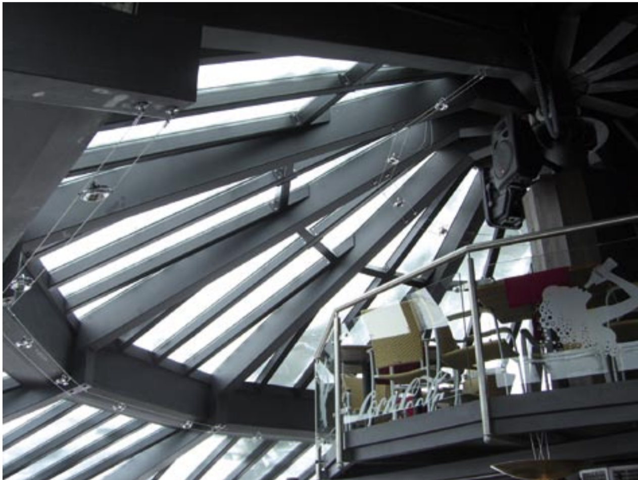
Das Dach des Zugspitz-Restaurants öffnet sich bei schönem Wetter.
