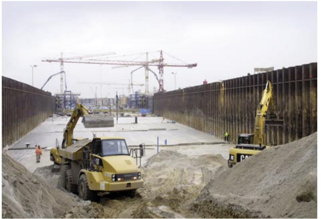
400 Meter lang und 60 Meter breit - die Baugrube für den unterirdischen Bahnhof des zukünftigen Hauptstadt-Airport BBI.
