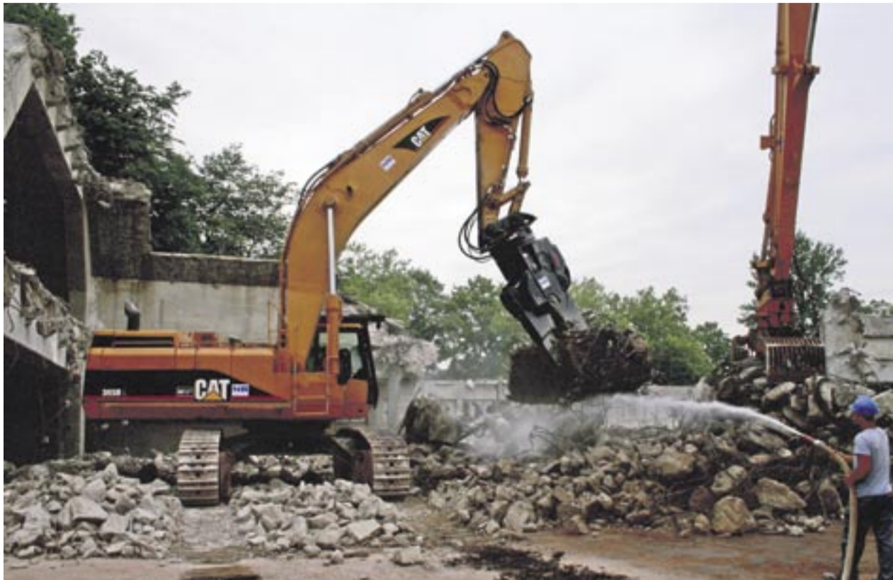
Der Cat-Kettenbagger 365 BL im Einsatz mit seiner Verachttert-Abbruchscheren.
