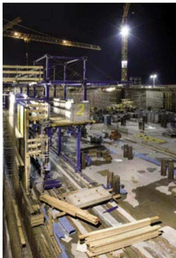
Blick in die nächtliche Baugrube für den unterirdischen BBI-Bahnhof. Seine Dimensionen: 400 Meter lang und 60 Meter breit. Foto: Marion Schmieding / Alexander Obst
