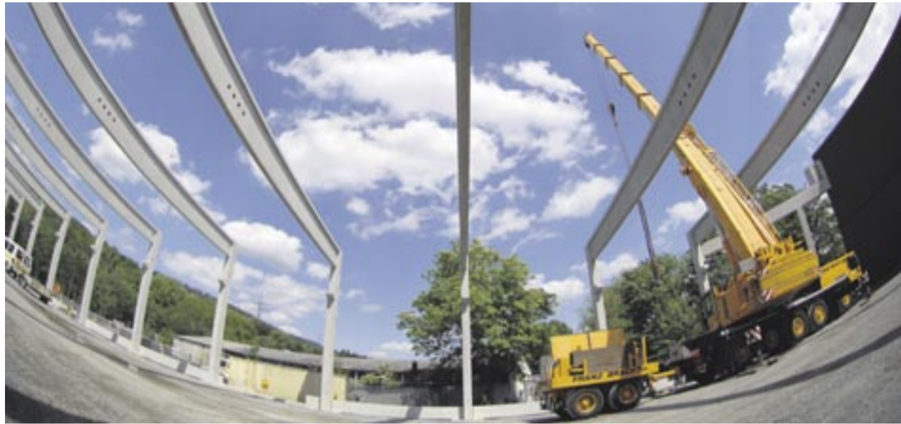
Lehde baut das 1 400 Quadratmeter große Baustofflager von Raab-Karcher.
