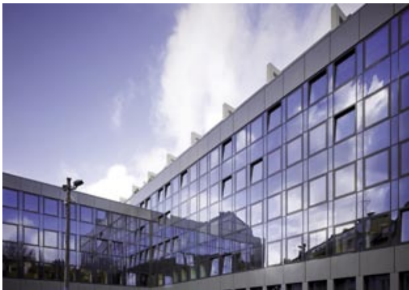
Die blaugrau schimmernde Fassade wurde mit selbstreinigendem Funktionsglas des Herstellers Pilkington ausgestattet und fügt sich elegant in die Umgebung ein.
