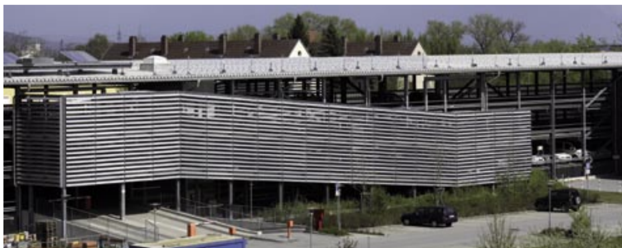
Das Gebäude der Polizeidirektion hat ein Trapezblechdach. Die gesamte Fotovoltaikanlage wurde mit speziell auf Maß angefertigten Profilen direkt auf dem Dach befestigt. Das Dach trägt die gesamte Anlage.
