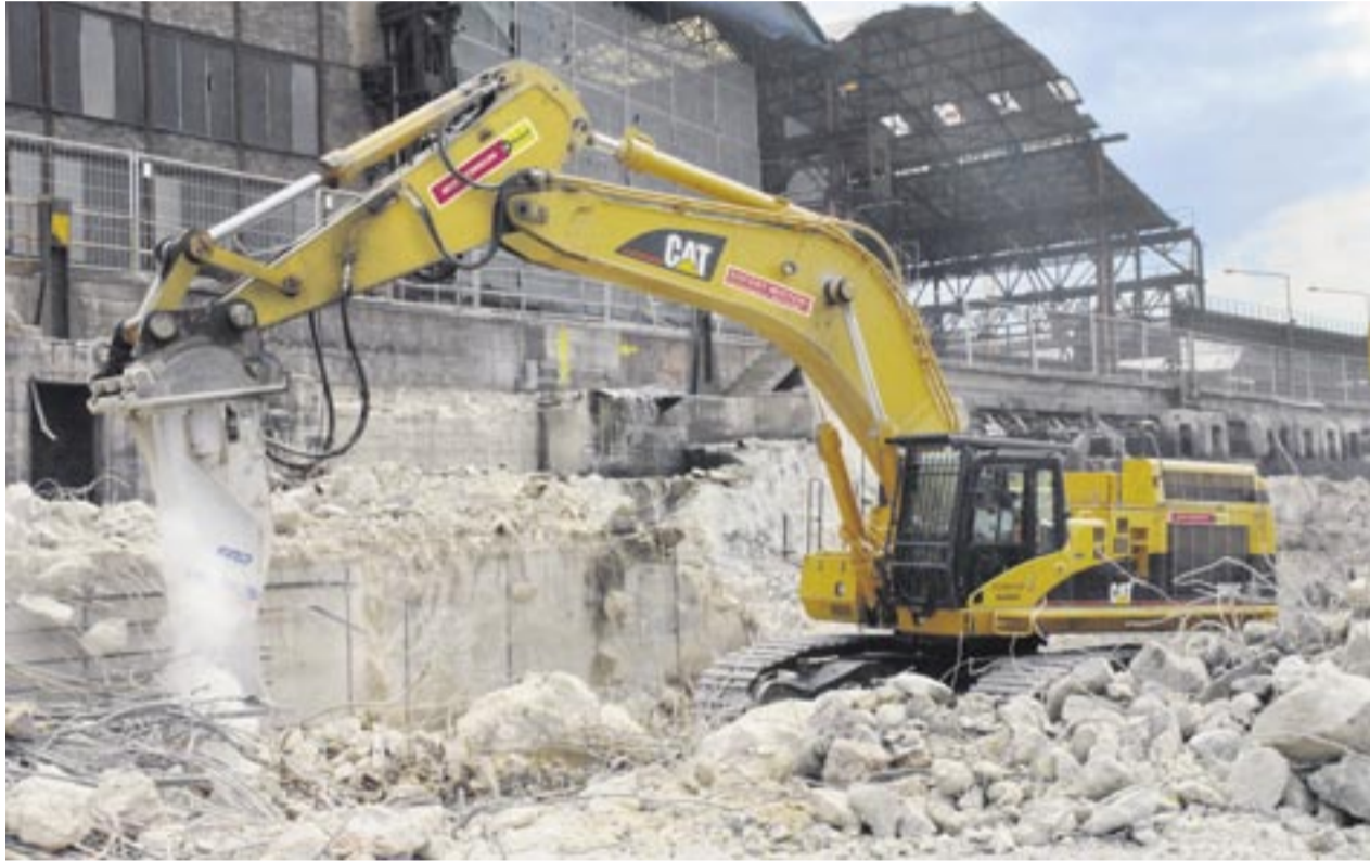
Kraft und Leistung pur – Cat-Kettenbagger 365C L aus der Mietflotte von MVS Zeppelin im Abbrucheinsatz. Foto: MVS Zeppelin
