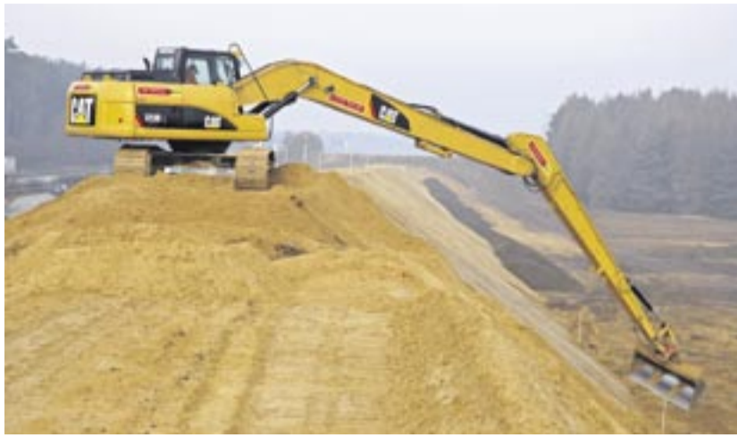
MVS Zeppelin-Bedienpersonal im Einsatz: Ein Kettenbagger Cat 323 mit dem Ausleger Ditch Clean sorgt für die Glättung der Wallwände. Fotos: MVS Zeppelin
