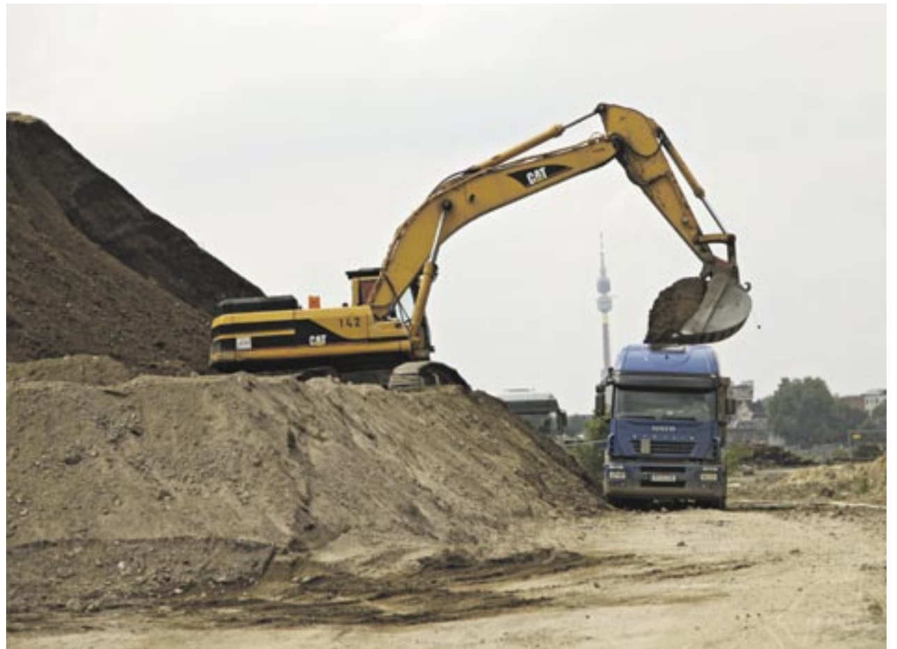
Bauarbeiten Phoenix Gelände.
