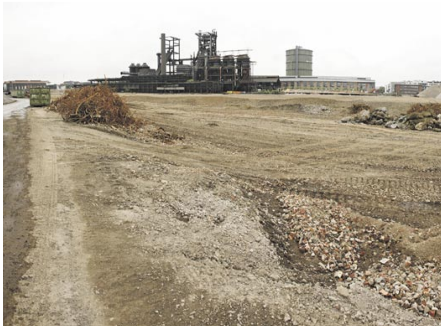
Baustelle Phoenix Gelände.
