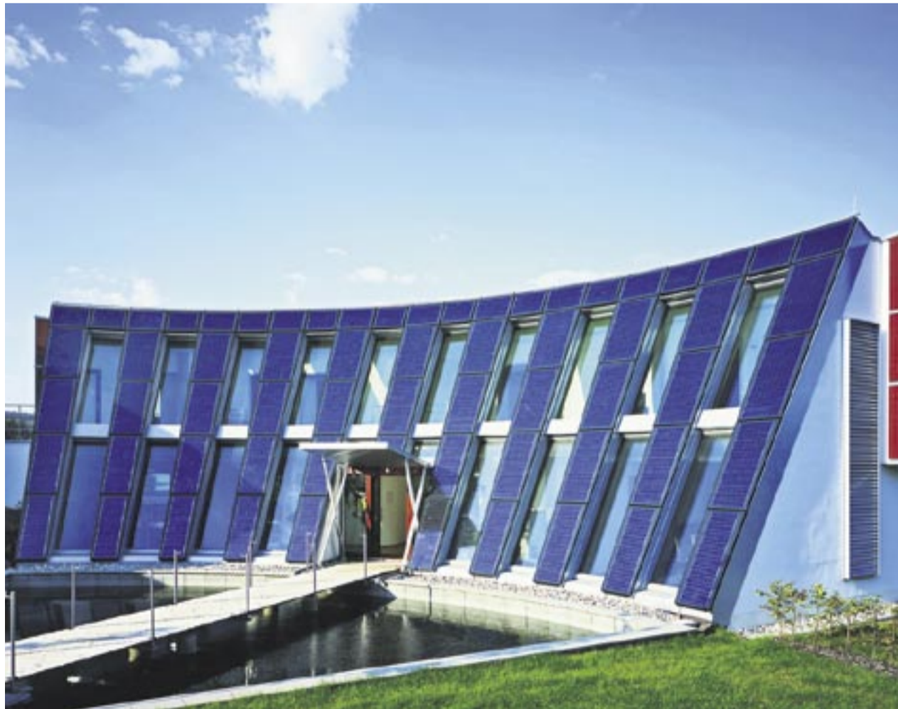
Ein Bürogebäude in Bolanden ist ein gutes Beispiel für den Passivhausstandard.
