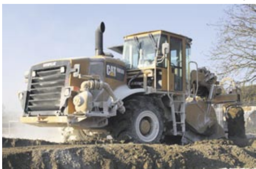
Die Cat-Bodenstabilisierer werden dazu eingesetzt, nicht tragfähige Böden mit einem speziellen ressourcenschonenden Verfahren, das Stetter in Pionierarbeit entwickelt hat, zu verbessern und tragfähig zu machen.
