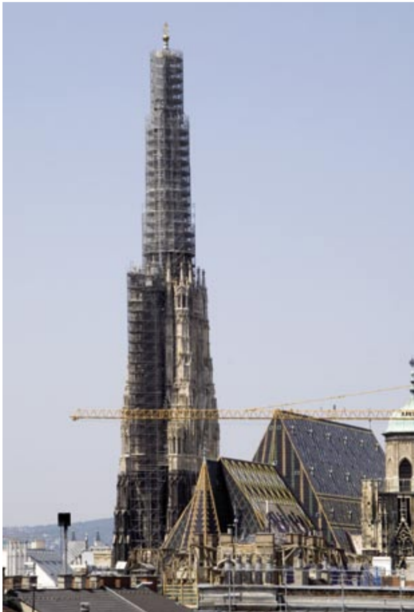
Die Einrüstung der Turmspitze am Stephansdom verlangte von den Gerüstbauern hohe handwerkliche Präzision und permanentes Sicherheitsbewusstsein. Hier oben arbeiten nur die erfahrensten Gerüstmonteure mit der meisten Praxis. Foto: ThyssenKrupp Xervon
