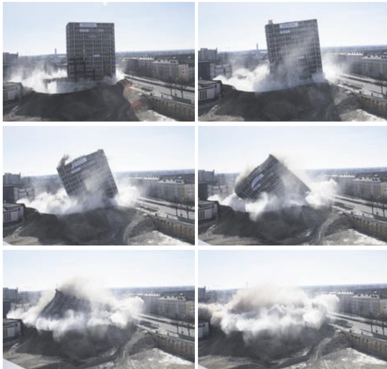
In wenigen Sekunden fällt das 52 Meter hohe Agfa-Hochhaus in sich zusammen.
