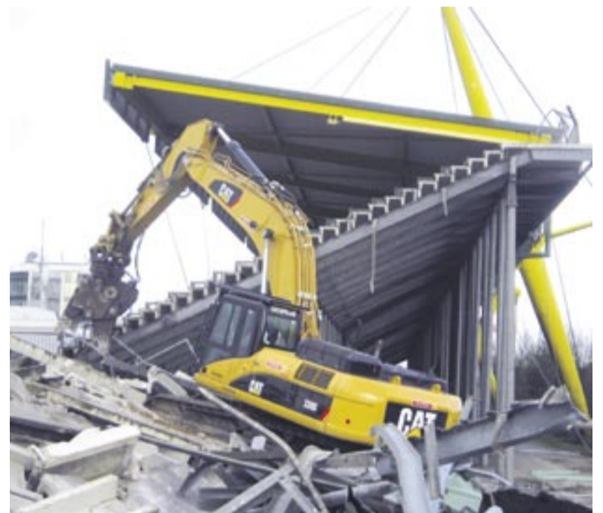
Einige tausende Tonnen Stahl und Beton waren ein gefundenes Fressen für den 330D, der die alte Tribüne fein säuberlich zerlegte und ihre Bestandteile für die Wiederverwertung sortierte.
