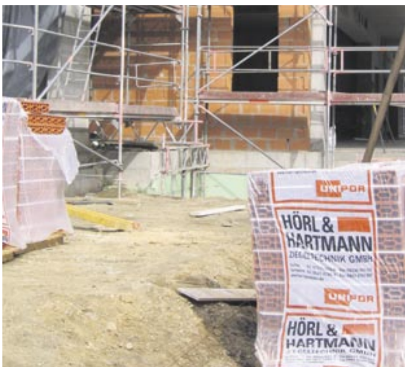
Massiv im Einsatz: Unipor-Ziegel auf der „inHaus2“-Forschungsbaustelle in Duisburg. Foto: Unipor
