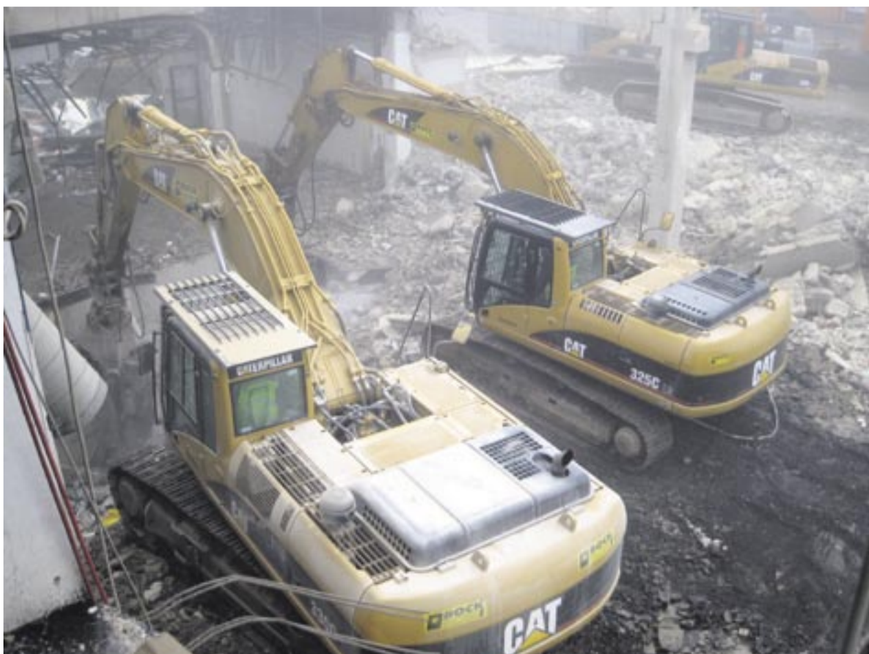
Insgesamt hatte es die August Bock GmbH am Nürburgring mit 180 000 Kubikmeter umbauten Raum zu tun. Dafür setzten die Hünfelder neun Cat-Kettenbagger mit Einsatzgewichten von 34 bis 48 Tonnen ein. Fotos: Zeppelin
