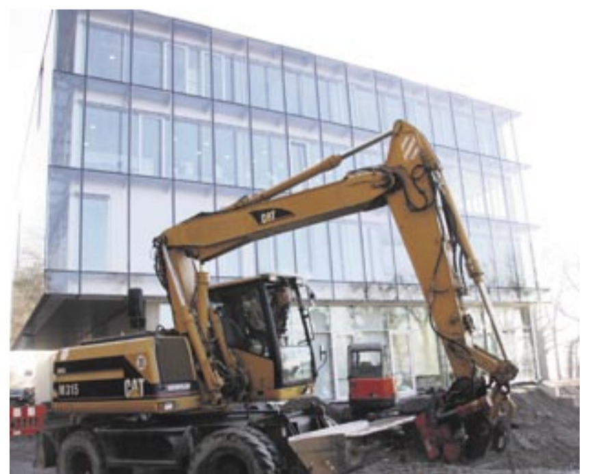
Erst vor wenigen Wochen wurde der Neubau der Zeppelin University eingeweiht.
