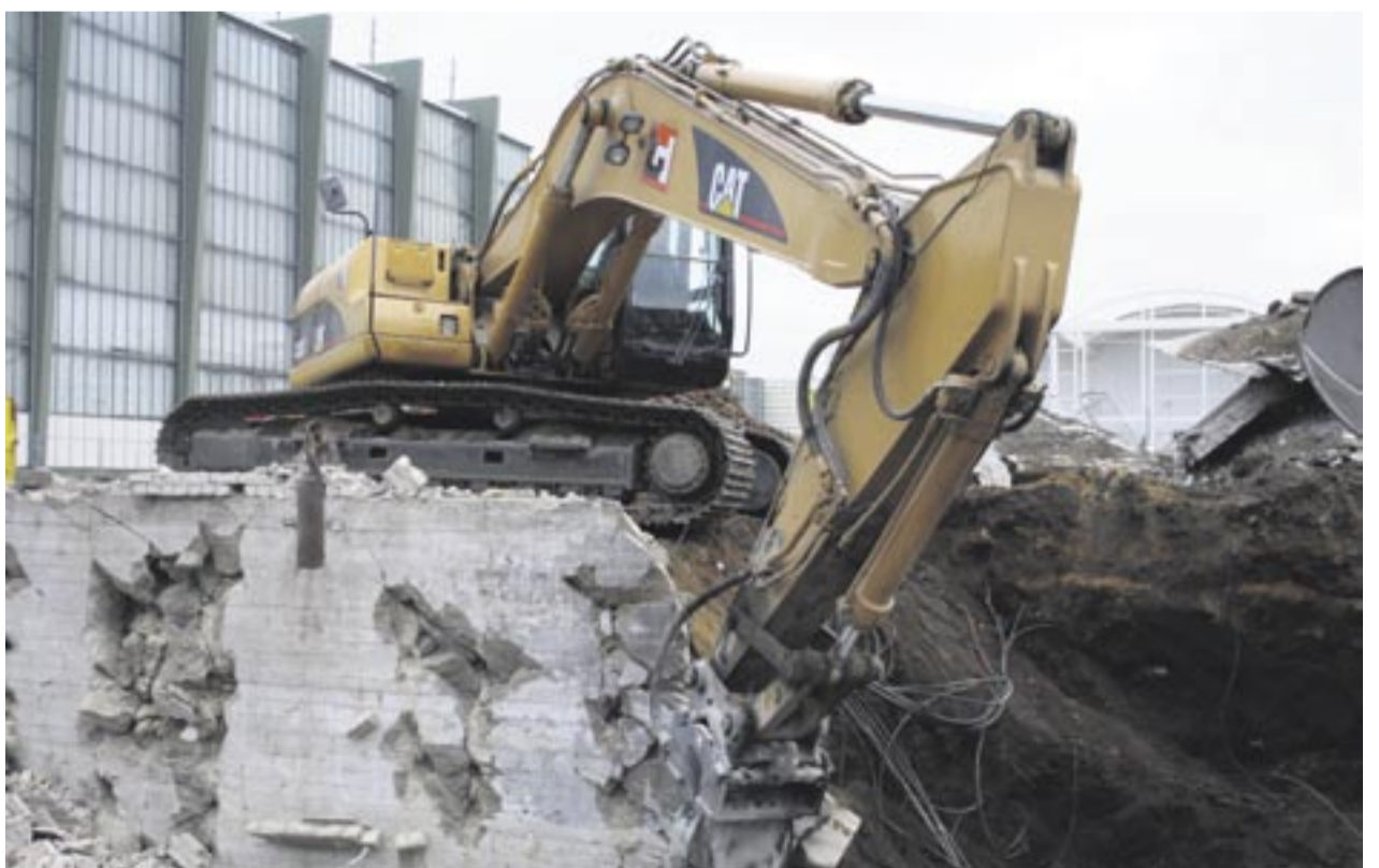
Damit der Neuen Messe Hamburg und ihren Hallen nichts mehr im Wege steht, wird ein Cat-Bagger eingesetzt.
