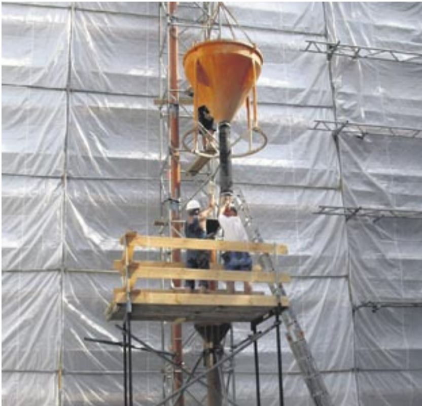
Das Verfüllen der Stützsäulen erfolgte über einen Krankübel. Wegen der besonderen Qualitätsanforderungen an den Beton war die Einbauzeit je Fahrmischer-Ladung auf 45 Minuten beschränkt. Beton, der bis dahin nicht eingebaut war, ging zurück an das Mischwerk. Fotos: Cemex
