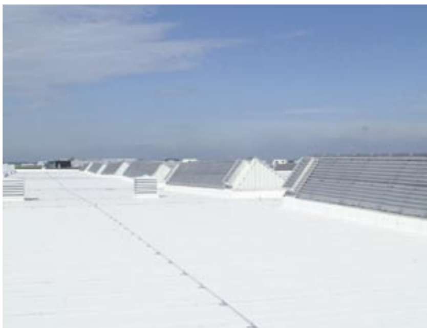
Weil eine weiße Bitumen-Membran auf dem Dach das Sonnenlicht besser reflektiert, kann eine Erwärmung der Dachmembran verhindert werden. Foto: Derbigum
