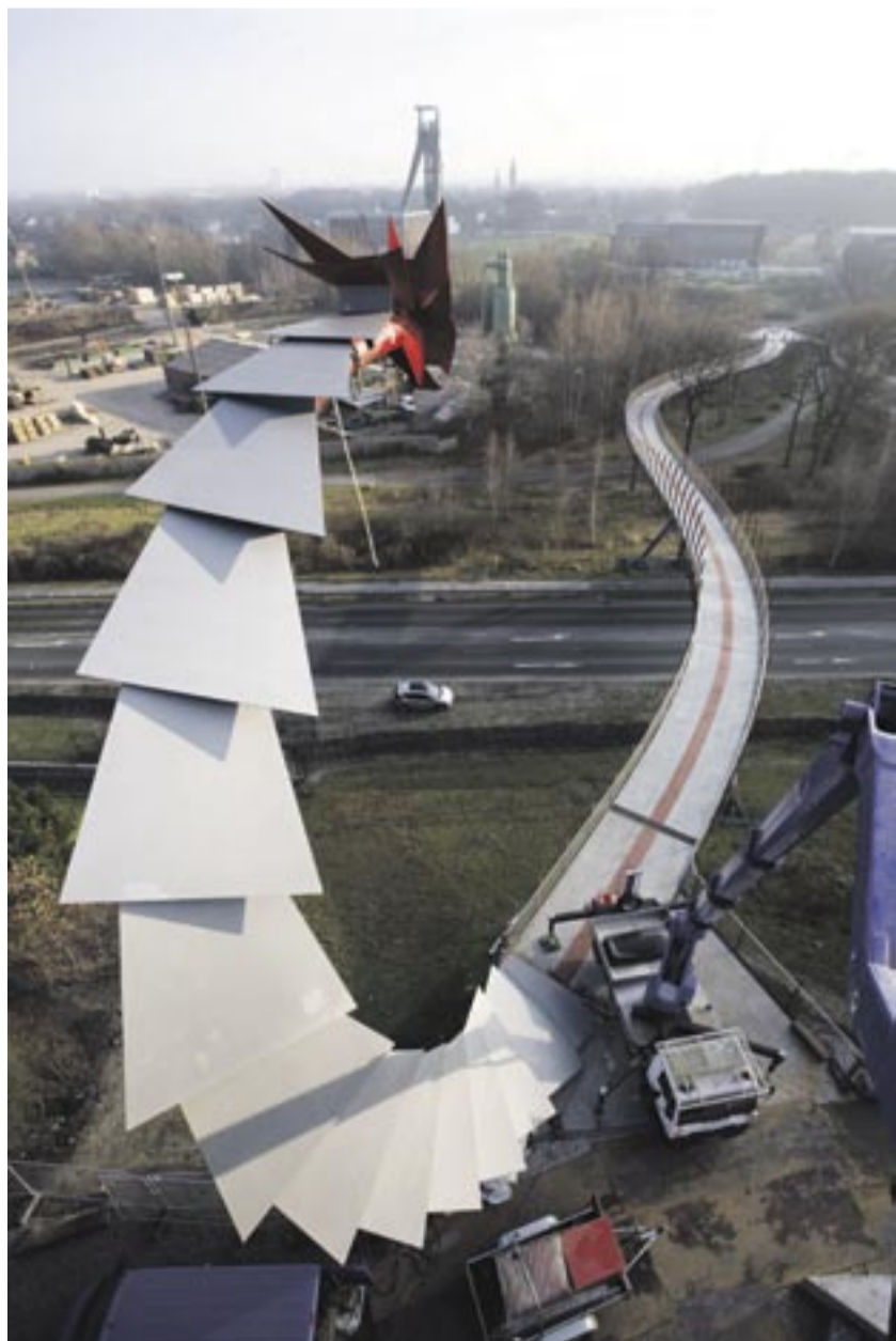
Die Metropole Ruhr fest im Blick hat der Drache der neuen Fußgängerbrücke in Recklinghausen.
