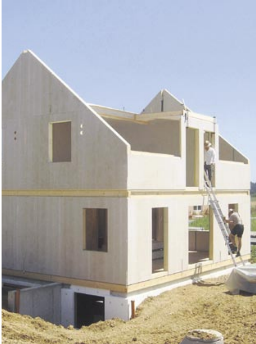
Die Gipsfaserplatte von Rigips ist in erdbebengefährdeten Regionen als Baumaterial zugelassen. Foto: Saint-Gobain Rigips
