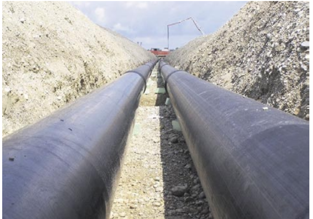
Auch in puncto Fernwärme bietet das Bauunternehmen Franz Kassecker entsprechendes Know-how.
