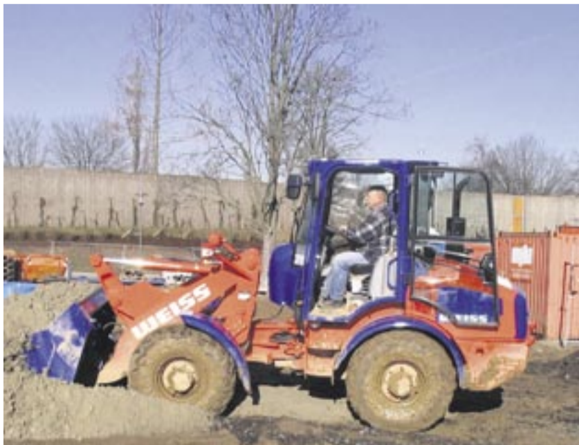
Die Firma Weiss setzt die neuen Cat-Maschinen wie den Radlader 907 H für vielfältigste Aufgaben rund um den Bau ein, so wie hier bei der Erschließung eines Neubaugebiets in Baden-Baden.
