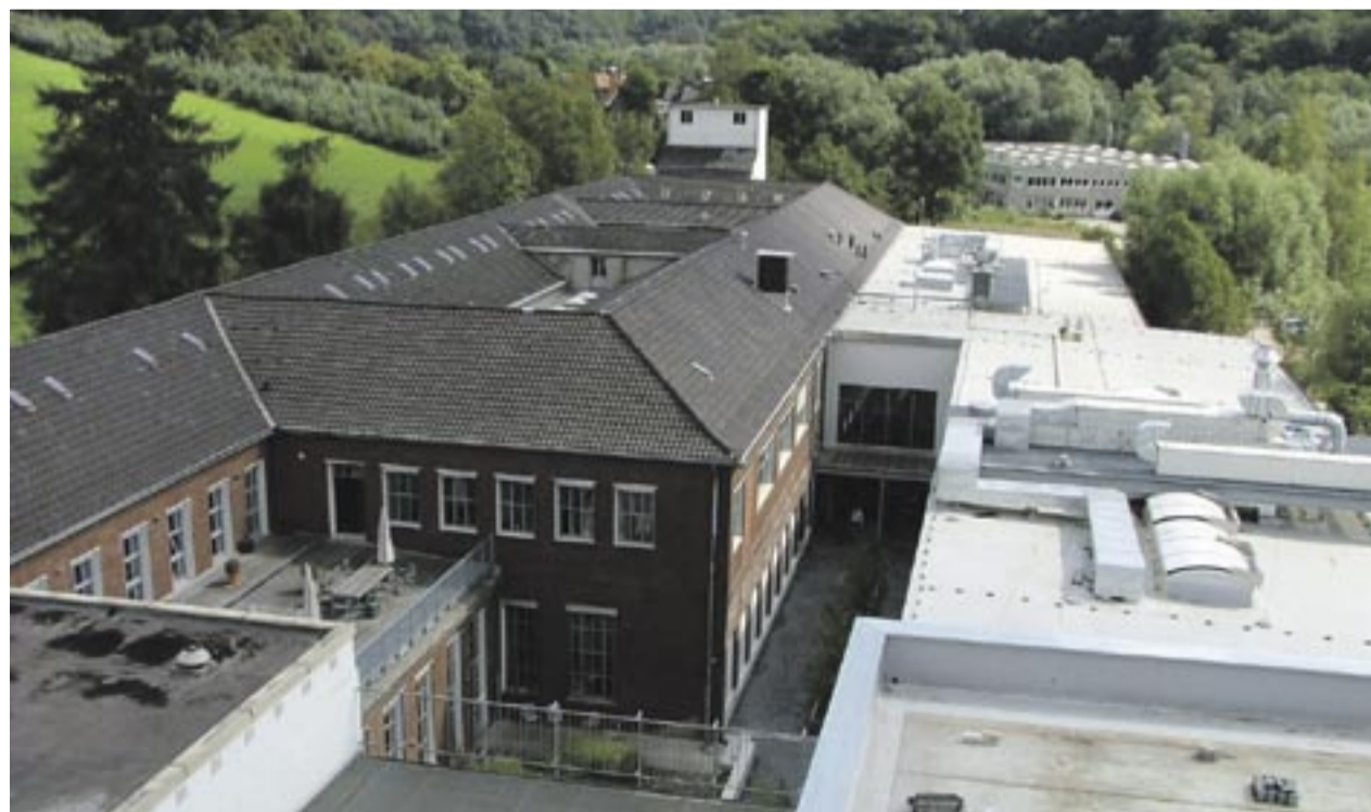
Die Brügger Mühle in Erkrath ist ein Beispiel für ein gelungenes Sanierungs- und Umnutzungsprojekt.
