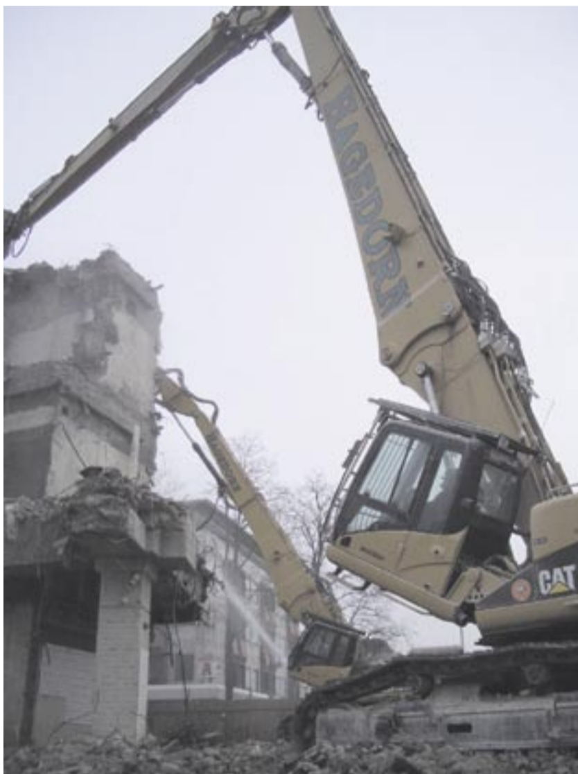
Eingespieltes Duo von Cat-Baggern während des Abbruchs.
