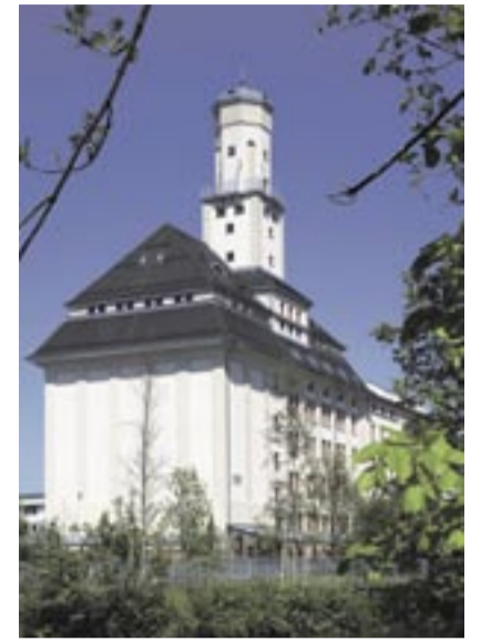
Die „Quest Kunstmühle“ in Rosenheim wurde innerhalb von drei Jahren komplett saniert. Für einen zuverlässigen und hochwertigen trockenen Innenausbau in dem denkmalgeschützten Gebäude sorgte die Akustikbau Heinrich & Sick GmbH mit den Produkten von Ausbau-Profi Rigips. Fotos: Rigips
