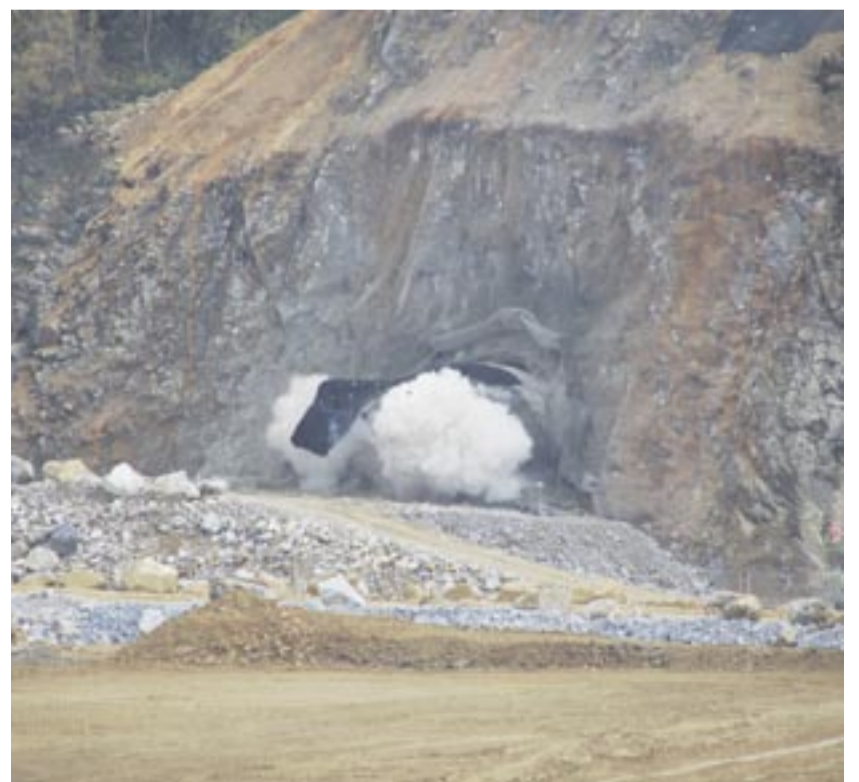
In unmittelbarer Nähe zum bestehenden Steinbruch Rohdenhaus erschließt Rheinkalk kurzzeitig einen zweiten Steinbruch. Um mit den Gewinnungsgeräten nicht über die Kreisstraße fahren zu müssen, baut das Unternehmen einen rund 140 Meter langen und zehn Meter hohen Tunnel. Im Bild: Sprengungsarbeiten für die Kalotte.
