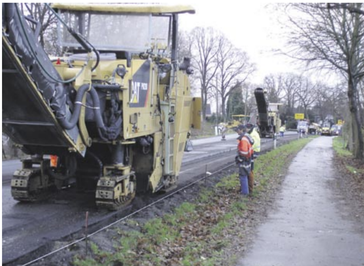
Seit 2007 steht die Deckensanierung der Bundesstraße B70 zwischen Wesel und Brünen an, bei der die Qualität der Fahrbahndecke langfristig gesichert werden soll. Die Maßnahme beinhaltet auf einer Länge von sechs Kilometer das Abfräsen einer 20 Zentimeter starken Asphaltdecke. Fotos: Zeppelin
