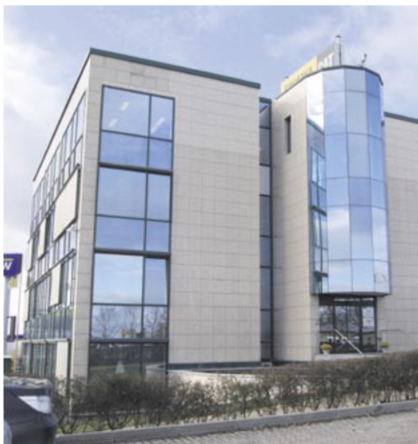
Mehr Platz für Büros bietet der erweiterte Bau von Phoenix-Zeppelin.
