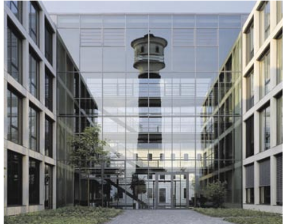
Der Neubau steht im Spannungsfeld zwischen den erhaltenen Altbauten und schafft durch die gläserne Halle Blickbeziehungen zum Wasserturm und der Direktorenvilla. Fertigstellung 2005. Sitz der Agfa HealthCare.
