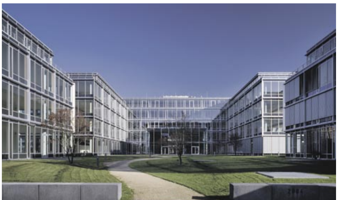
Das Rheinwerk mit 10 600 Quadratmeter Bürofläche wurde im Herbst 2005 fertig gestellt. In dem U-förmigen Gebäude mit Panoramablick auf den Rhein und das Siebengebirge arbeiten unter anderem Firmen wie adidas, Nortel, Galileo Press, Senacor Technologies AG und GFT Technologies AG. Foto: BonnVisio/Tomas Riehle
