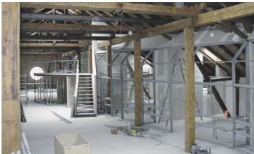
Besonders das Ausschneiden der „Rigips Bauplatten RB“ an den Übergängen zu den Deckenbalken war für die Experten der Heinrich & Sick GmbH eine besondere Herausforderung. Hier war äußerste Präzision gefragt.
