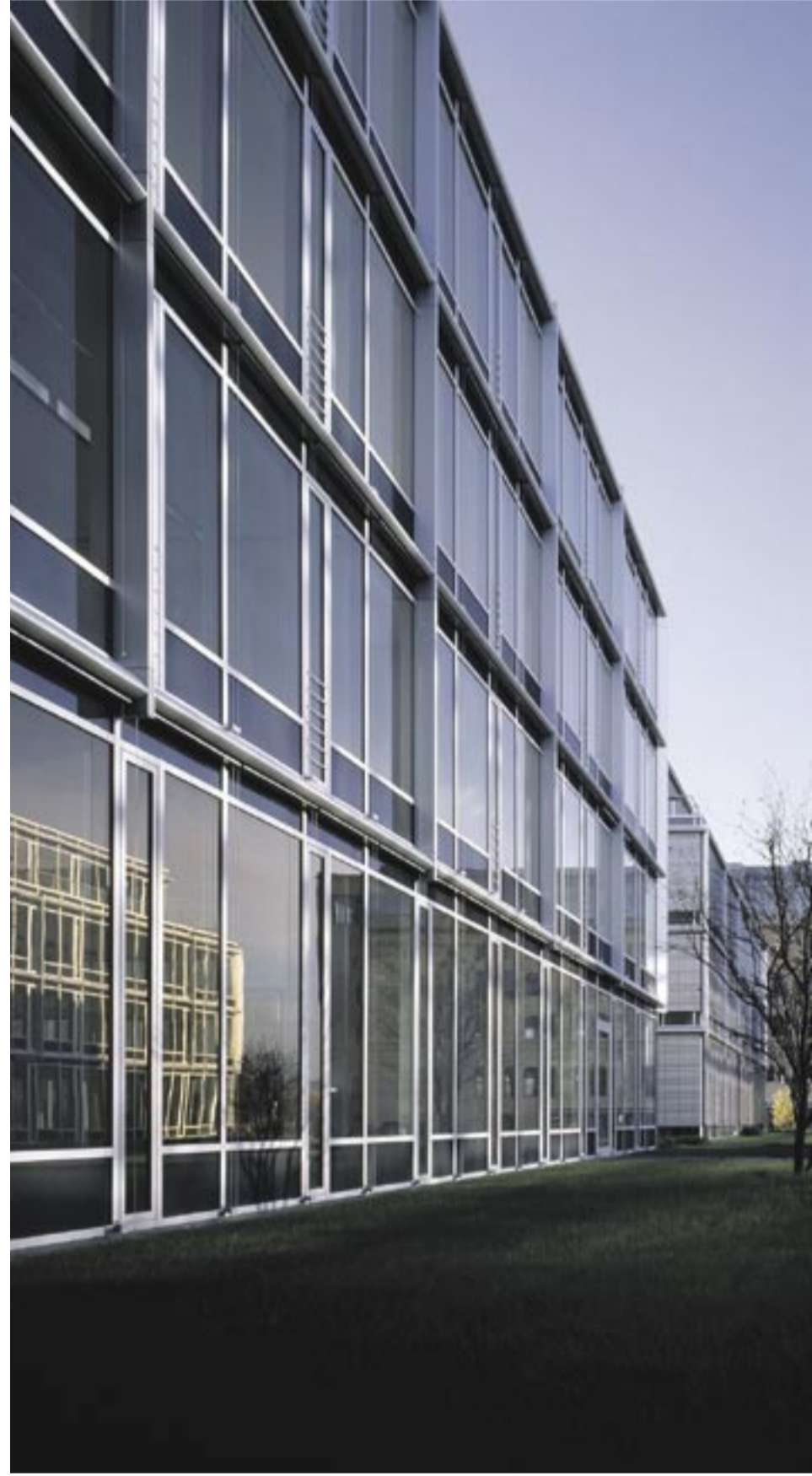
Spannungsreiche Architektur zwischen Alt und Neu. Hier die Rohmühle der ehemaligen Portland-Zementfabrik, die in den integrierten Büroneubau integriert wurde. Fertig gestellt war das Projekt 2006.
