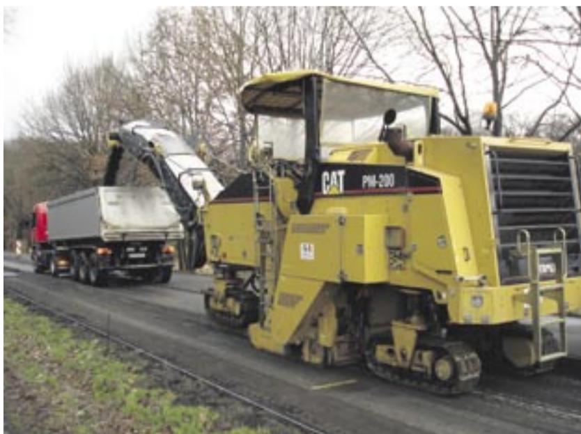
Um schadhafte Asphalt- und Betondecken zu entfernen, rückt die Straßenbaufirma mit seiner neuen Fräse von Caterpillar, einer PM-200, dem Straßenbelag zu Leibe.
