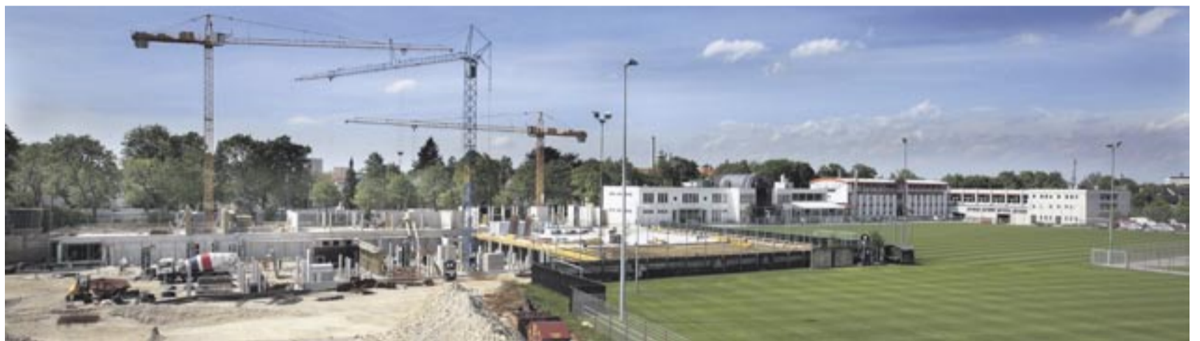
Im Anschluss an das Profi-Haus – hinter Platz 1, auf dem die Bayern-Stars trainieren – entsteht das dreistöckige Service-Center mit 95 Metern Länge, 16 Metern Breite und zehn Metern Höhe. Foto: FC Bayern
