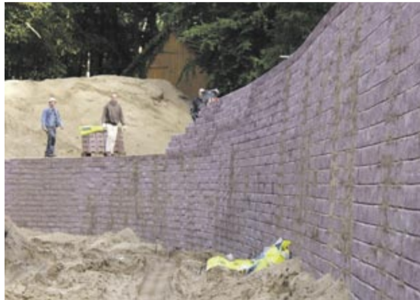
Zur Errichtung der Außenwand des Tigergeheges werden etwa 1 300 Quadratmeter Ansichtsfäche des Systems Tensar Wall eingebaut. Foto: Tensar
