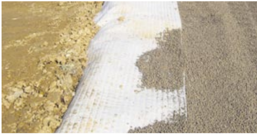
Rund 17 000 Kubikmeter Liapor-Blähton kam für die Umgehungsstraße der B 304 bei Ebersberg zum Einsatz. Foto: Liapor
