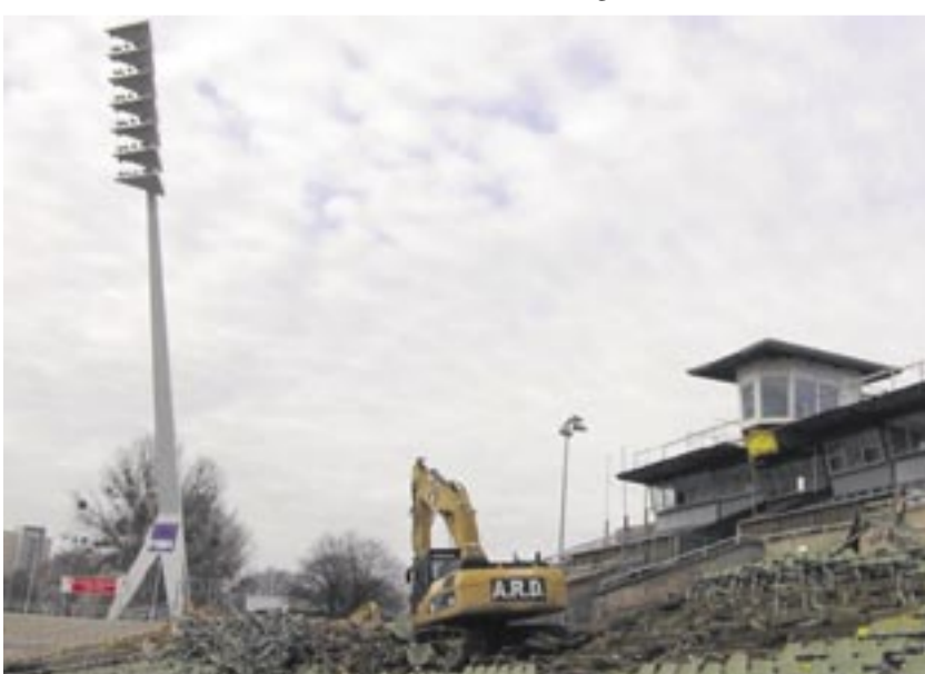
Links steht noch eine der vier Giraffen, wie die Flutlichtmasten von den Fans genannt werden. Sie waren das Wahrzeichen des Stadions. Zwei sind bereits abgebaut. Die Demontage der Giraffen Nummer drei und vier folgt.
