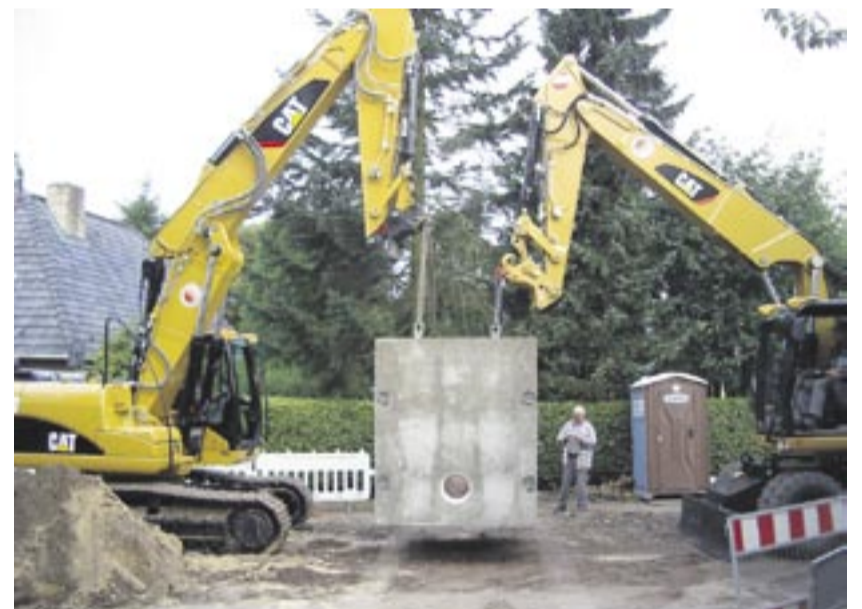
Den 13,8 Tonnen schweren Schacht stemmten die beiden Cat-Maschinen, der Mobilbagger M318D sowie der Kettenbagger 323D. Fotos: TSN
