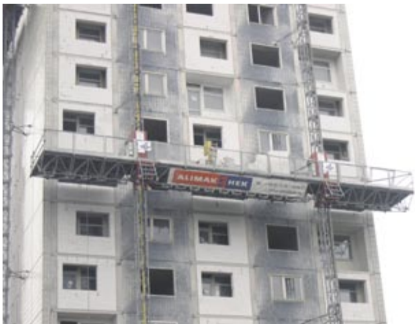
Dresdner Studentenwohnheim mit Mastkletterbühnen saniert. Fotos: Alimak Hek
