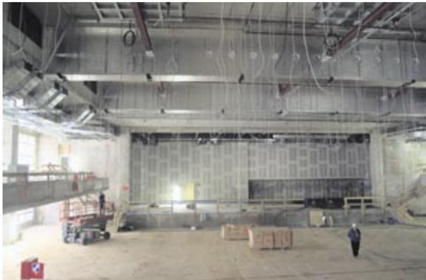
Rund 40 000 Kubikmeter Beton, 6 500 Tonnen Bewehrungsstahl, 13 000 Quadratmeter Elementdecken und 180 Kilometer Elektro-Leerrohre wurden in dem Gebäudekomplex des neuen Maritim Hotels in Berlin verbaut. Fotos: Deutsche Rockwool
