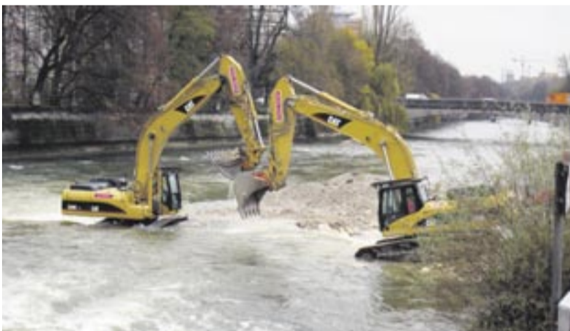
In nur 16 Tagen führt Hagn Umwelt die Nassbaggerarbeiten zur Isar-Sohlsicherung aus. Unterstützt wird das Unternehmen von zwei Cat-Kettenbaggern 330 D aus der Mietflotte von MVS Zeppelin. Fotos: MVS Zeppelin
