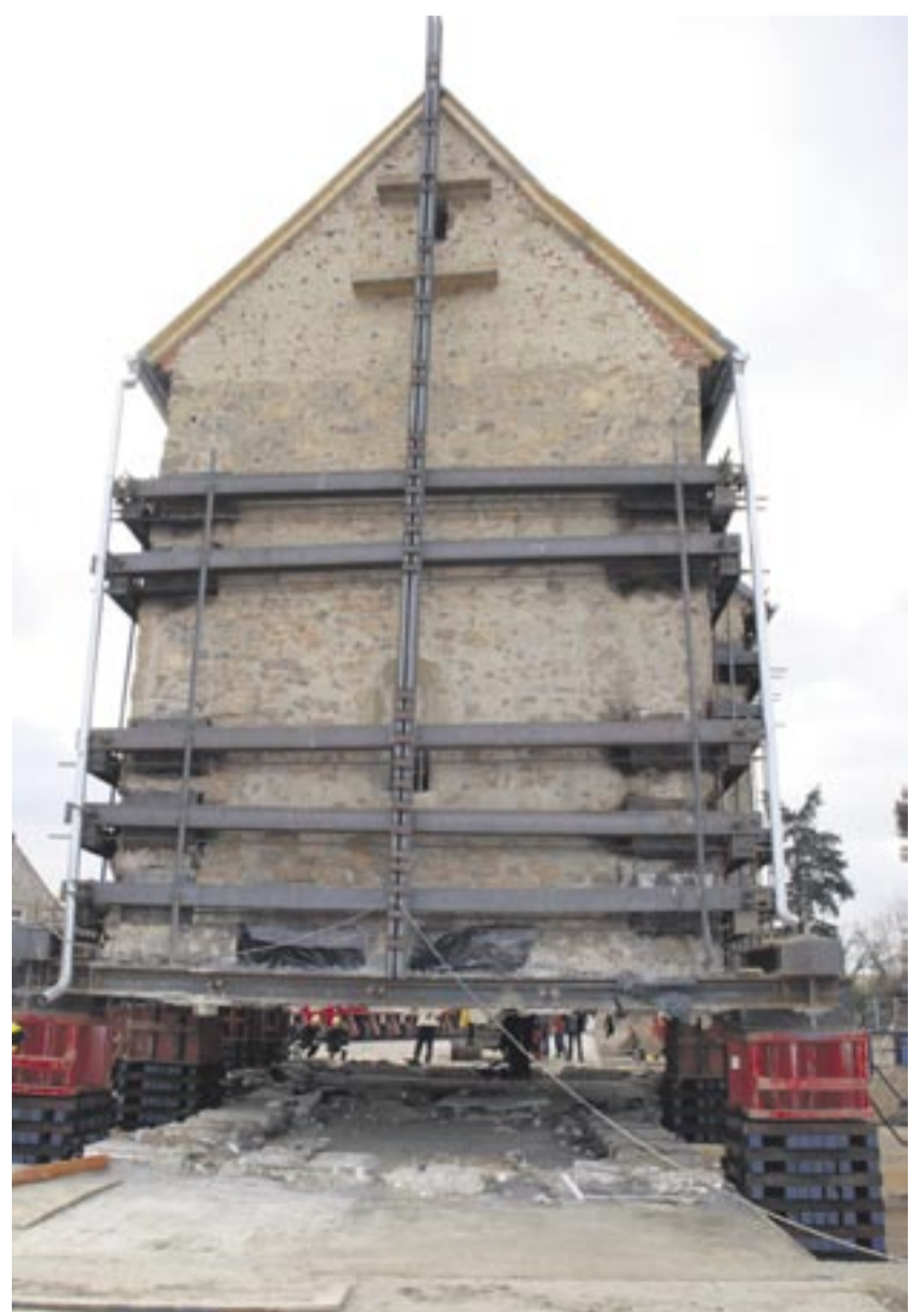
Mit Hydraulikpressen wird das Gebäude erstmals angehoben.
