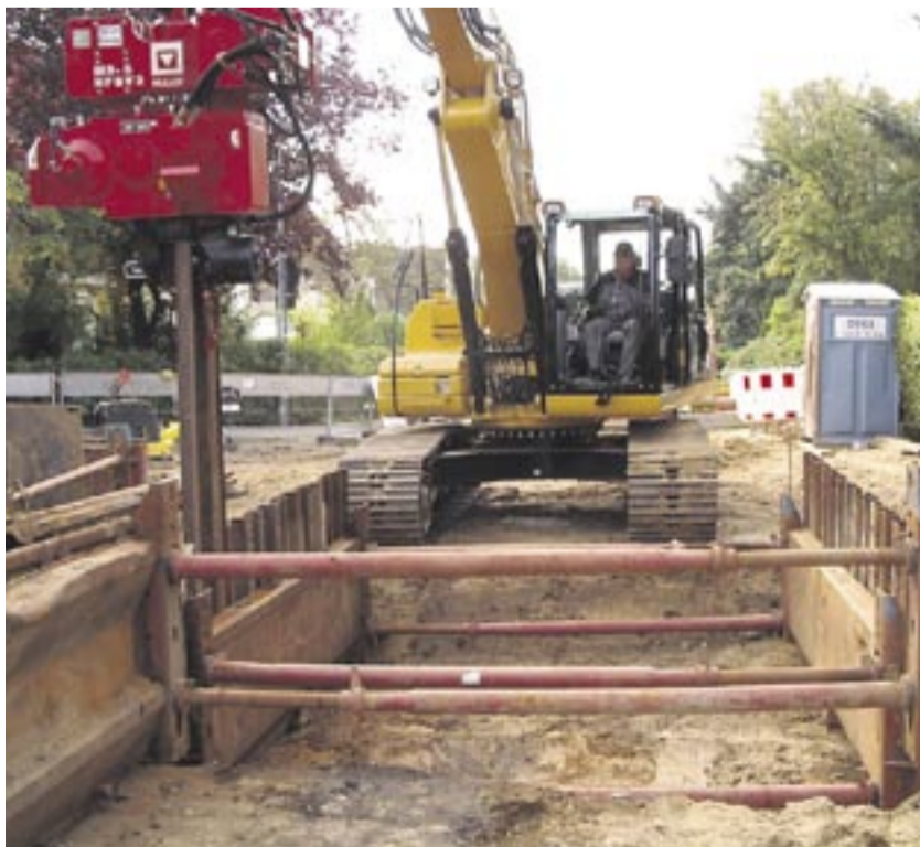
Der Cat-Kettenbagger 323D rammt Spundwände mit der neuen Spundwandramme.
