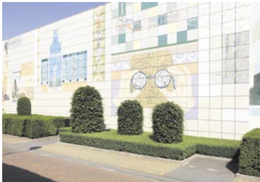
Mehr als 400 künstlerisch gestaltete keramische Fliesen im Format 60 mal 60 Zentimeter zieren die Fassade des belgischen Handelsunternehmens Gavra.
