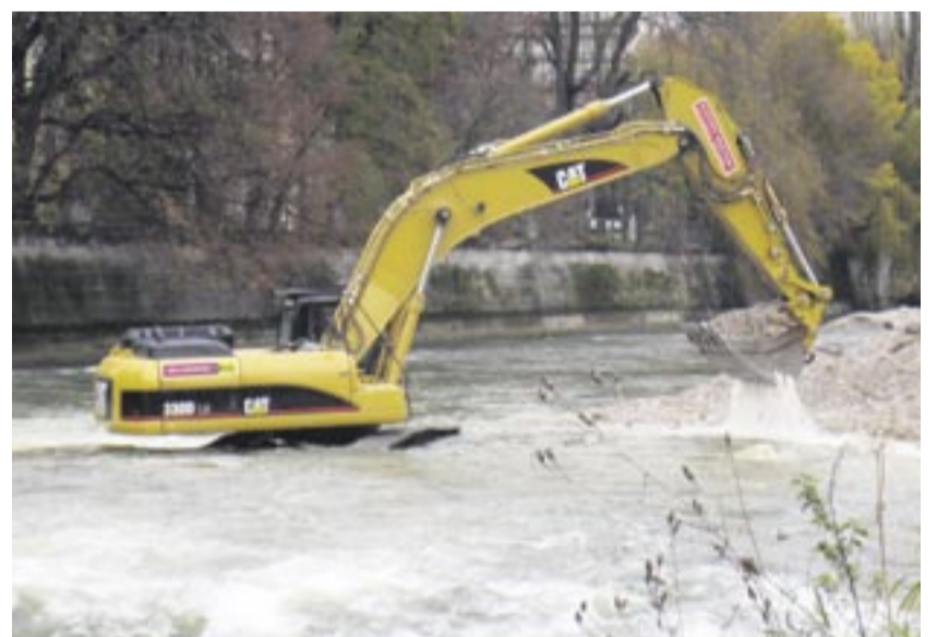
Löcher in der Baggerschaufel gewährleisten, dass das Wasser abfließen kann.
