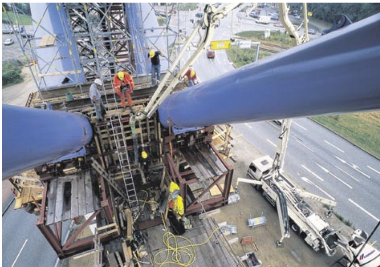
Pfeilerköpfe der Vorlandbrücke weisen Y-Verzweigungen und eine extrem dichte Bewehrung auf. Erstmals bei einem deutschen Brückenbauwerk kommt selbstverdichtender Beton für Pfeilerköpfe zum Einsatz. Foto: Cemex
