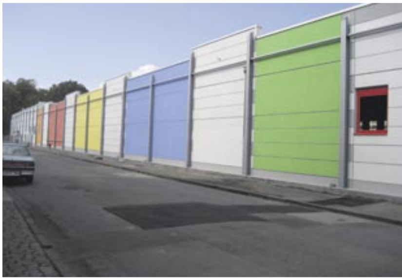
Farbige Fassade für das Einkaufszentrum.
