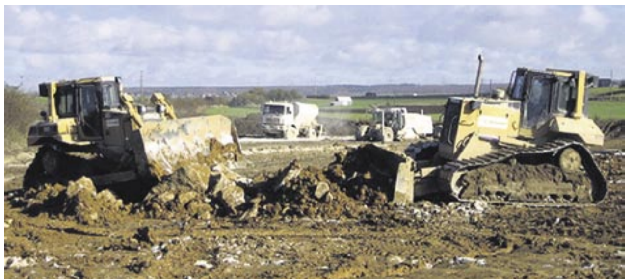
Cat-Dozer müssen für das neue Sägewerk von Egger 230 000 Kubikmeter lehmigen Boden und 60 000 Kubikmeter Fels bewegen. Foto: Zeppelin
