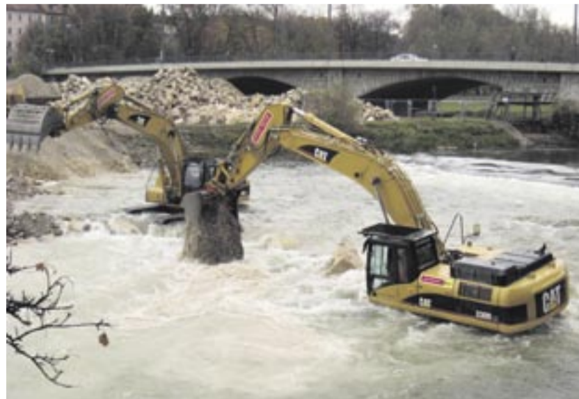
Cat-Kettenbagger erledigen die Aushubarbeiten und den Einbau von Wasserbausteinen.
