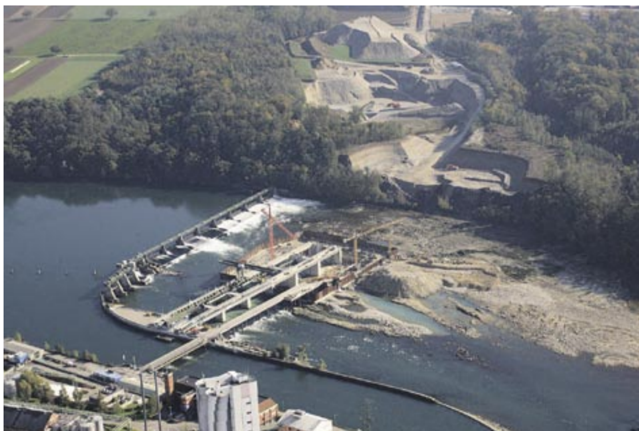
Im Herbst 2006 liefen die Vorarbeiten für die Zufahrt von der Schweizer Seite und eine Schüttung im Rhein.
