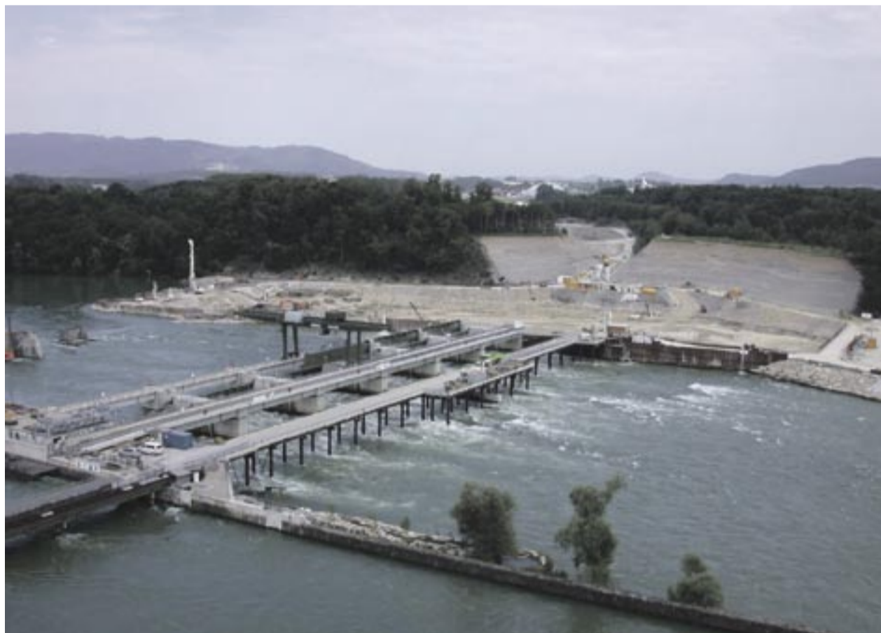
Der Aushub für die Baugrube des Maschinenhauses hat begonnen.
