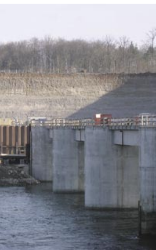
Vorarbeiten zum Bau des Maschinenhauses laufen.
