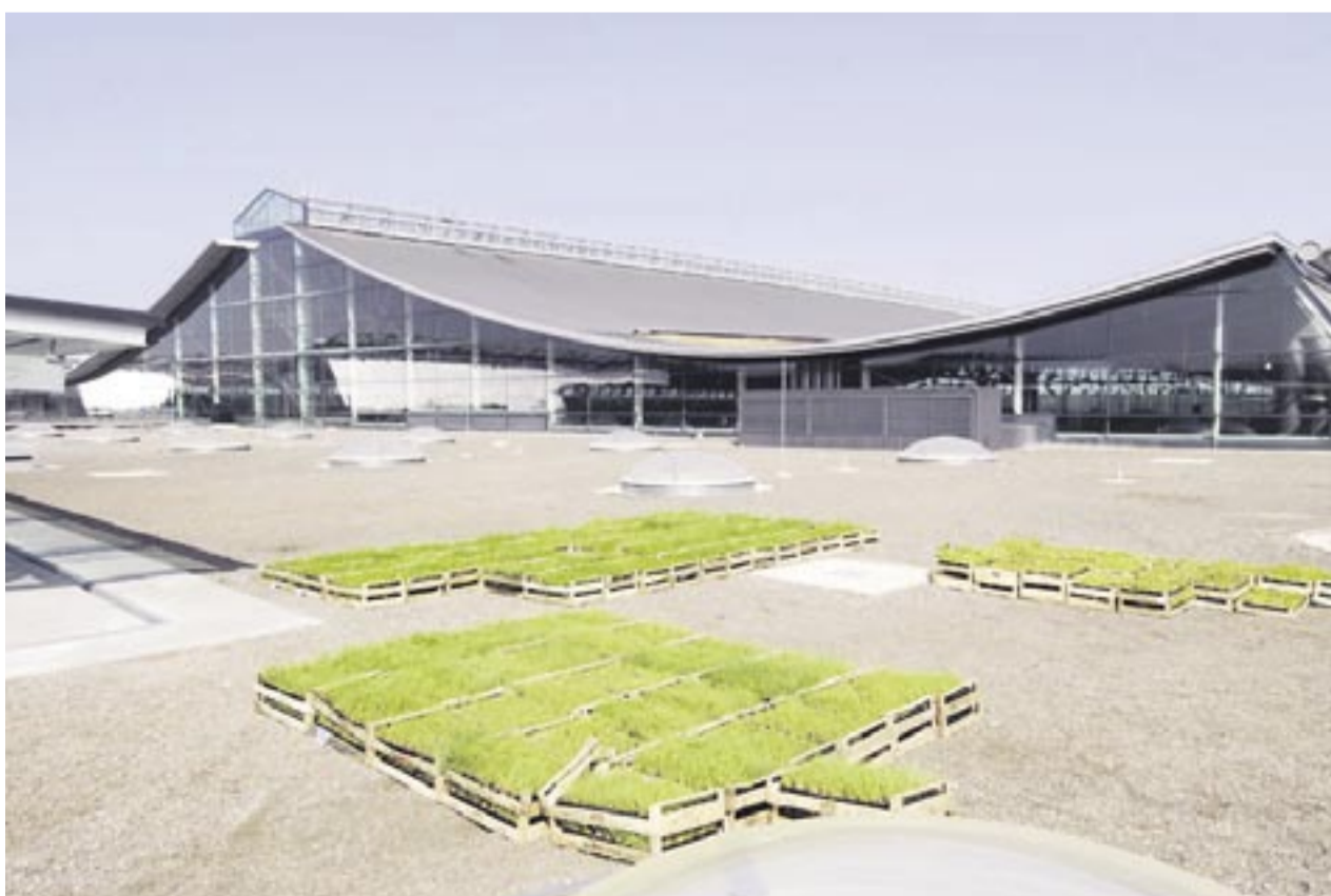
Dachbegrünung der neuen Messehallen in Stuttgart.
