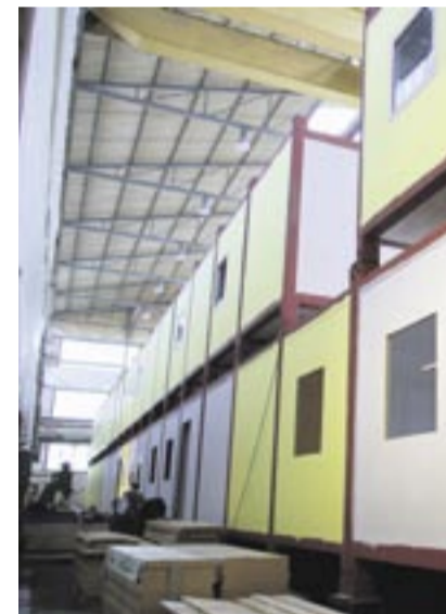
In einer Bremerhavener Werft sind die rund 120 Wohn- und Arbeitscontainer der neuen Antarktis-Station probeweise und für die Innenausstattung aufgebaut worden. Foto: Viega
