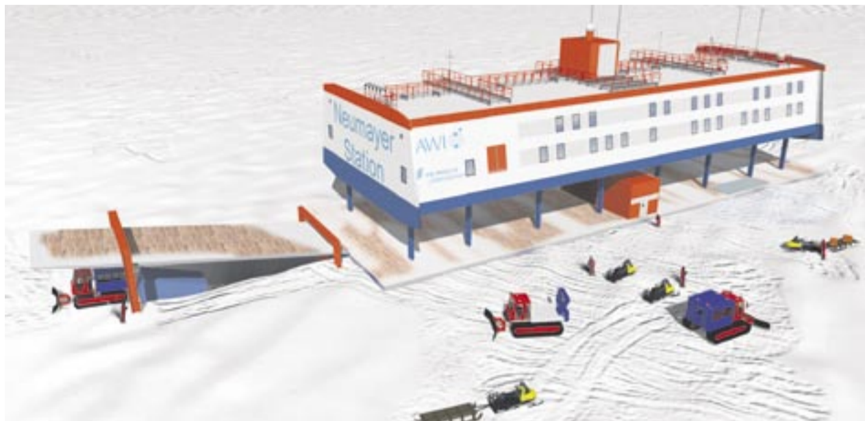
Auf hydraulisch anhebbaren Stelzen trotz die „Neumayer III“ künftig den immensen Schneelasten und kann deshalb fast doppelt so lange wie ihre Vorgängerin genutzt werden. Grafik: AWI
