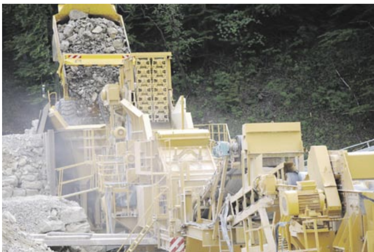
Im großen Brecher wird das ausgehobene Gestein zerkleinert.
