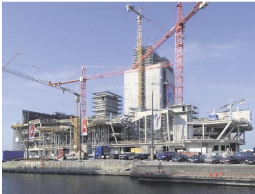
Ursprünglich wollte man nicht zuviel Schalung auf der Baustelle haben, die Vorhaltung war entsprechend ausgetüftelt und abgestimmt, die vorhandene Schalung ständig im Einsatz.
