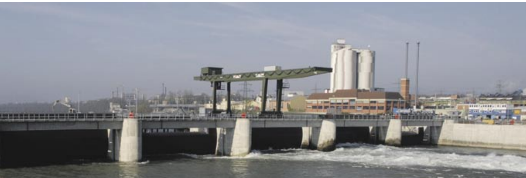
Stauwehre in Betrieb. Sie übernehmen die Staufunktion des alten Wehrs.
