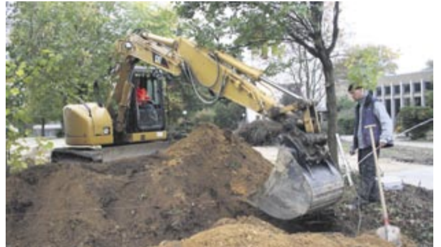
Der Cat-Kurzheckbagger gräbt ein Loch neben dem Parkplatz, wo während der Baumaßnahme eine Bautafel aufgestellt wird.
