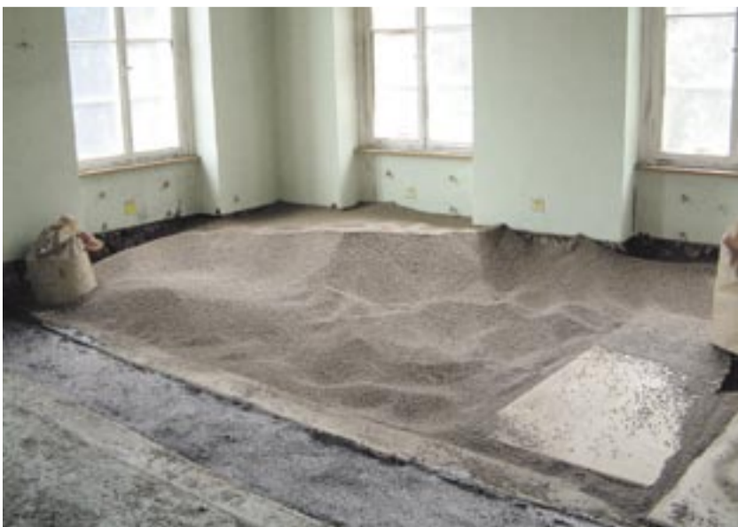
Eingesetzte Liapor-Schüttung: Der verwendete Blähton verträgt sich nicht nur mit dem Denkmalbau, sondern ist leicht zu verlegen und wirtschaftlich.
