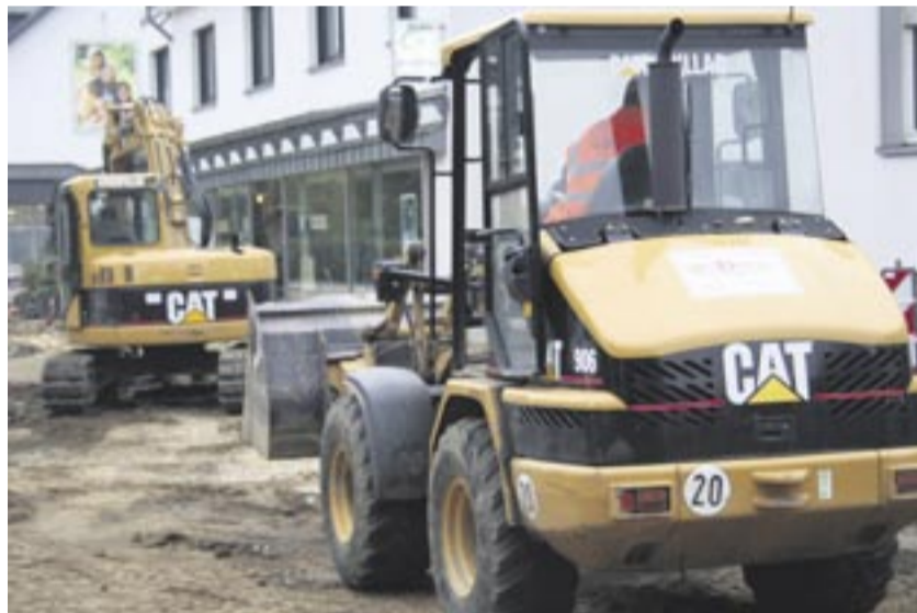
Auf der Baustelle in Bohmte gibt es wenig Platz. Da kommen der Baufirma die kompakten Baumaschinen von Caterpillar zugute. Foto: Zeppelin
