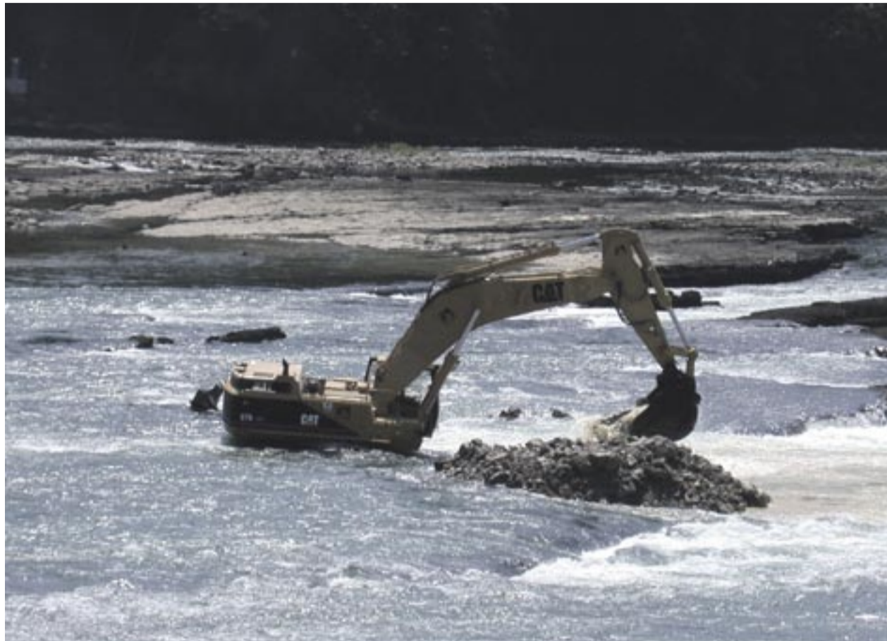
Der niedrige Wasserstand im August 2003 begünstigte die Gründung der Baustelle.
