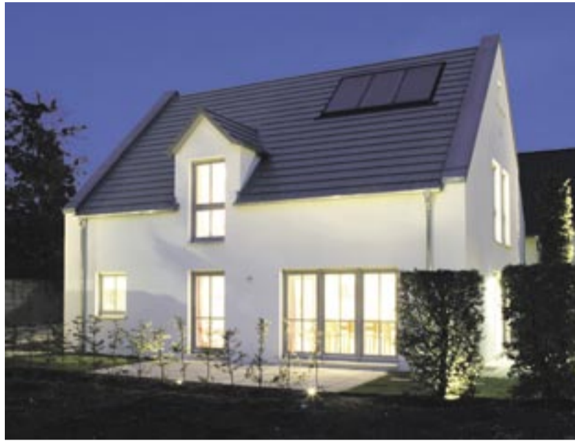
Ein modernes Wohnhaus, das der aktuellen EnEV entspricht. Foto: BetonMarketing West
