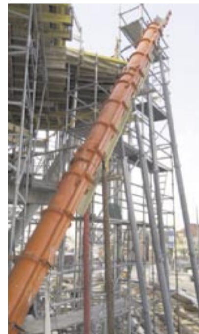
Stützen spielen in diesem Baukörper eine herausragende Rolle. Schräge, in einem Winkel von 35 Grad aufgehende Rundstützen mit einem Durchmesser von 70 Zentimeter dominieren die Außenbereiche.
