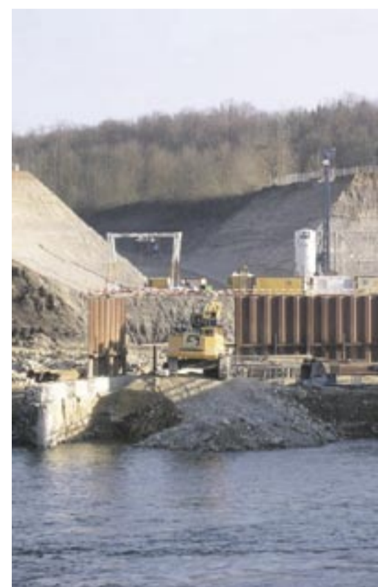
Die zweite Baugrubenumschließung ist abgebaut, die
