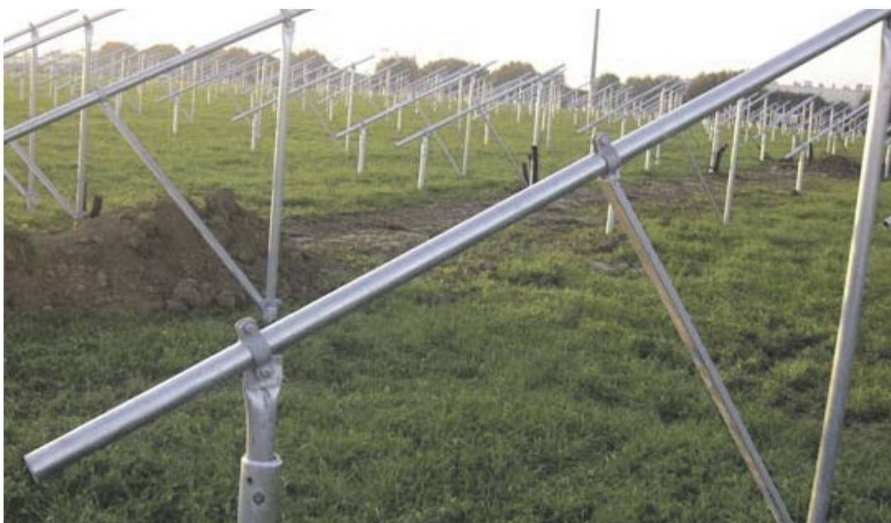
Stahlpfähle bilden das Fundament für die Solarmodule.
