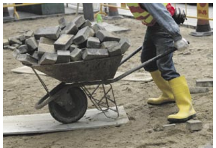
Arbeiten in unangenehmer Körperhaltung ist auf der Baustelle alltäglich.
