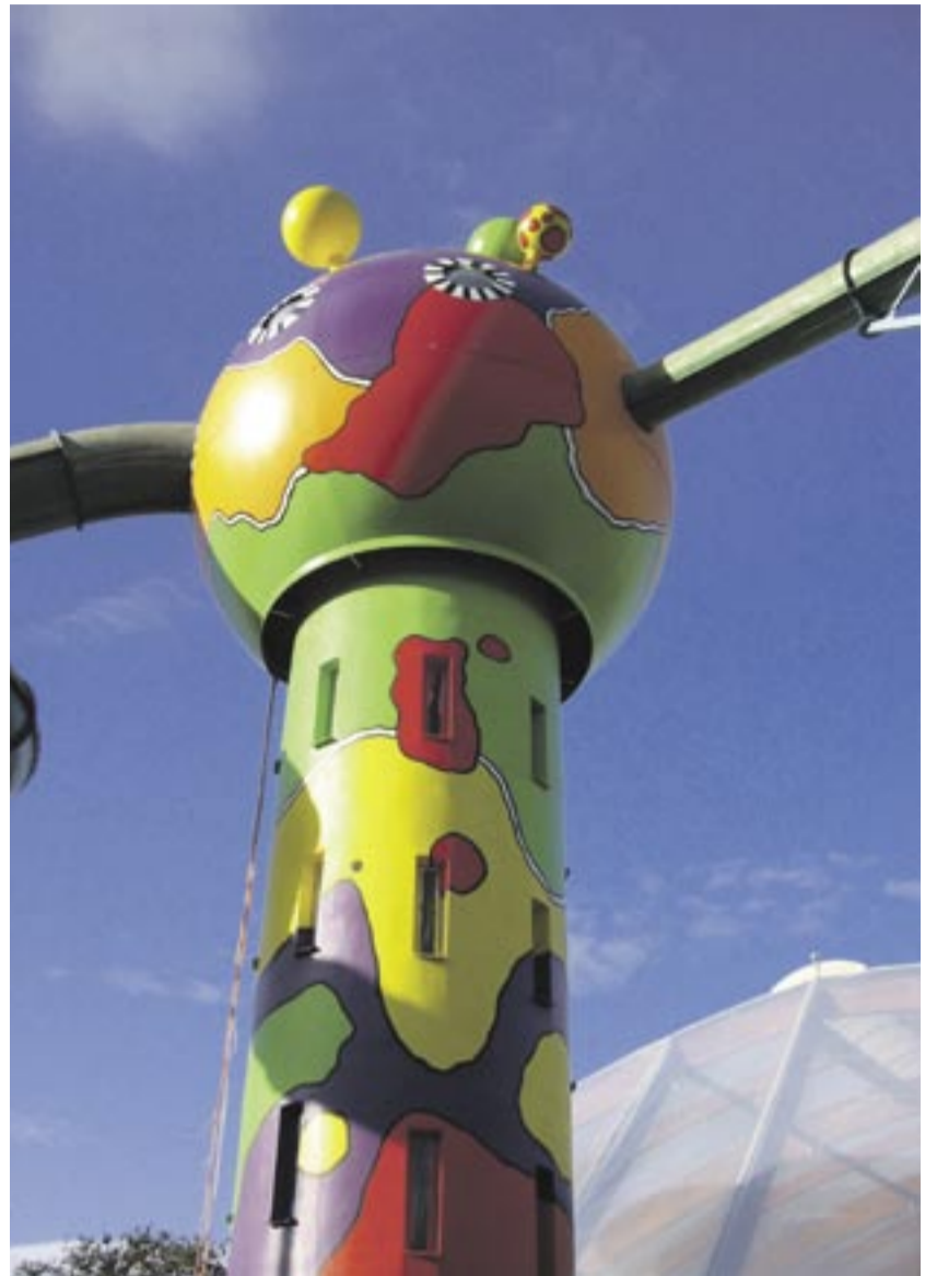
Die Kuppel des neuen Rutschenturms im Weinheimer „Miramar“ setzt weithin sichtbare Akzente. Fotos: Caparol Farben Lacke Bautenschutz
