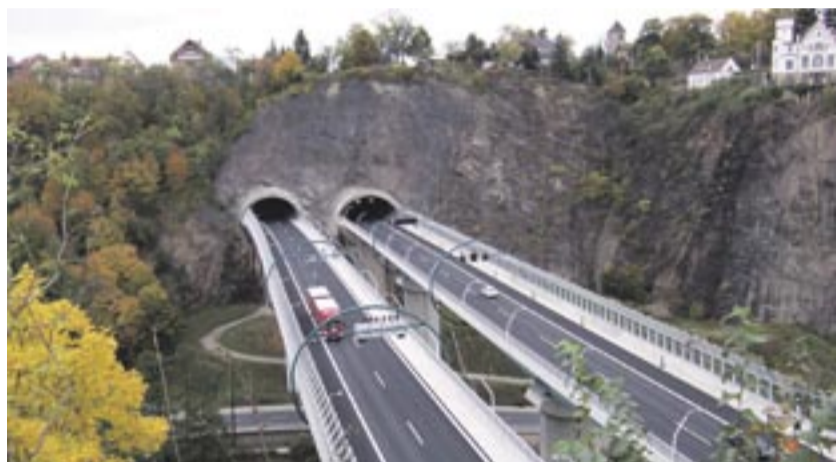
Die Weißeritztalbrücke an der A17.
