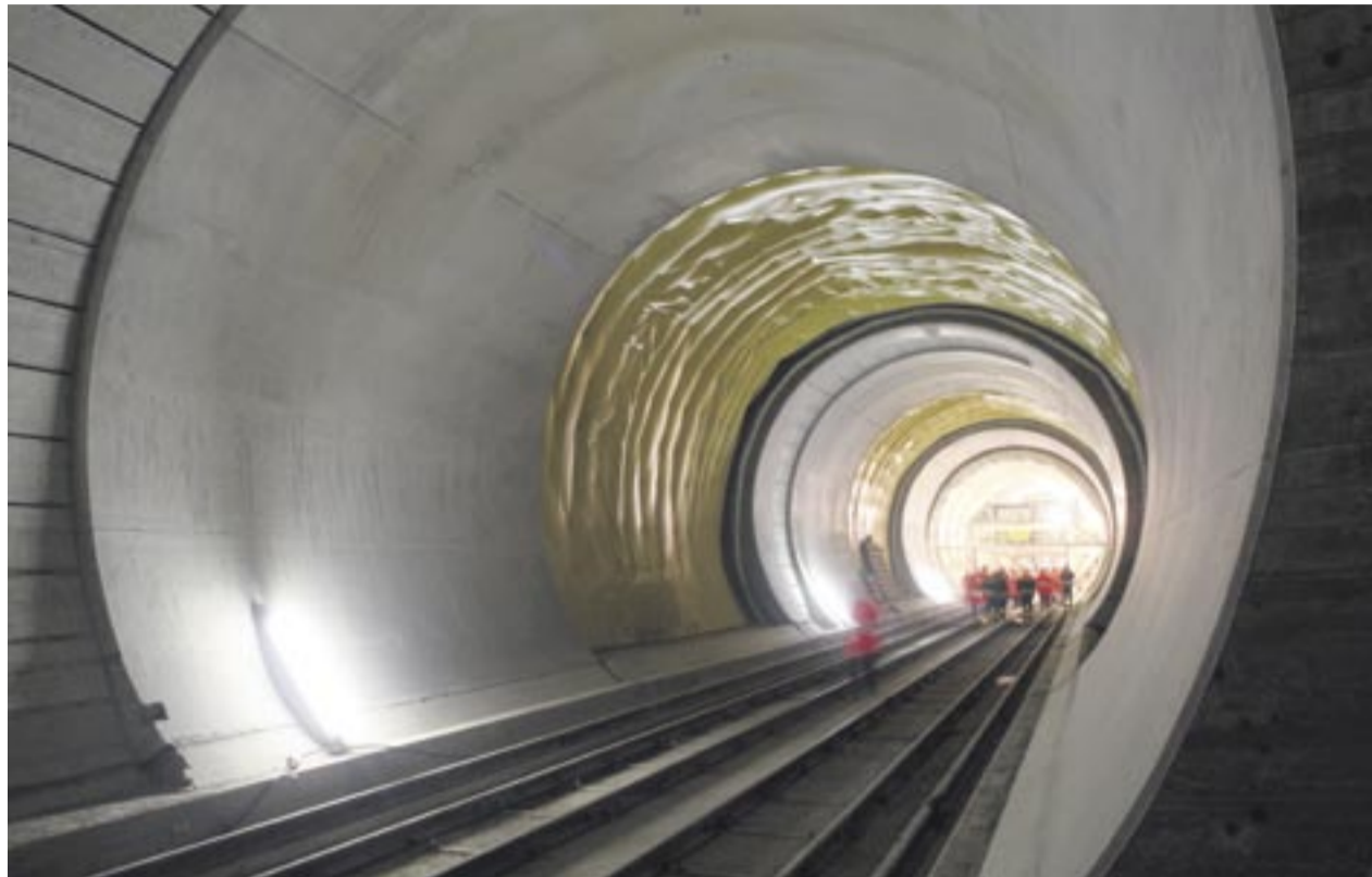
Betonierte Innenschale, Teilabschnitt Sedrun.
