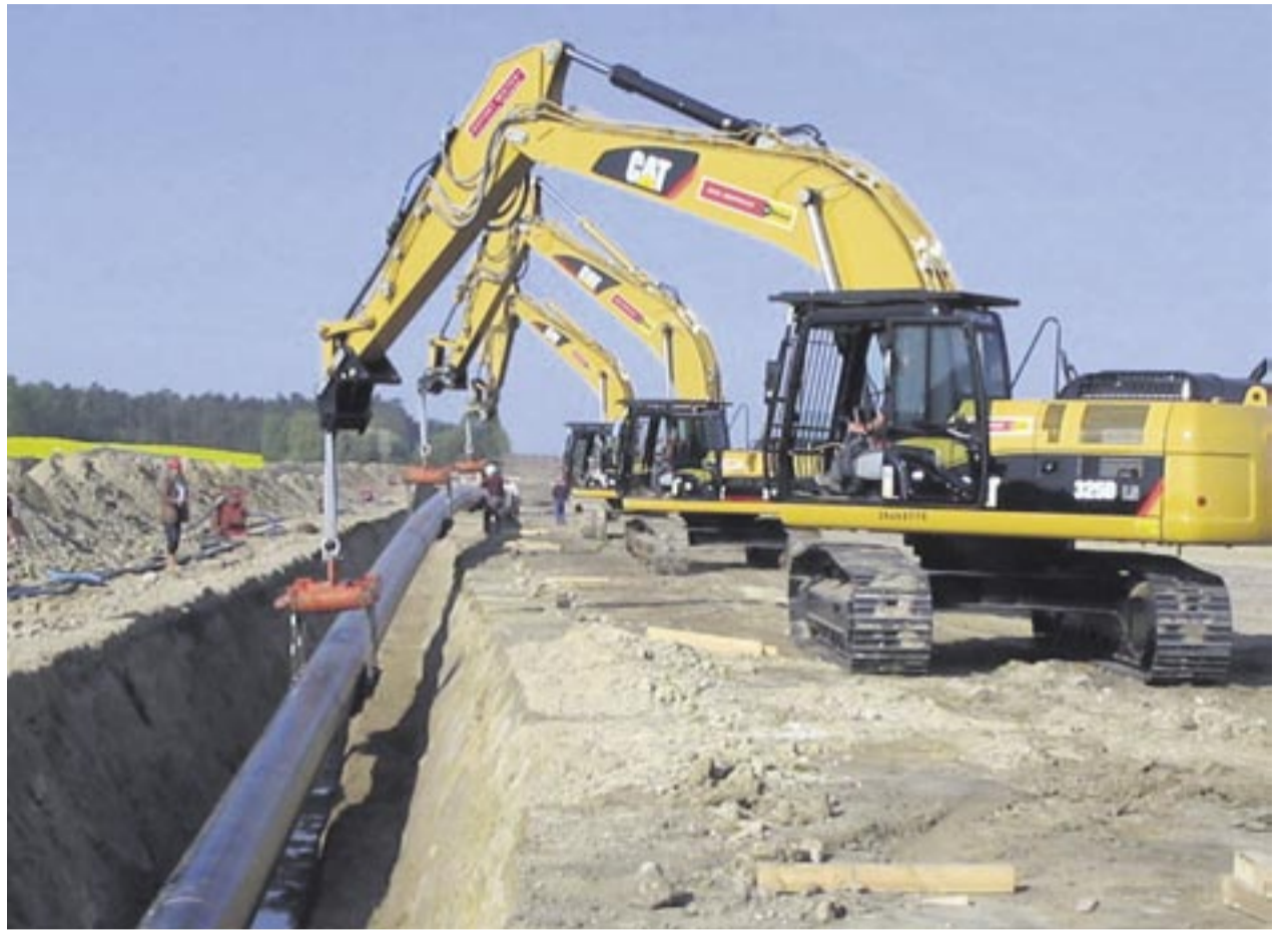
Ohne Beeinträchtigung des Flugbetriebs: Mit Mietmaschinen aus der MVS-Zeppelin-Mietflotte verlegte RAKW über 14 Kilometer Rohrleitungen auf der BBI-Baustelle um. Foto: MVS Zeppelin
