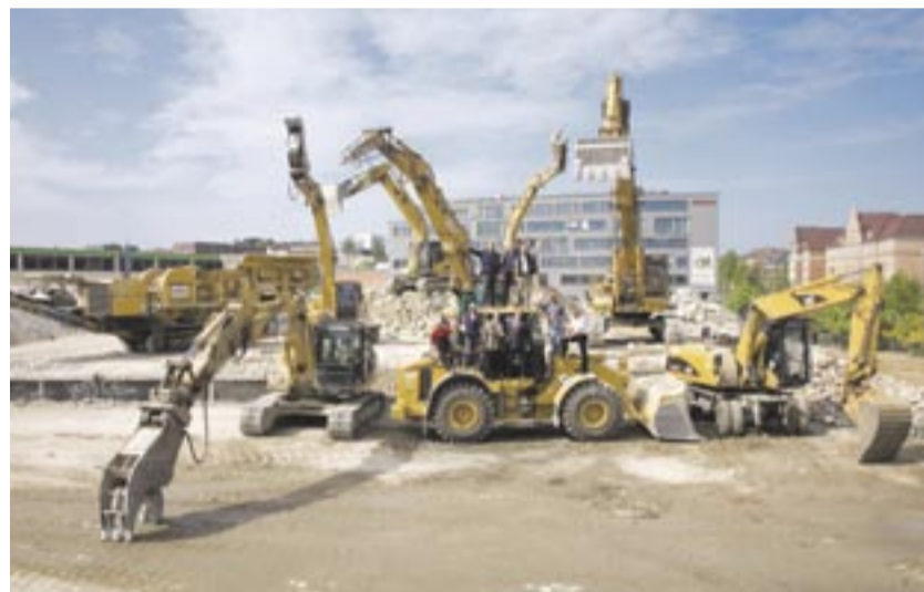
Ein Ausschnitt des Cat-Fuhrparks, wie er bei einer Abbruchbaustelle in der Stressemannstraße eingesetzt wurde. Foto: Stephan Griebel
