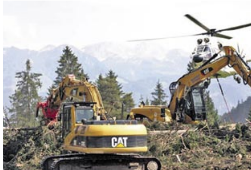
Mit Hubschrauber und Cat-Baumaschinen werden die Schäden von Kyrill beseitigt. Foto: Zeppelin
