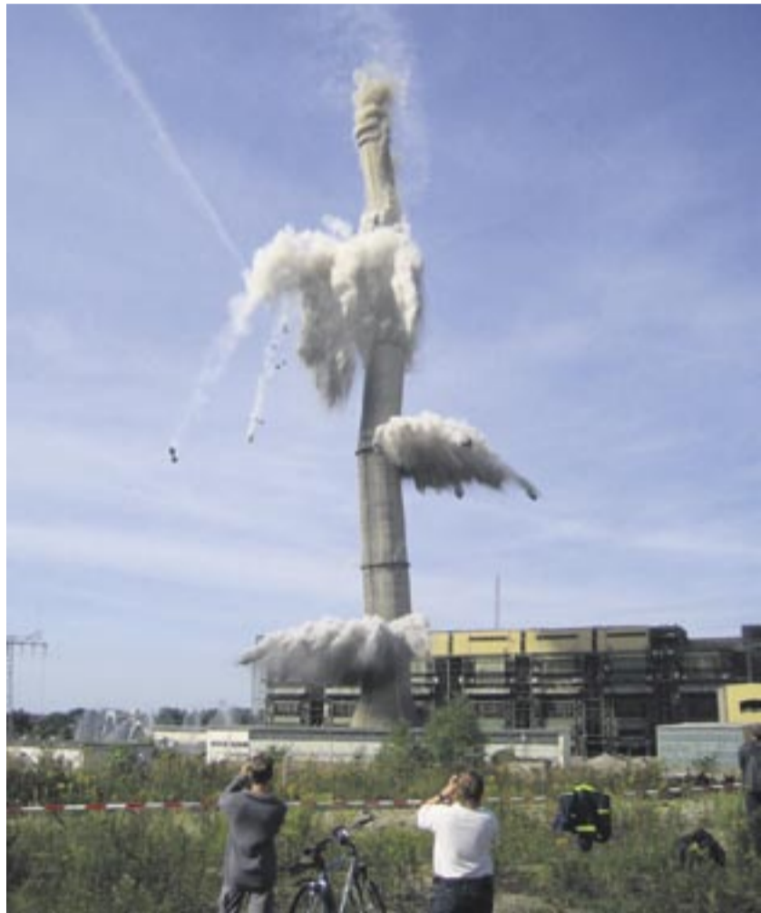
Richtig sprengen will gelernt sein. Den 300 Meter hohen Schornstein in Lippendorf hat das Unternehmen TVF in die Luft gejagt. Foto: Deutscher Abbruchverband
