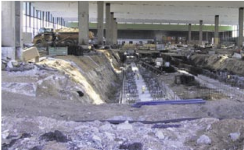
Eine ehemalige Posthalle des Hauptbahnhofes in Frankfurt sollte so umgebaut werden, dass aus der 21 000 Quadratmeter großen Stahlbetonhalle eine neugleisige S-Bahn-Werkstatt auf neuestem Stand der Technik wird. Fotos: iwb
