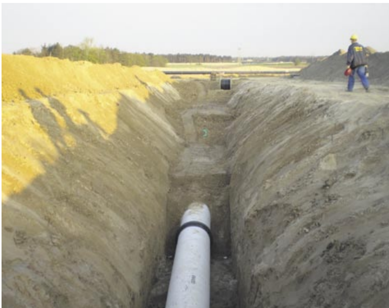
Seit Februar 2007 werden für den Bau des BBI Abwasserdruckleitungen verlegt. Foto: TRP Bau
