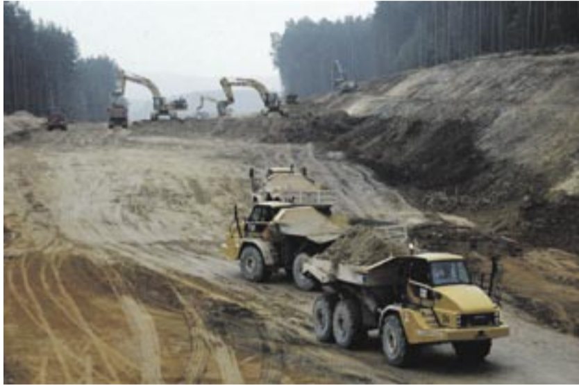
Rund drei Millionen Kubikmeter Erdreich müssen auf der Baustelle insgesamt bewegt werden. Fotos: Petra Beer-Dausch
