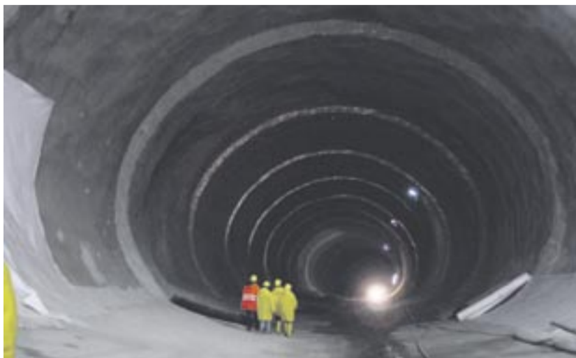
Einer der vier Tunnel auf der A17, die von Cegelec technisch ausgerüstet wurden.
