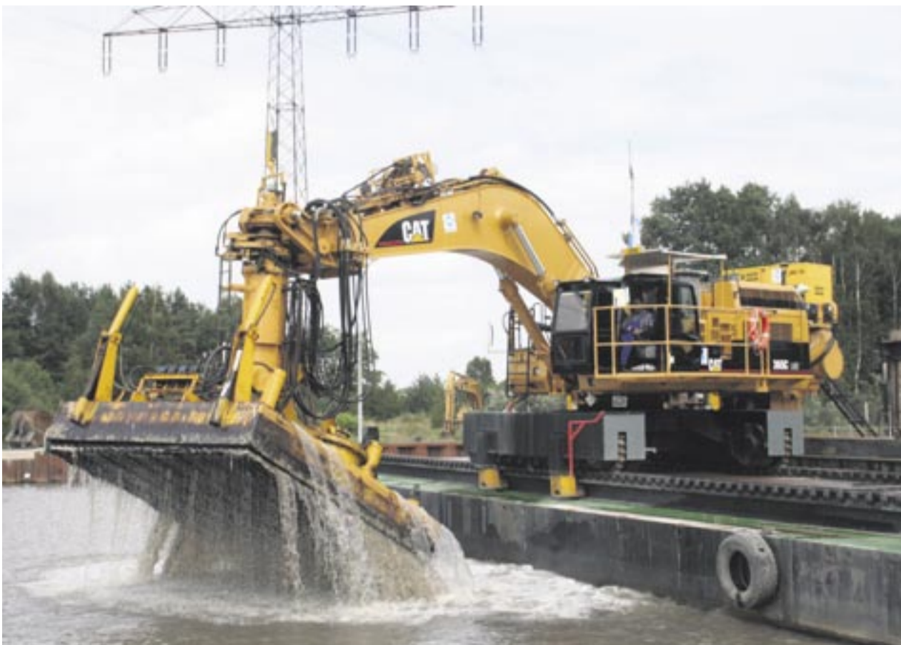
Nach dem Andrücken der Tonplatte hebt der Ausleger des Cat 365 C die Tonglocke wieder aus dem Wasser des Oder-Havel-Kanals.
