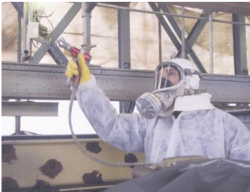
Einen vierschichtigen Korrosionsschutz hat die Torgauer Brücke bekommen.
