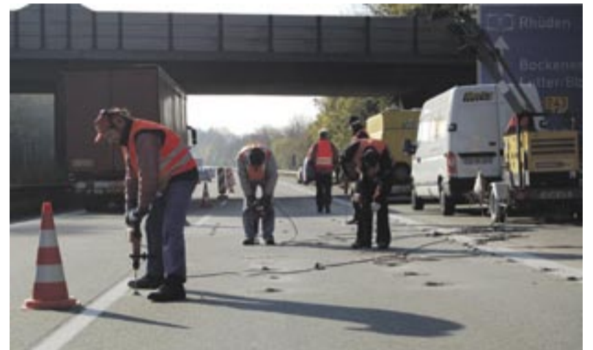
Durch die zwölf Millimeter großen Bohrlöcher wurde das Zweikomponenten-Expansionsharz direkt unter die Betonplatten gepresst. Die Hohlräume wurden so aufgefüllt und die abgesackten Platten wieder angehoben.
