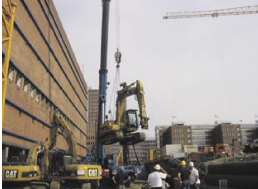
Stehen in Hamburg Abbrucharbeiten an, dann ist das Traditionsunternehmen meist mit von der Partie, wie hier beim Bau der Elbphilharmonie. Dazu wurden fünf Cat-Bagger mit einem Autokran auf das Dach des Kaispeichers gehoben. Foto: ReGe Hamburg
