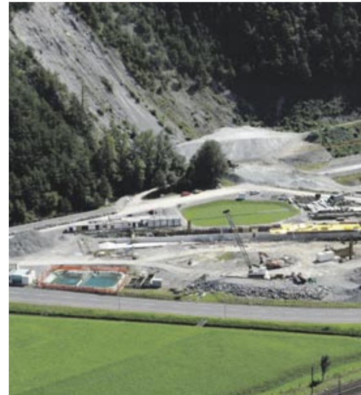
Fotos: AlpTransit Baustelle Gotthard-Basistunnel, Nord.
