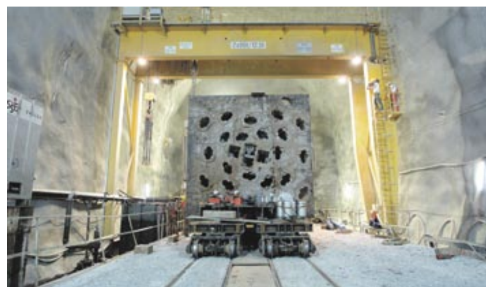
Demontage Tunnelbohrmaschine, Teilschnitt Amsteg.
