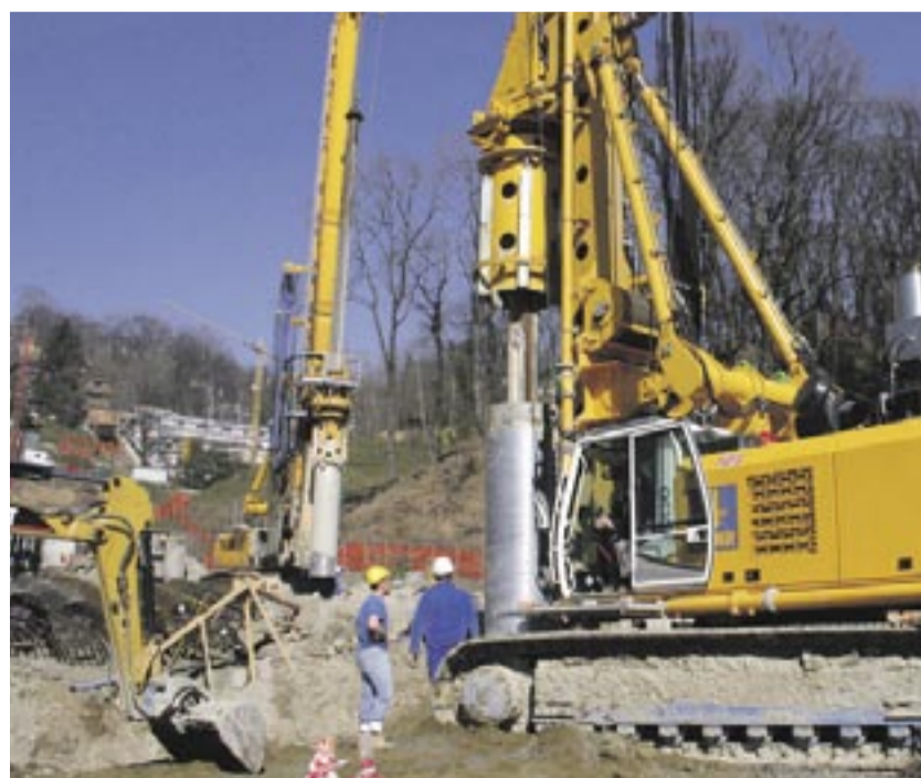
Bau des „Mischwassersammlers links der Isar“ Bauabschnitt „Spartentunnel Reichenbachbrücke“.
