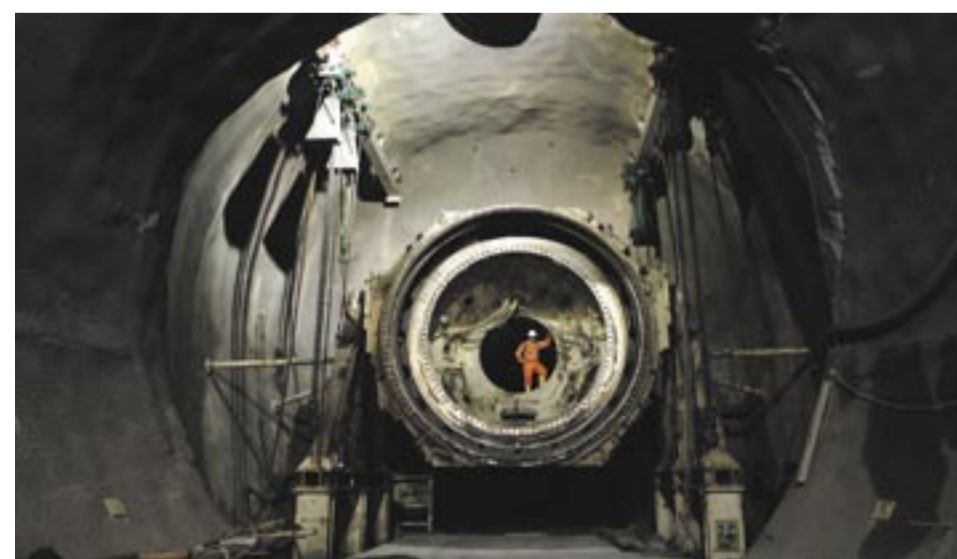
Demontage Tunnelbohrmaschine, Teilabschnitt Faido.
