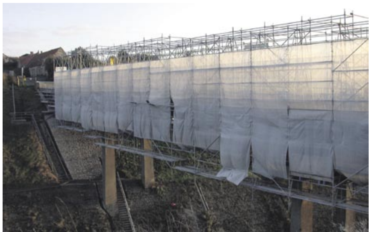
Weil Brücken stark den Tausalzen ausgesetzt sind, leidet ihre Stahlkonstruktion.
