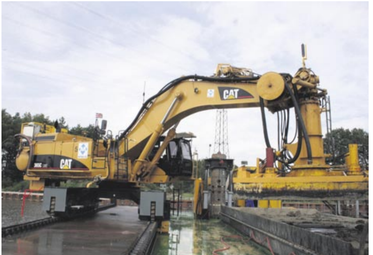
Zahlreiche Umbauten gingen einher, bevor der Cat 365 C auf dem Ponton eingesetzt werden konnte. Unter anderem musste die Maschine an die Fahrspur des Ponton angepasst werden. Fotos: Zeppelin
