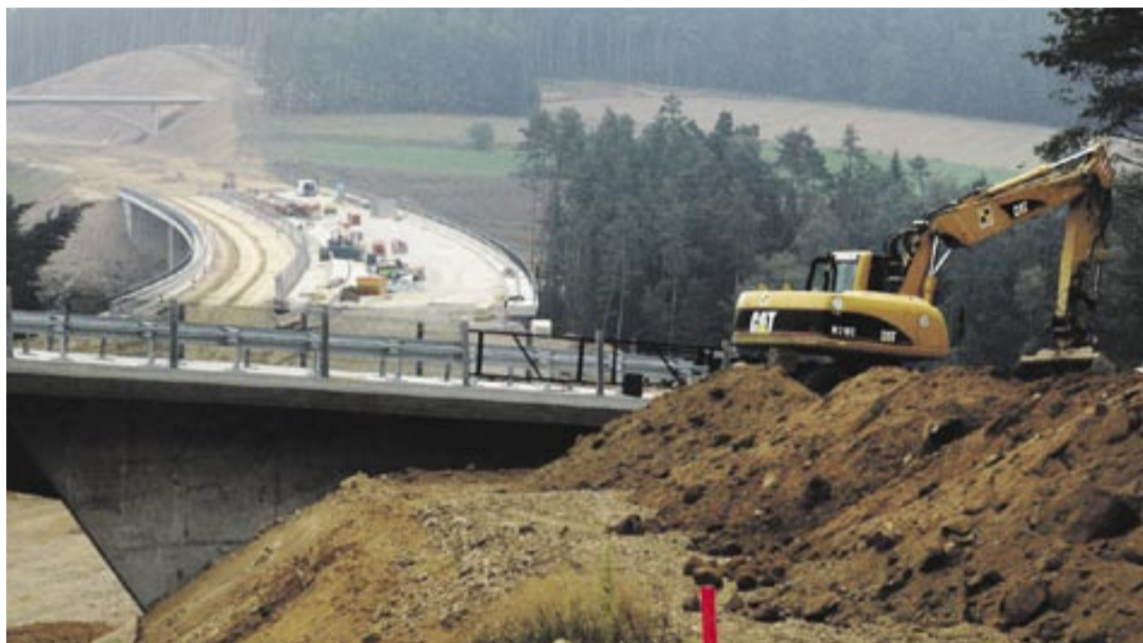
Von den insgesamt 32 Brückenbauwerken sind 29 fertig gebaut. Aber es laufen an vielen Stellen noch Restarbeiten.
