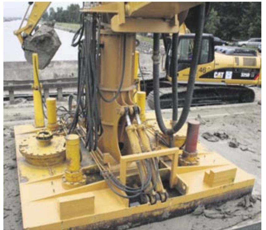
Die Tonglocke saugt mittels Vakuum eine vier mal vier Meter große Platte aus dem Tonbett an.
