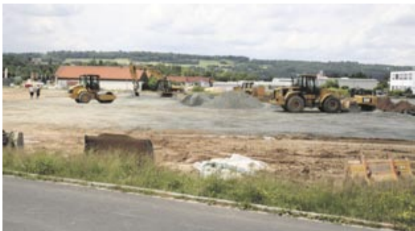
Auf der Baustelle in Weidenfels sind mehrere Cat-Maschinen aus dem Fuhrpark von Richter im Einsatz. Auf 20 000 Quadratmetern Fläche müssten etwa 35 000 Kubikmeter Erde bewegt werden.
