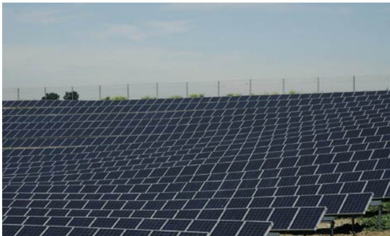
Die Fotovoltaikanlage ist einer von drei Bausteinen der Rekultivierungsmaßnahmen, die realisiert werden.
