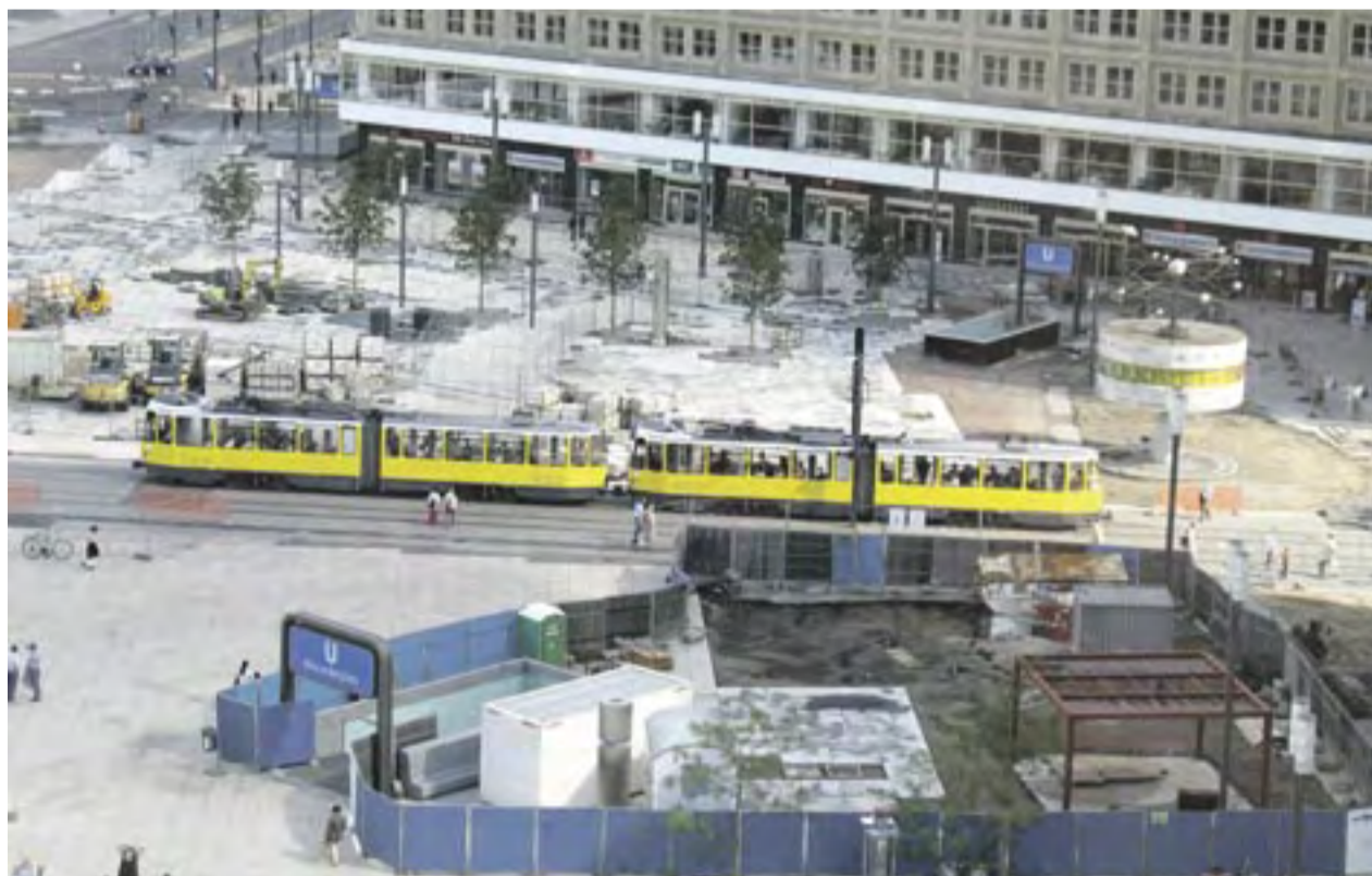
Seit Mai dieses Jahres ist auch die zweite Straßenbahntrasse der Tram Alex II fertig gestellt. Die Pflasterarbeiten rund um die U-Bahn-Eingänge sind in vollem Gange.
