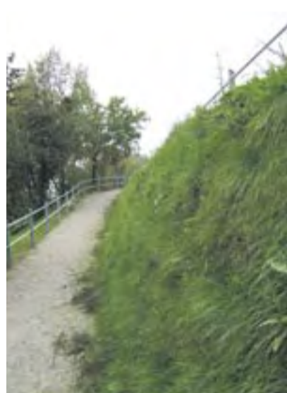
Bereits drei Monate nach Fertigstellung sprühte auf dem Steilhang sattes Grün. Fotos: Tensar
