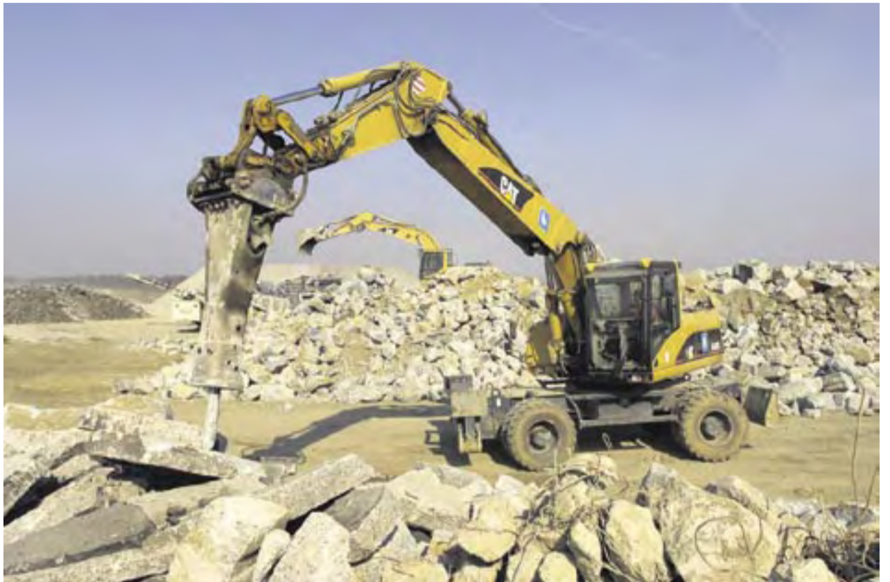
Den Abbruch des zehn Meter breiten Streifens der bestehenden Startbahn erfolgte mit Cat-Geräten, die den Betonplatten zu Leibe rückten.
