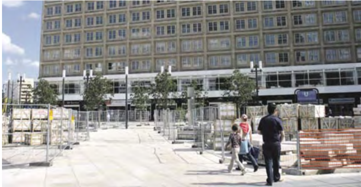
Im Februar letzten Jahres konnte mit der Neugestaltung der Platzoberfläche nach den Plänen des Architekturbüros Gerkan, Marg und Partner begonnen werden. Vor dem Berolinahaus ist die Platzgestaltung fast abgeschlossen.
