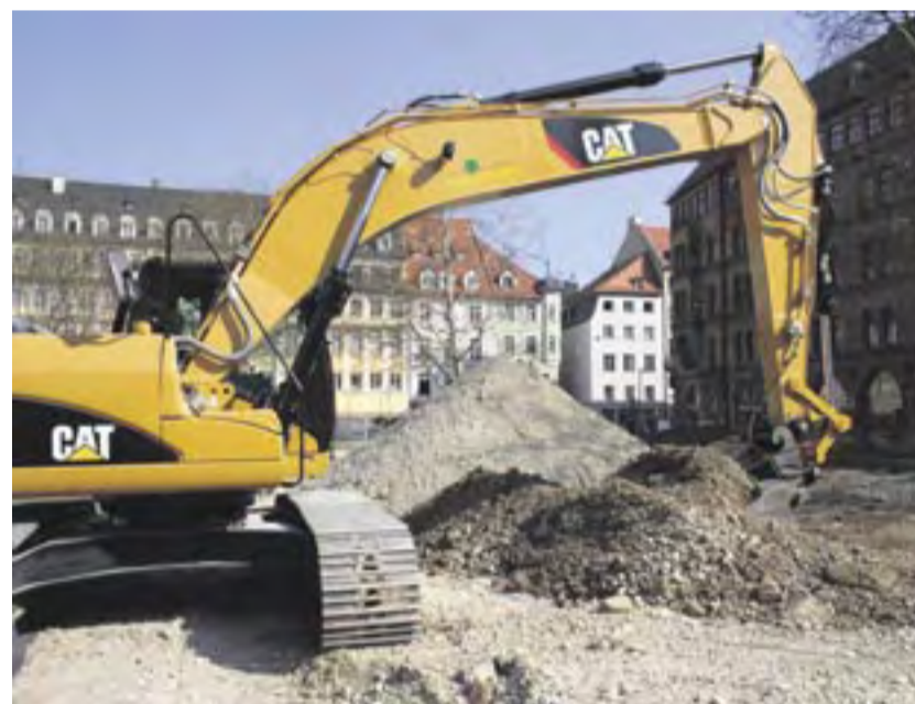
Tausend Kubikmeter Rohboden mussten gelöst und verladen werden.
