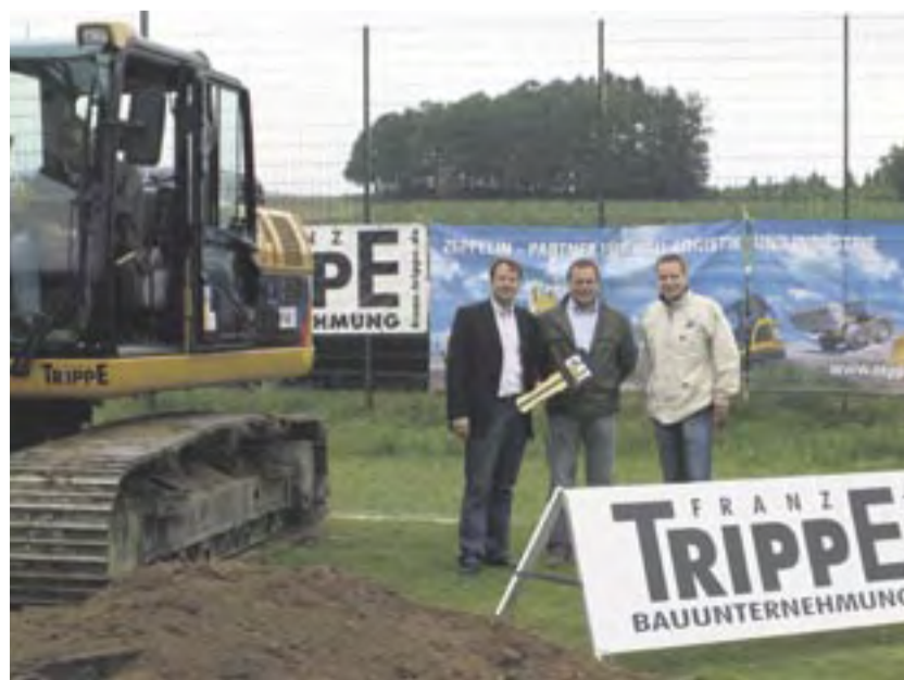
Ende Mai stand der Spatenstich für den Bau des Kunstrasenplatzes in Arpe an. Bei dieser Gelegenheit weihte die Firma Franz Trippe ihren neuen Cat-Bagger gleich ein, mit dem der Sportplatz samt neuem Kunstrasen gebaut wird. Von links: Zeppelin-Verkaufsleiter Christian Kutscha, Bauunternehmer Stefan Trippe und Zeppelin-Maschinenverkäufer Jens Rehse.
