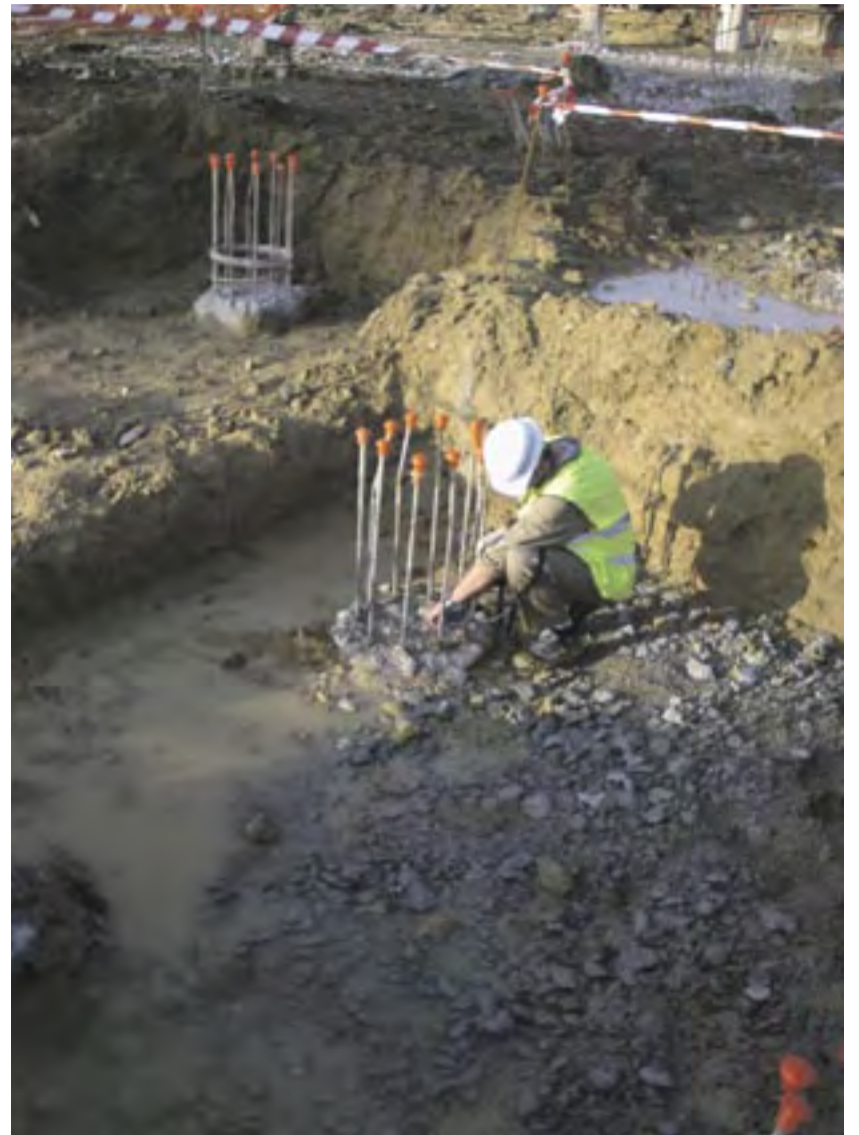
Pfähle werden überprüft.
