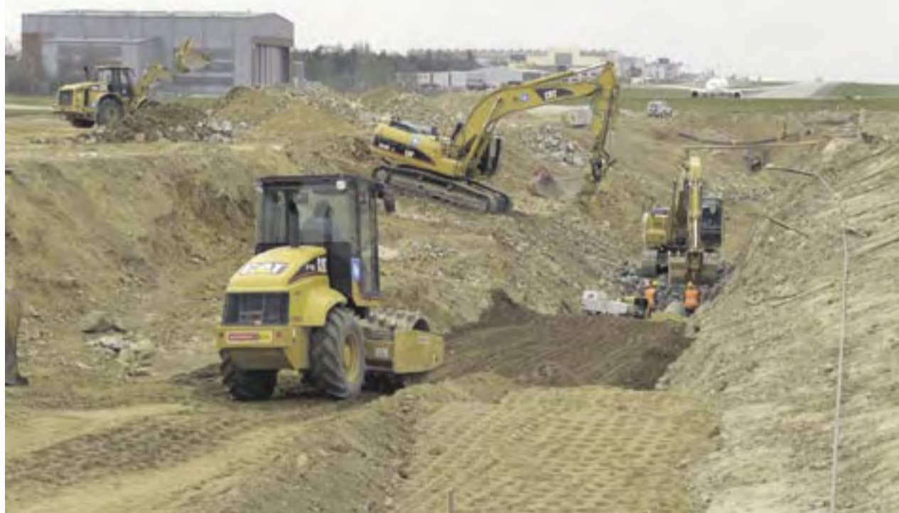
Cat-Maschinen beim Anlegen der Entwässerungsschächte.
