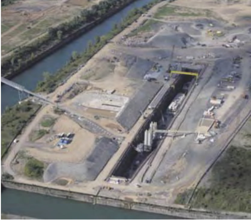
Strabag baut im Auftrag der Provinz Ontario einen 10,4 Kilometer langen Stollen. Fotos: Strabag
