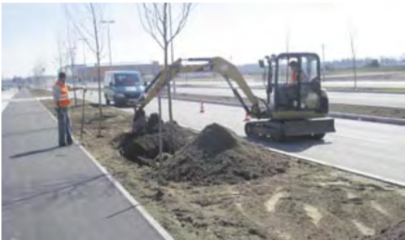
Beim Anlegen eines grünen Seitenstreifens im Gewerbegebiet Freiham.
