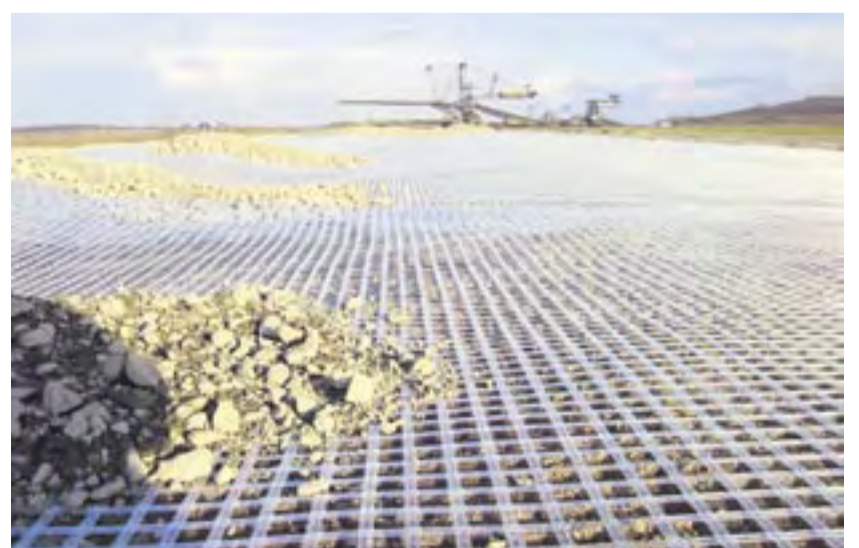
Das Geogitter von Naue soll das Planum stabilisieren.
