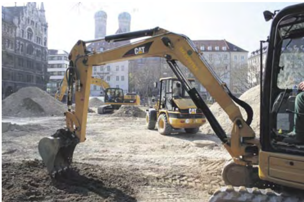
Baumaschinen im Einsatz beim Vorbereiten des Untergrunds für das Anlegen der Grünfläche.
