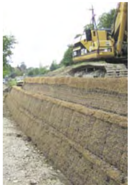
Als Schutz gegen Erosion und um die Vegetation zu unterstützen, wurden hinter den Stahlgitterelementen Kokosjutmatten sowie Mutterboden eingebaut.
