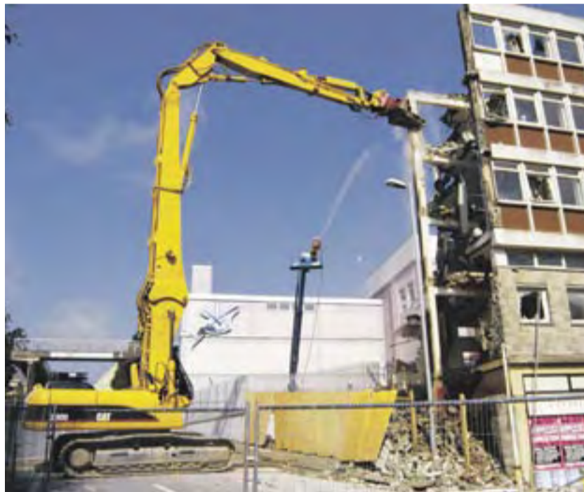
Bei Abbruch und Recycling ist der Longfront-Kettenbagger 330 D von Caterpillar ein zuverlässiger Helfer.
