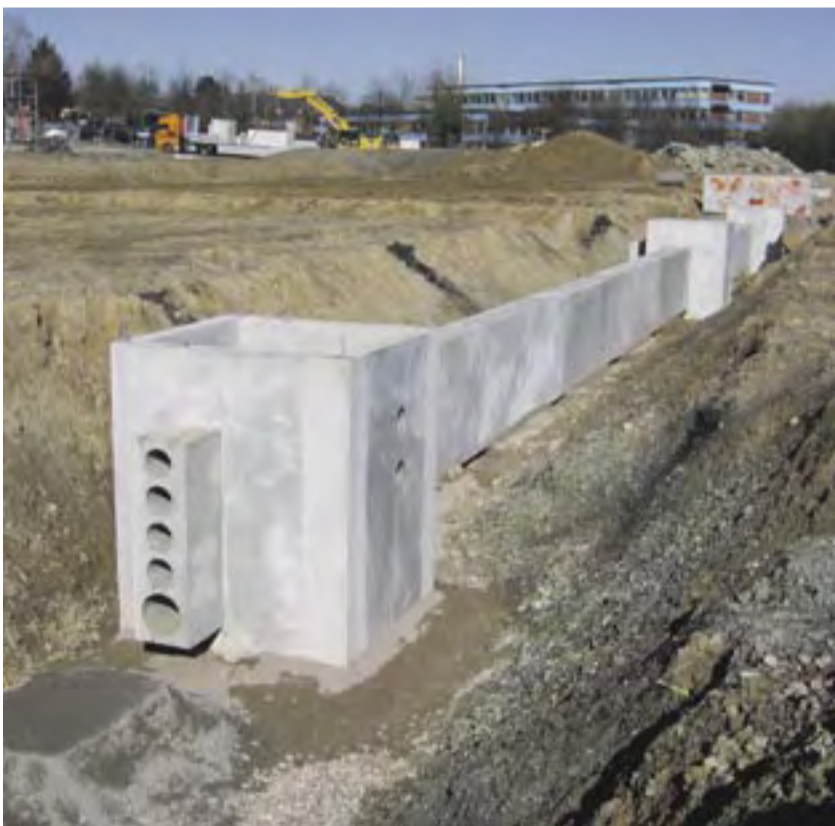
Neubaugebiet Gänsewinkel: Für das Verlegen der im Betonwerk vorgefertigten Schacht- und Kanalelemente ist kein großer Aufwand erforderlich. Die Wohnhäuser können ohne große Umwege angeschlossen werden. Foto: BetonMarketing West
