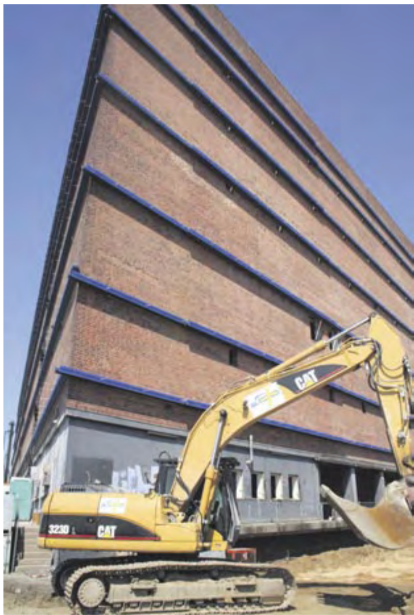
Noch sind es nur vorbereitende Maßnahmen, die derzeit für den Bau der Elbphilharmonie in Hamburg unter anderem mit einem Cat-Bagger 323D erledigt werden, bevor der Cat 5080 anrückt. Fotos: Zeppelin
