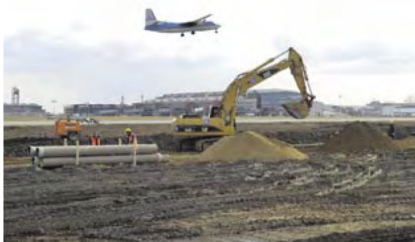
Cat-Bagger beim Einbau des nördlichen Entwässerungssammlers.
