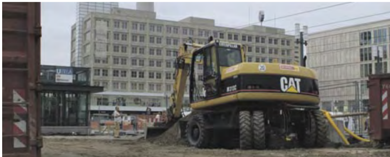
Noch laufen die Bauarbeiten auf Hochtouren, doch schon bald soll die Neugestaltung des Alexanderplatzes abgeschlossen sein.
