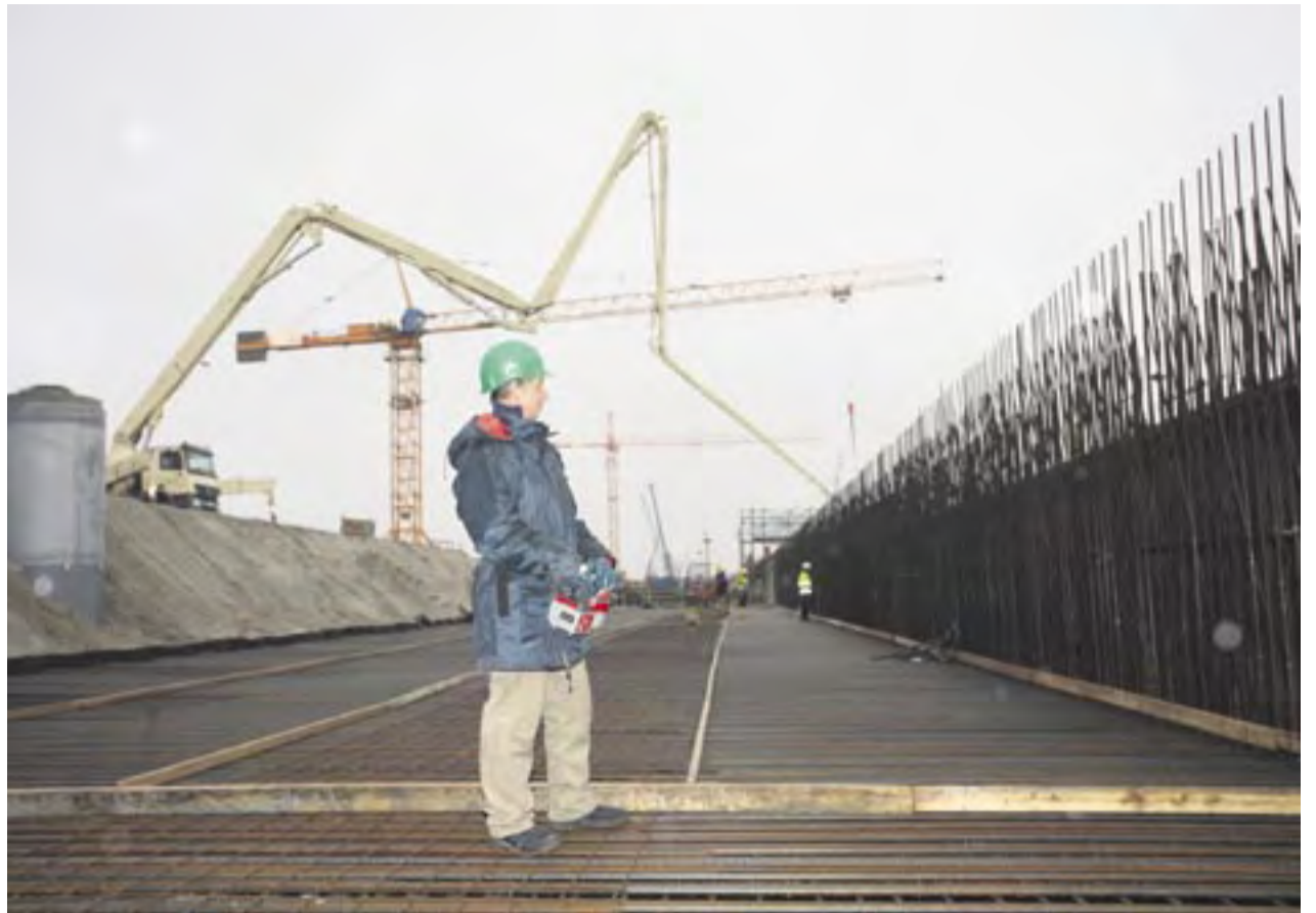
Die Maschinisten haben die Einbaustellen jederzeit im Blick. Muss der Endschlauch durch die enge Armierung gefädelt werden, ist eine feinfühlig ansprechende Funkfernsteuerung von Vorteil. Foto: Putzmeister
