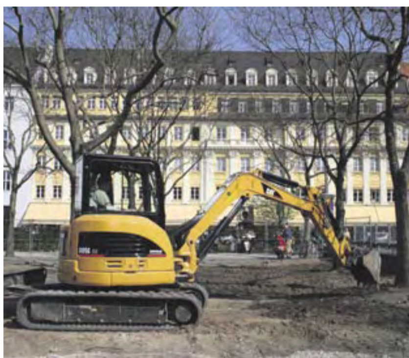
Ein Minibagger war eine der Baumaschinen, die nicht zu schwer waren, um auf der 11 000 Quadratmeter großen Fläche die Galabauarbeiten auszuführen.
