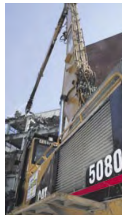
Mit dem Longfront-Ausleger, angebracht am Cat-Bagger 5080, kommen die Abbruchwerkzeuge von Ehlert bis in 41 Meter Höhe.
