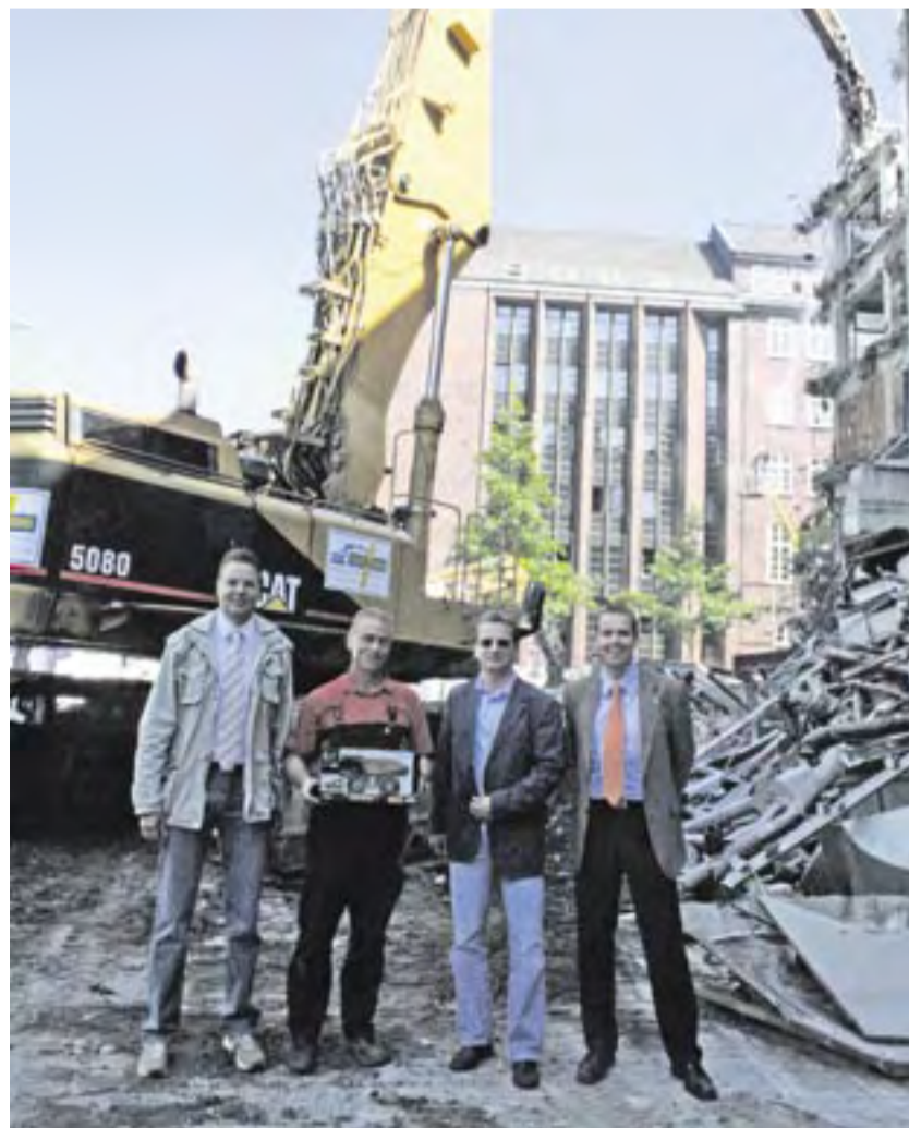
Bei Abbrucharbeiten in der Hamburger Innenstadt kann es schon mal eng werden mit dem Platz. Daher erfordert das Bedienen der Baumaschinen, wie sie hier beim Abbruch des Parkhauses an der Drehbahn im Einsatz sind, Konzentration und Fingerspitzengefühl vom Fahrer Thomas Thielk (zweiter von links). Vor Ort informiert sich über die Baustelle die beiden Geschäftsführer Christian (links) und Matthias Strauch (zweiter von rechts), die das Abbruchunternehmen zusammen mit Hartmut Pieper leiten (nicht auf dem Bild) sowie Zeppelin-Verkaufsleiter, Stefan Groos, Niederlassung Hamburg (rechts).
