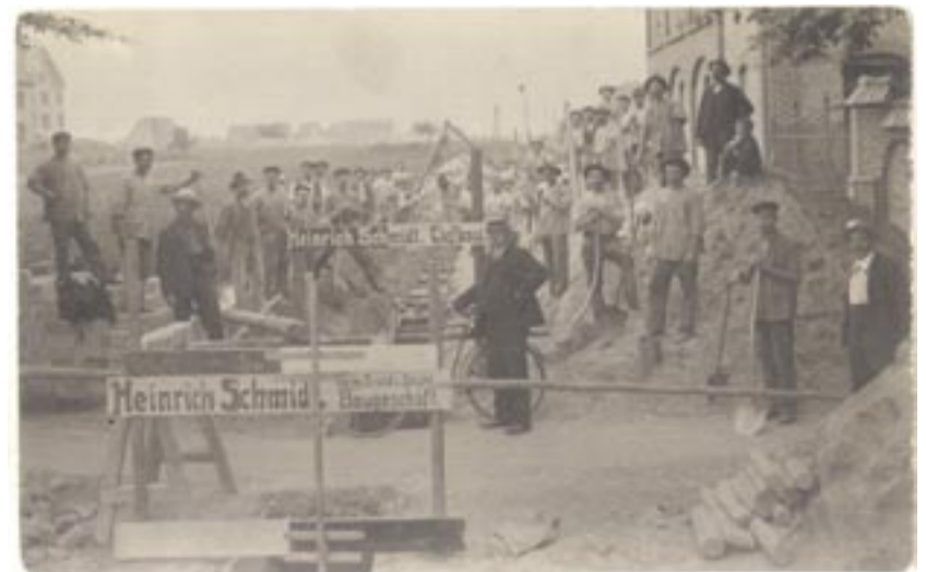
Die Tiefbaufirma Heinrich Schmidt KG besteht seit hundert Jahren.
