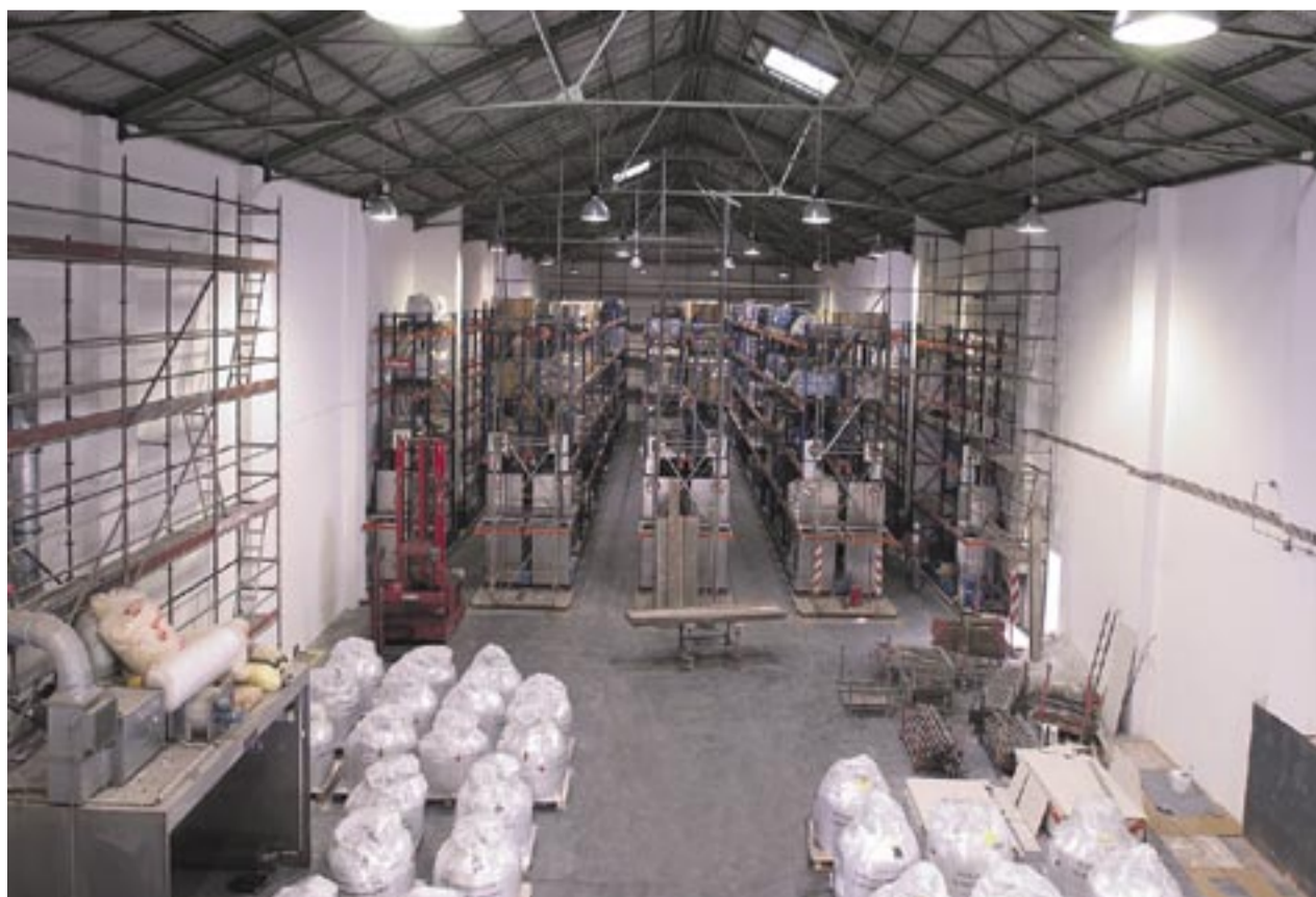
Lediglich der Außenbau blieb stehen. Die alte Fabrikhalle des Chemie-Unternehmens Dynamit Nobel wurde in ein modernes Hochregallager für chemische Produkte umgebaut.
