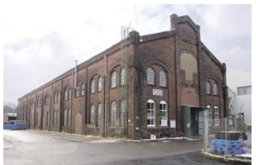
Durch den Einsatz von modernen Trockenbausystemen ist es beim Umbau der zu Anfang des 20. Jahrhunderts gebauten Lagerhalle gelungen, die alte Bausubstanz zu erhalten.
