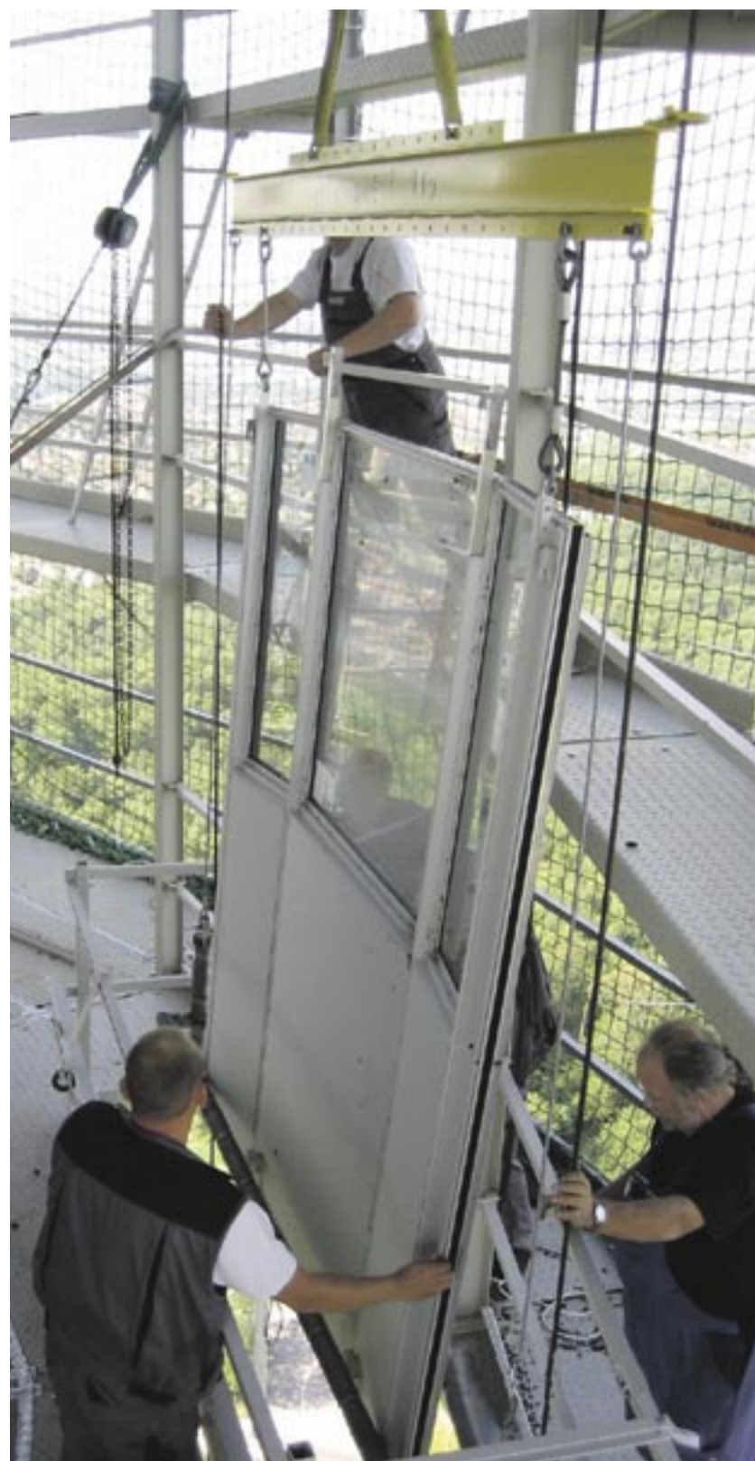
Es konnten ganze, komplett verglaste Fassadenelemente transportiert und eingehängt werden.
