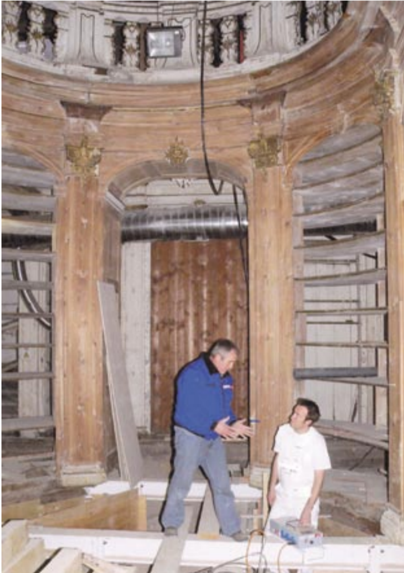
Teilweise erhaltener Dachstuhl der Anna-Amalia-Bibliothek in Weimar während der Trocknungsarbeiten.
