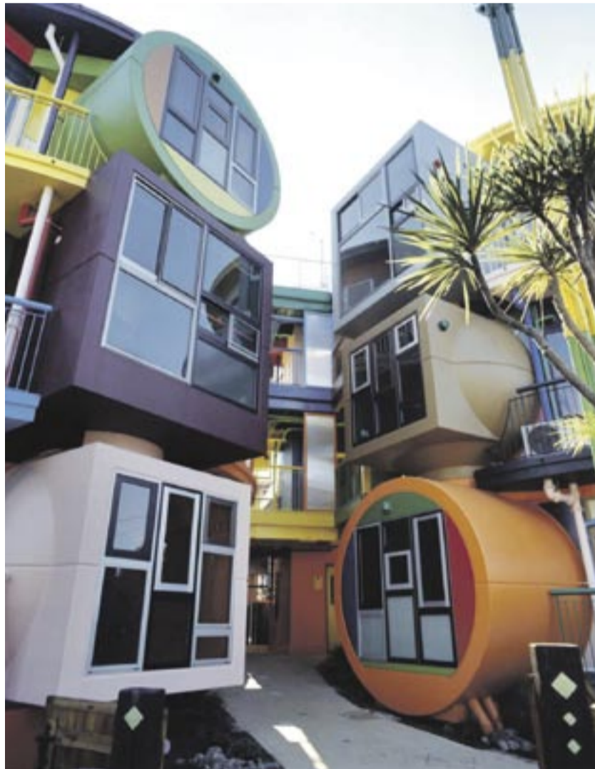
Außenansicht des dreistöckigen Hauses.
