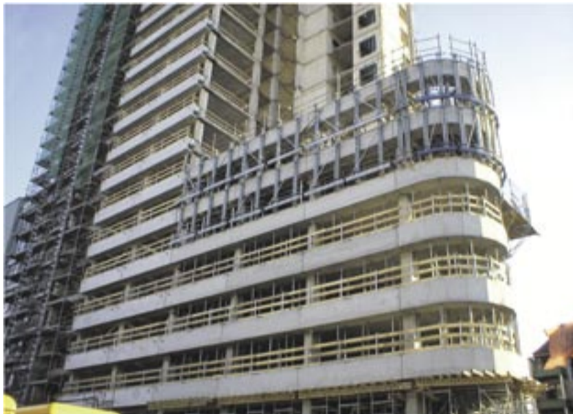
Die Beton-Fertigteile wurden komplett vor das Gebäude an die bestehenden Stahlbetonstützen des Altbaus angehängt. Foto: Wolff & Müller
