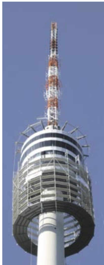
Die Sonder-Gerüstlösung wurde nach erfolgreicher Sanierung wieder komplett abgelassen.
