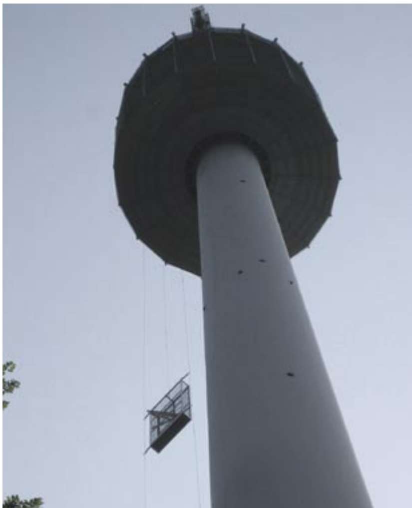
Das Baumaterial wurde mit einem außen liegenden Materialaufzug in die Turmkanzel transportiert.
