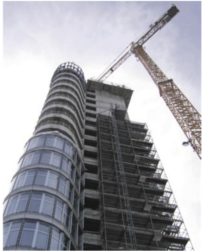
Der „Lighttower“ in Frankfurt am Main: Für die verglaste, halbrunde Ausbuchtung stellte Zuber Beton Fertigteile nach Maß her. Foto: Zuber Beton
