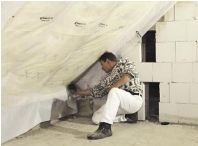
Mit Thermoplan-Dämmung luftdichte Ebene hergestellt.
