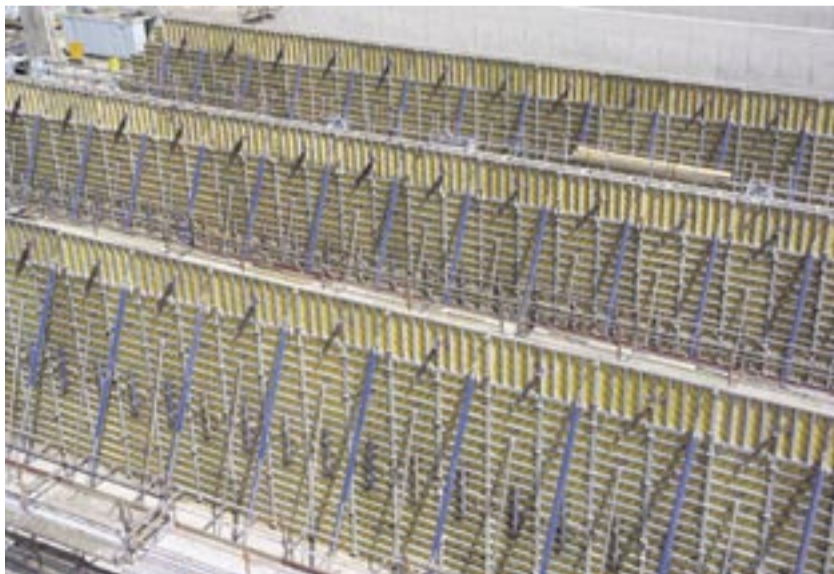
22 Schottwände mit 7,50 Meter Höhe waren herzustellen – praktisch „wie am Fließband“ im Drei-Tagestakt.
