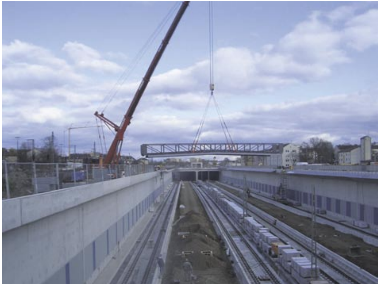
Das Einheben des Fußgängerstegs über den Tiefbahnhof.
