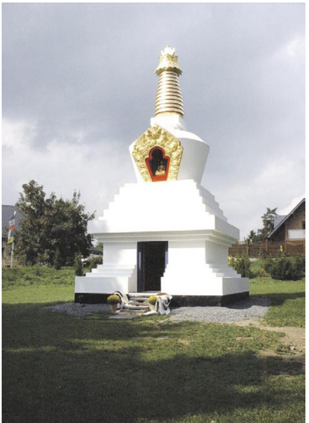
Dieser Stupa in Langenfeld wurde aus maxit-Leichtbeton errichtet.
