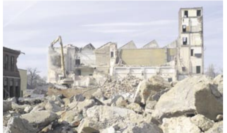
Nach der erfolgreichen Sprengung knöpft sich ein Cat-Bagger die stehengebliebenen Gebäudereste vor.
