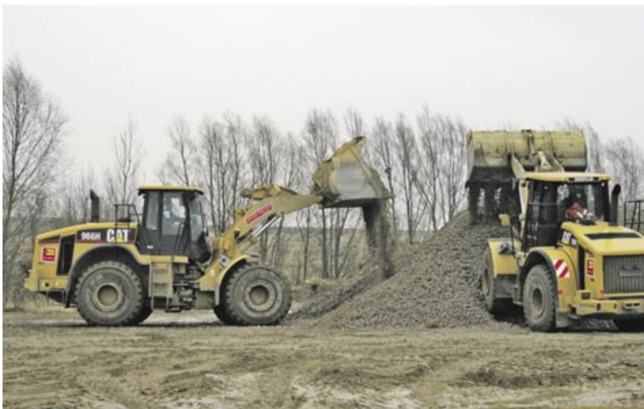
Sie bewegen 150 000 Tonnen Füllmaterial: die beiden Cat-Radlader.
