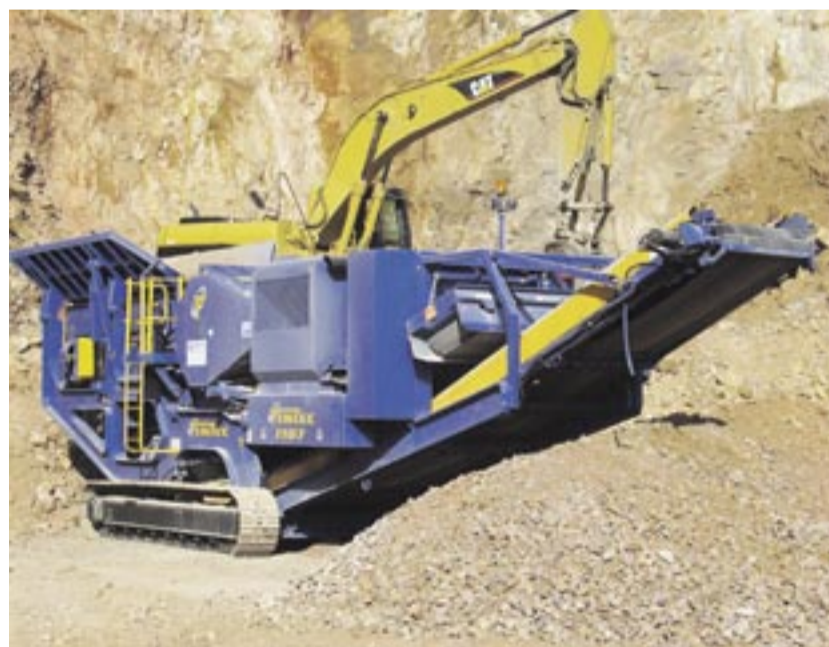
Der Sandvik-Backenbrecher im Einsatz mit einem Cat-Kettenbagger im Steinbruch in Katzenelnbogen.
