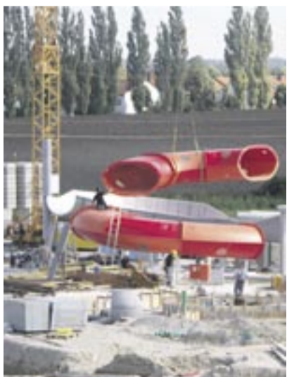
Zwölf Rutschen mit allen nur denkbaren Schwierigkeitsgraden wurden montiert.
