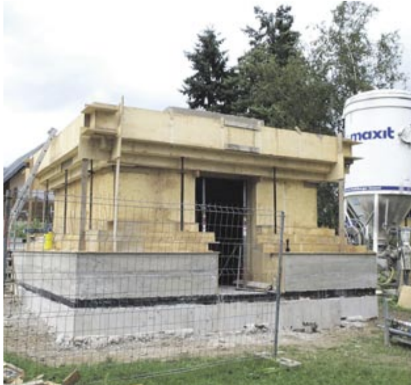
Ebenfalls ungewöhnlich: die Schalung und die Betonierarbeiten mit Leichtbeton.
