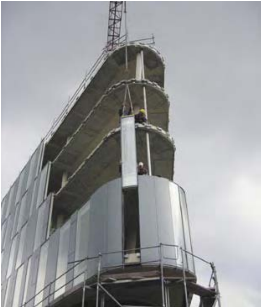
Stationen der Elementmontage: Ohne Gerüst wurden die vorgefertigten Elemente auf der Baustelle per Kran eingeschwenkt und eingehängt – eine sichere, wirtschaftliche und witterungsunabhängige Montageform.
