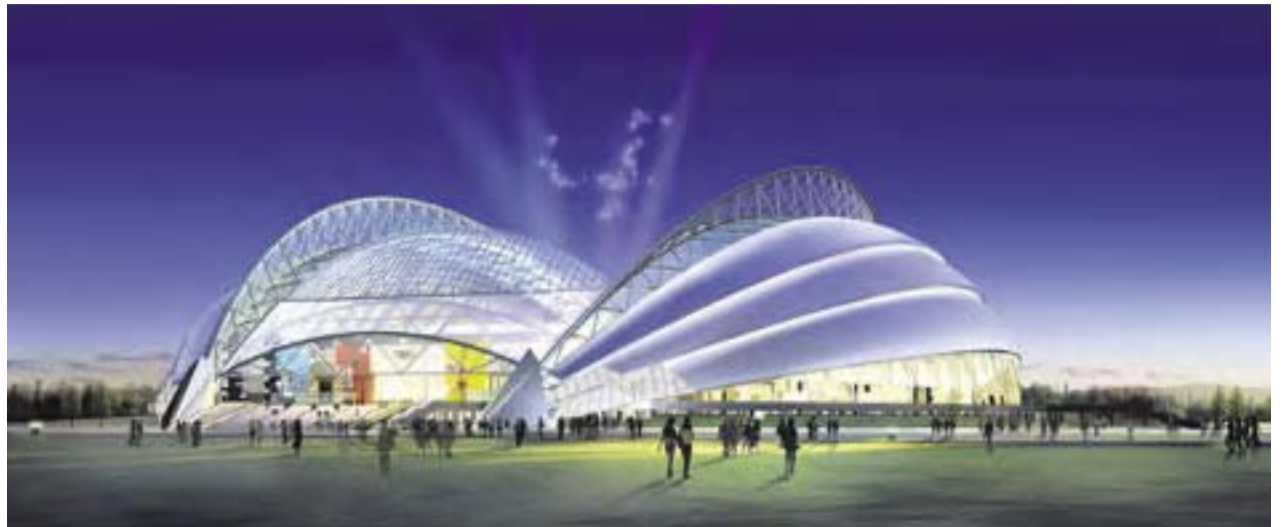
Für das Dach des Stadions Shenyang entwickelte Bayer Sheet Europe eine Makrolon-Platte mit extremer Biegefestigkeit.
