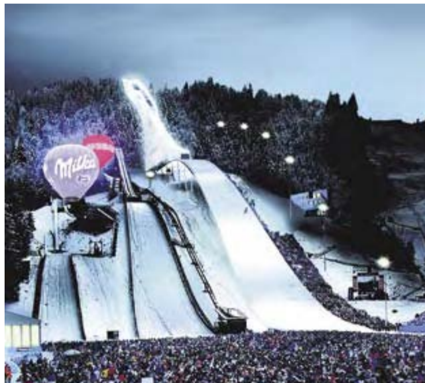
Die neue Olympia-Sprungschanze von Garmisch-Partenkirchen. Fotos: Sieber + Renn
