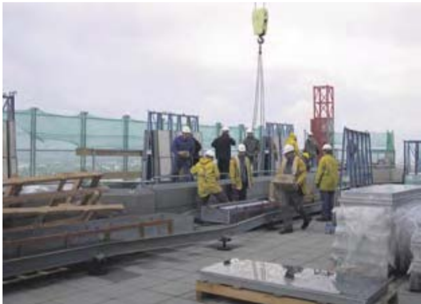
Trotz hohem Abstimmungsaufwand gewährleisteten die Mitarbeiter der Firma FKN eine zügige Fertigstellung.
