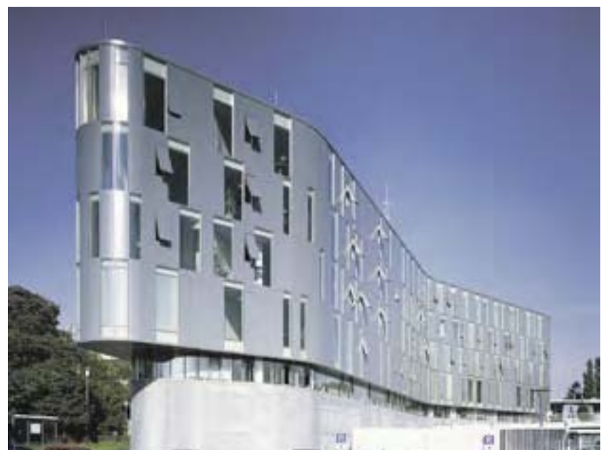
Die geschwungene, nierenförmige Elementfassade eines nicht gerade gewöhnlichen Behördenbaus: Die Kreispolizeibehörde Mettmann, gebaut nach einem Entwurf von Professor Enno Schneider Architekten, Detmold/Berlin.
