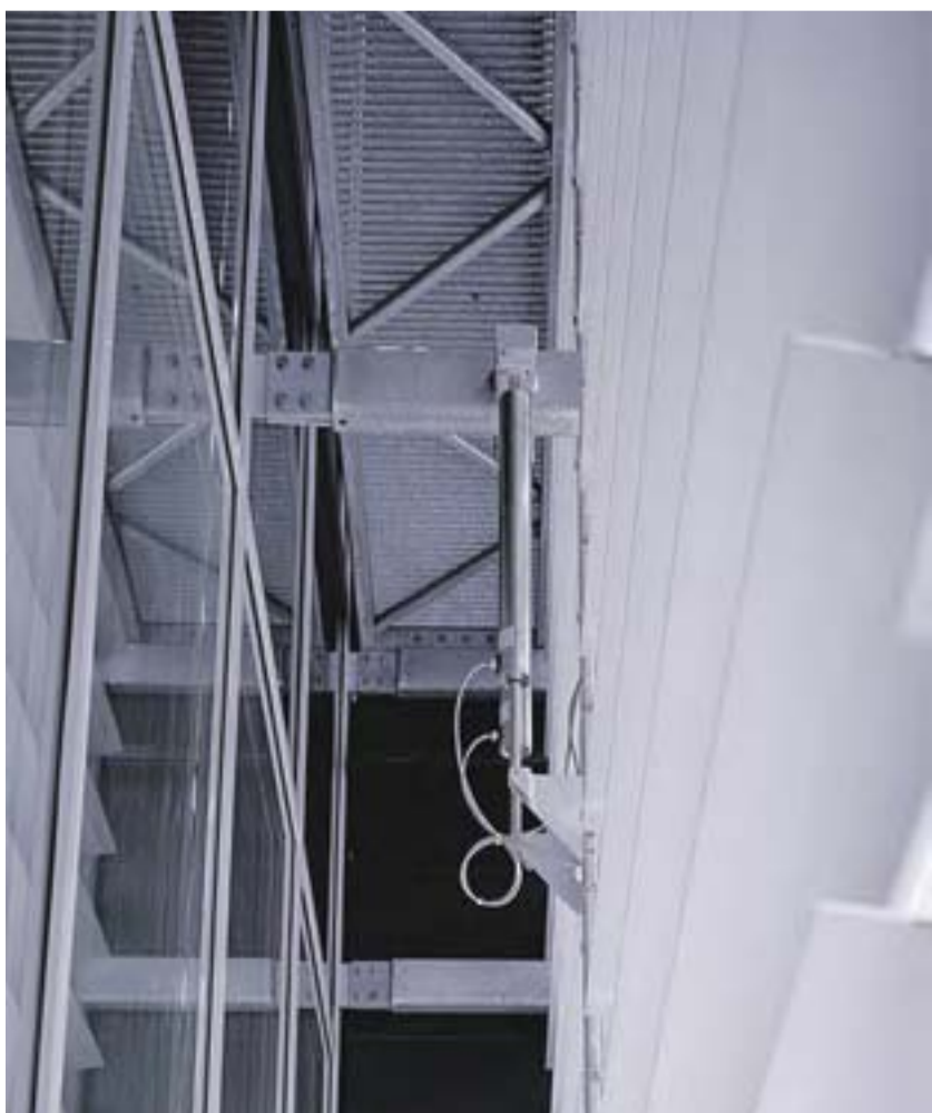
Der wetterfeste Linearantrieb Econom im Einsatz: Er sorgt für die exakte Positionierung der Sonnenschutz-Großlamellen.
