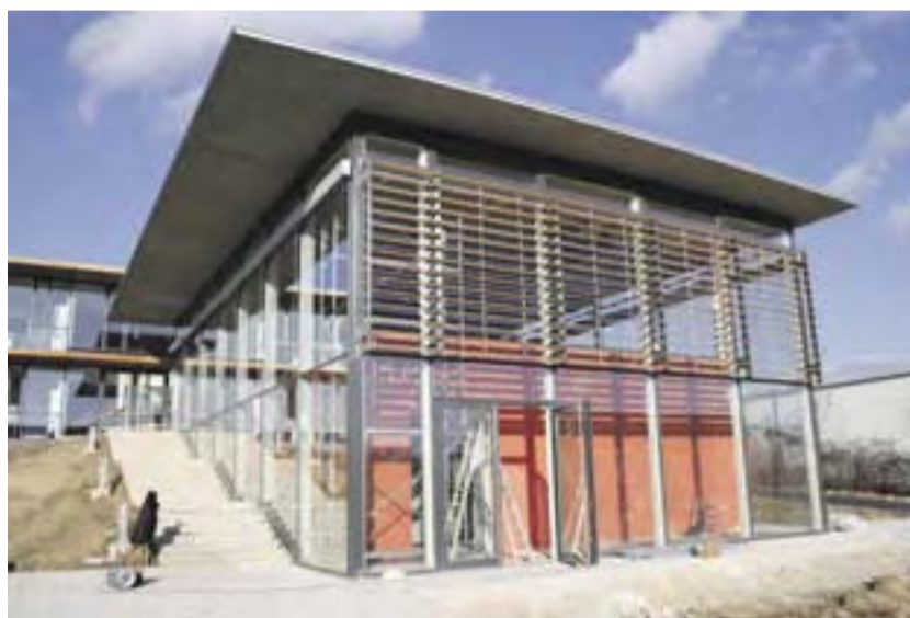
Ausstellungshalle in Massing. Das 15 mal 20 Meter große Dach wurde aus sieben Vollfertigteilen zusammengesetzt. Foto: Syspro/Laumer
