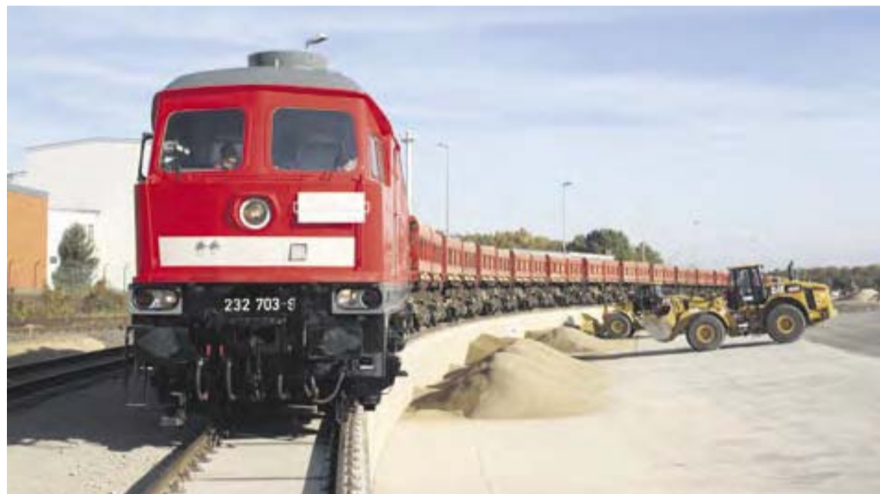
Cat-Radlader verladen Sand für das neue Mischwerk.
