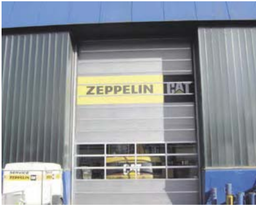
An den Standorten Osnabrück und Köln wurden zahlreiche Butzbach-Hubtore mit integriertem Zeppelin-Cat-Logo installiert. Durch die Integration des Firmenlogos in den Außentoren konnte Zeppelin das Corporate Design des Unternehmens konsequent auch in der Außenansicht übernehmen.
