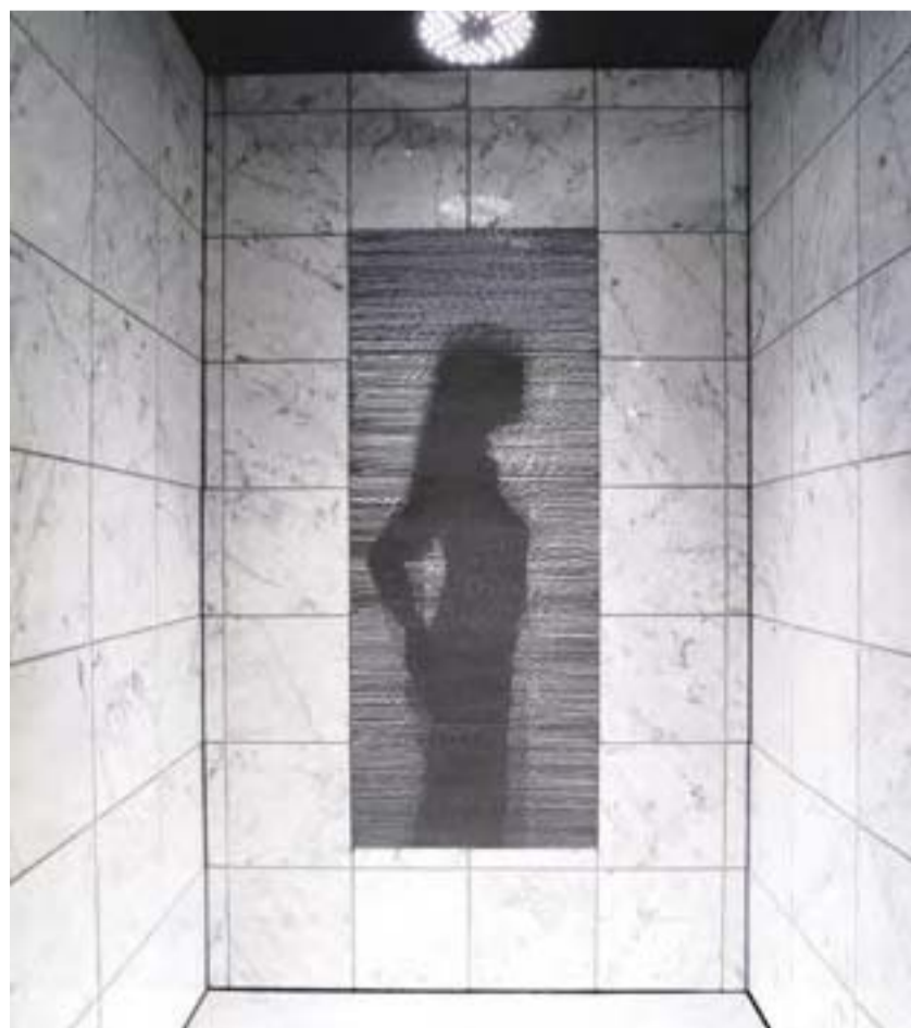
Der lichtdurchlässige Beton sorgt im Zusammenspiel mit Licht für erstaunliche Effekte im Badezimmer. Foto: HeidelbergCement/Fuchs
