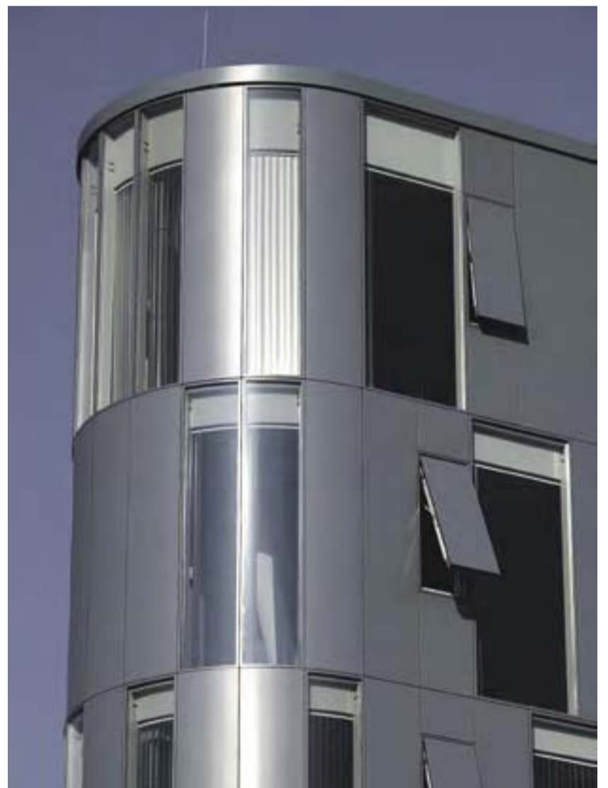
Gerade, polygonale und gebogene Elementflächen machten eine umfangreiche Anpassung der Systemtechnik und Unterkonstruktion notwendig. Systembasis ist die Modulfassade Schüco SkyLine S 65.
