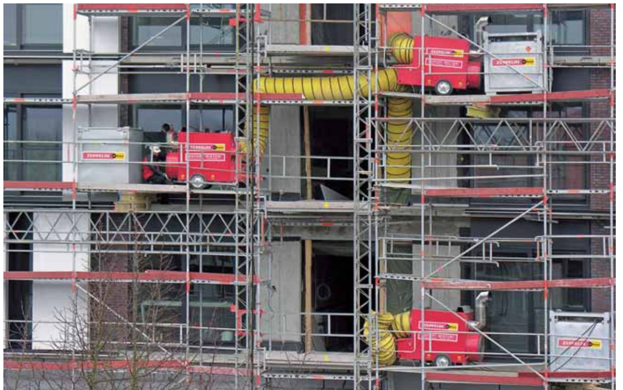
Für die kalte Jahreszeit bringt der Vermietspezialist den mobilen Öl-Lufterhitzer Jumbo 90 M sowie für die Raumtrocknung den Ventilator TTV4500 mit zur Berliner Messe. Foto: Zeppelin Rental
