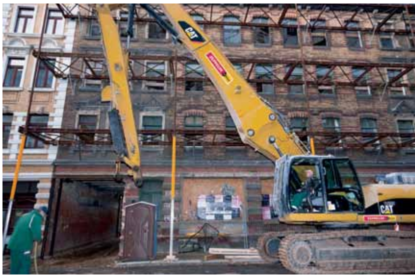
Durch diese enge Zufahrt in der GutsMuthsstraße 48 musste der „Long Demolition“ manövriert werden.
