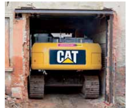
Nur etwa fünf Zentimeter Luft blieben zwischen Bagger und Hausmauer.
