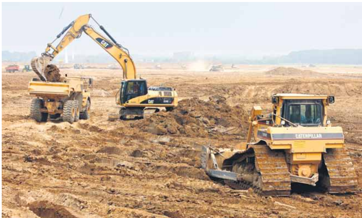
Um die Arbeit auf den Baustellen immer wieder zu verbessern, wird kontinuierlich in neue Maschinenteknik investiert – das macht jährlich durchschnittlich vier Millionen Euro aus. Fotos: Depenbrock
