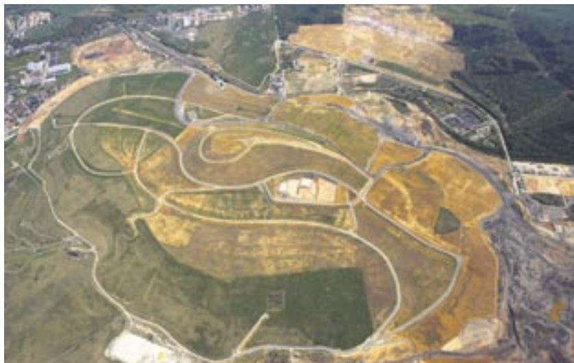
Verfüllkörper Tagebau Lichtenberg 2009. Allein hier wurden 84 Millionen Kubikmeter Abraum umgelagert. Foto: Wismut
