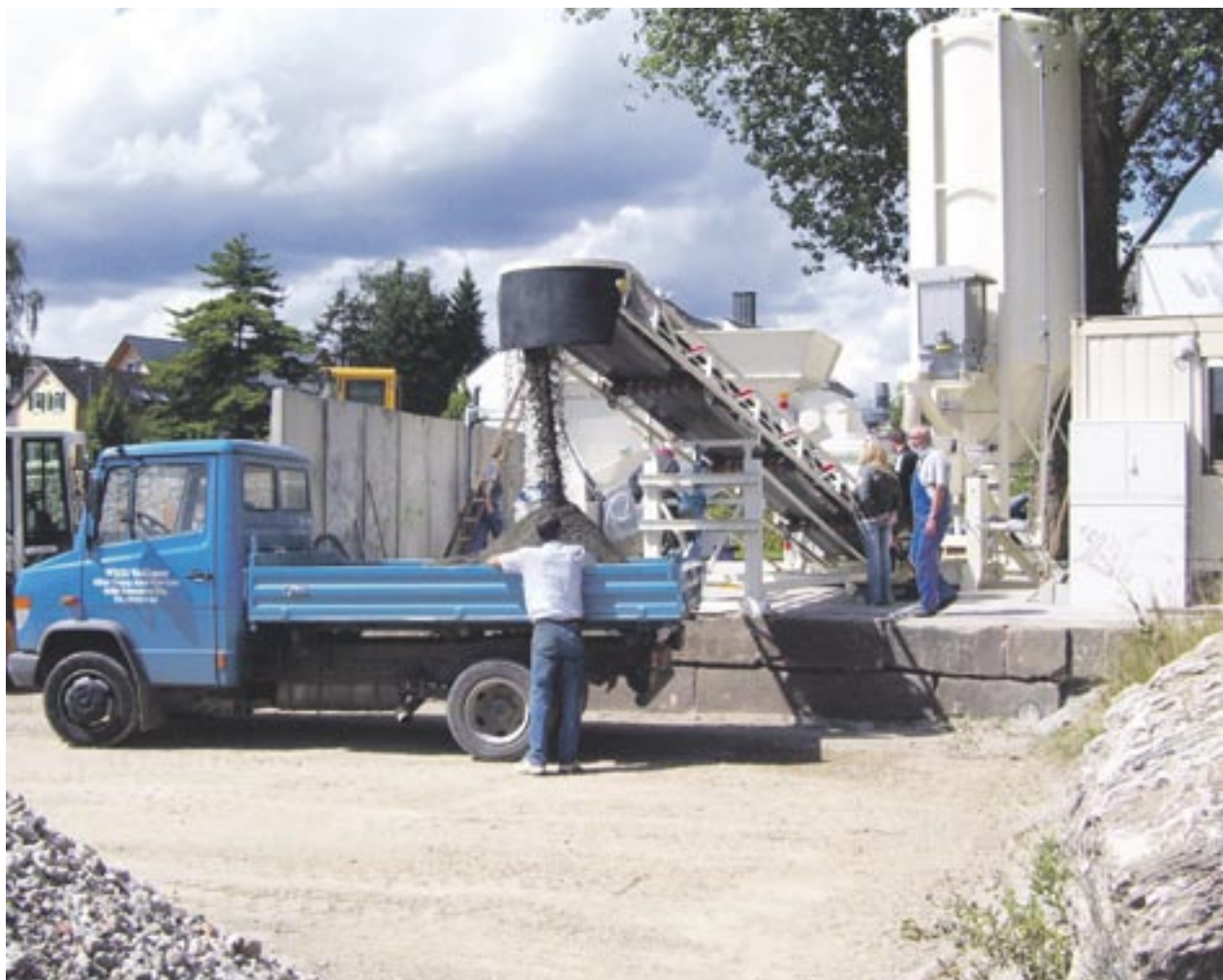
Ranfahren und aufladen: Die Micromix-Betontankstelle liefert für jeden die richtige Mischung – ob nun Beton, zementgebundenes Recyclingmaterial oder Trockenmischung. Fotos: Micromix
