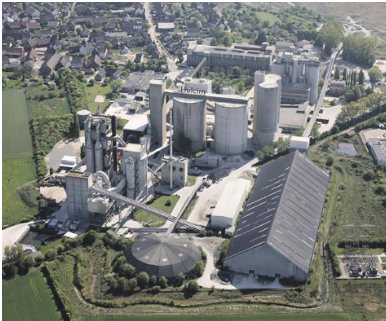
1,8 Millionen Tonnen Kalkmergel werden pro Jahr für die Zementproduktion abgebaut.
