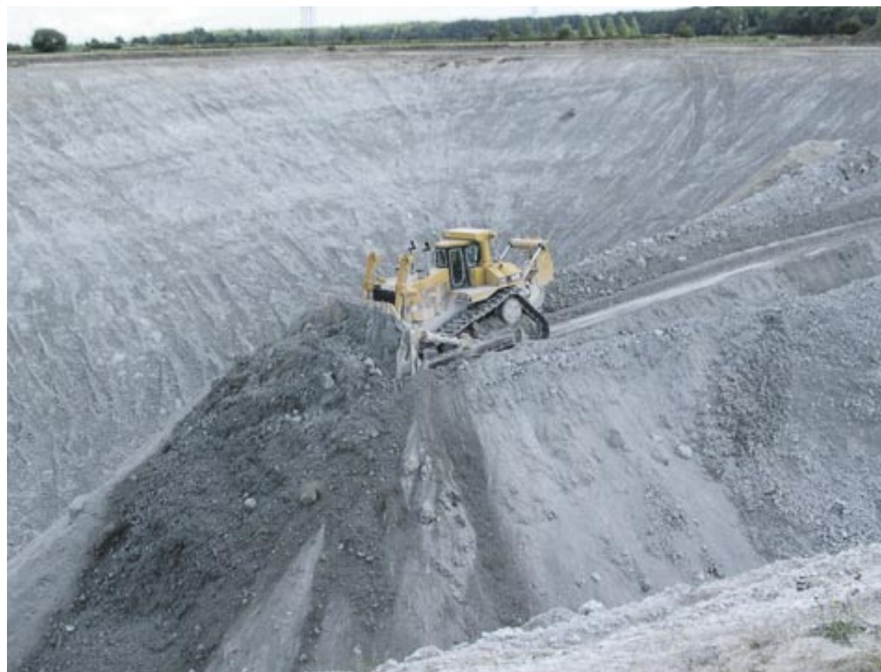
Die Raupenfahrer rammen den Reißzahn der Baumaschine bis zu zwei Meter tief in den Untergrund und lösen das Material. Mit dem Dozerschild wird dann der gelockerte Naturstein zum mobilen Brecher geschoben. Fotos (2): Holcim (Deutschland) AG
