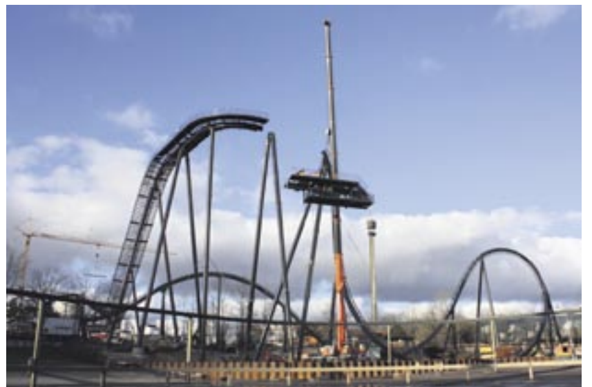
Ein 200-Tonnen-Kran hebt die letzten Schiene.
