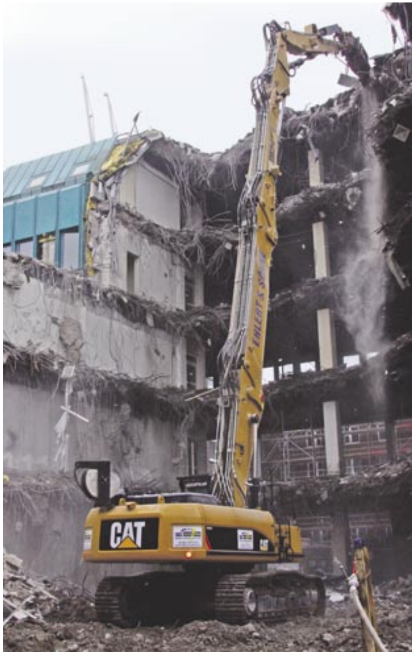
Ausgestattet mit einer fünf Meter langen Verlängerung erreicht der Cat DEM50 bis zu 23 Meter. Fotos: Zeppelin
