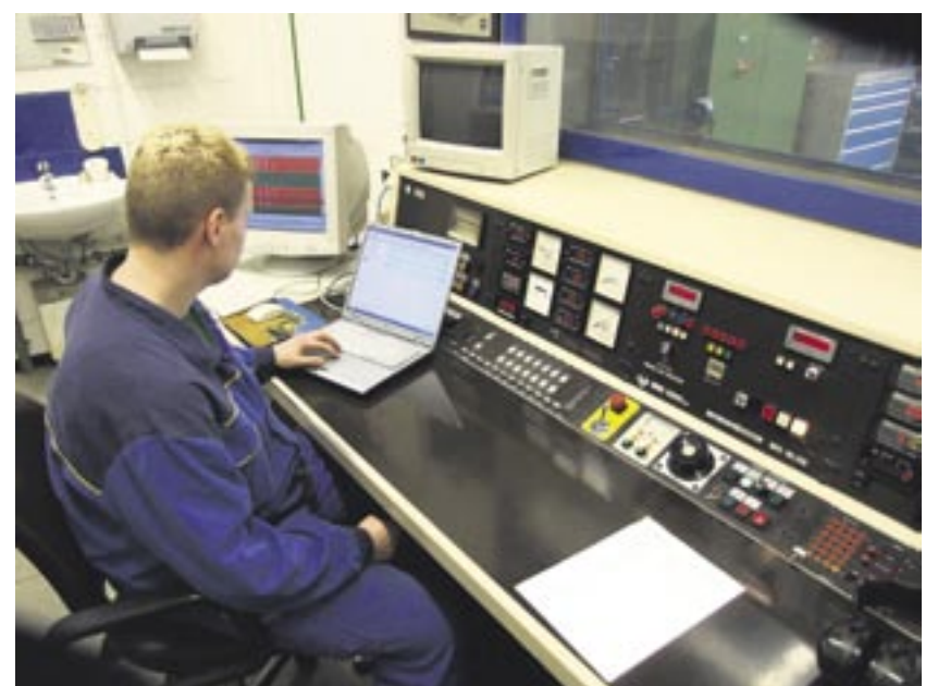
Bevor die Instandsetzung abgeschlossen werden kann und die Endabnahme erfolgt, muss der Motor auf den Prüfstand und einen Leistungstest bestehen.
