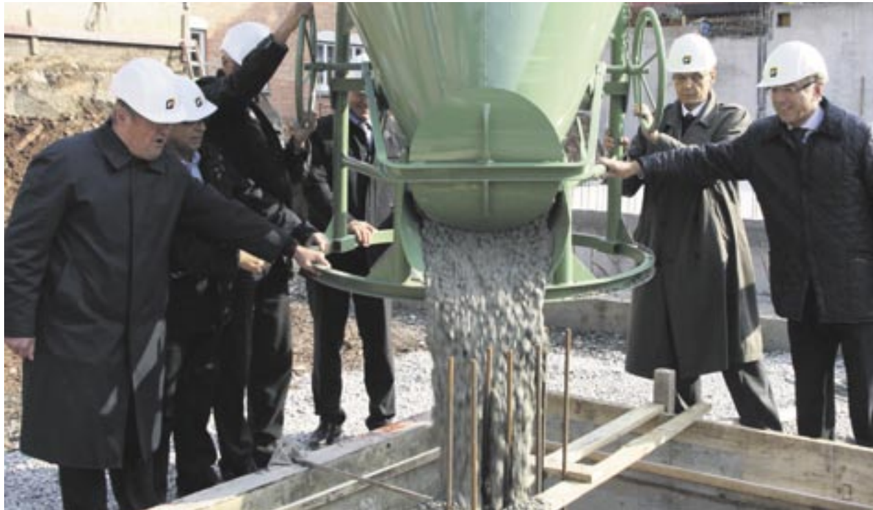
Das Wohnungsbauprojekt des Bau- und Wohnvereins Stuttgart ist das erste seiner Art in Baden-Württemberg. Als Betonzuschlagstoff werden neben den Primärrohstoffen Sand, Kies und Naturstein gütüberwachte, recycelte Baustoffe aus rückgebauten Gebäuden eingesetzt. Foto: Industrieverband Steine und Erden Baden-Württemberg
