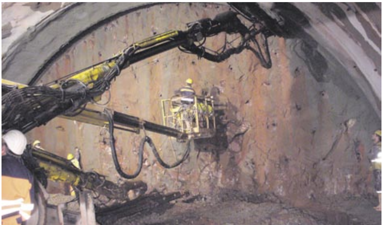
126 Quadratmeter Ausbruchquerschnittsfläche: Vortriebsarbeiten im Tunnel Bleßberg.
