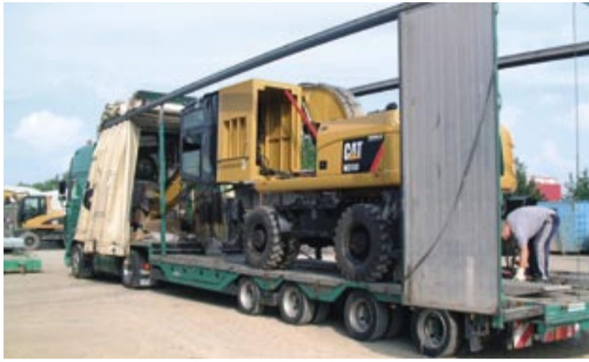
So lässt sich der umgebaute Mobilbagger mit erhöhter Kabine auf einem Tieflader transportieren. Foto: Zeppelin
