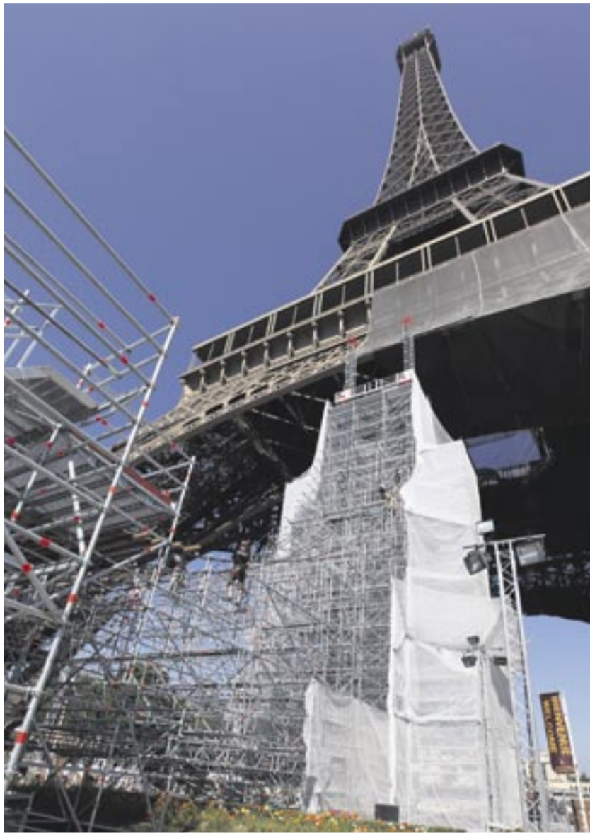
Eine Rampe aus Layher-Gerüsten verhalf Taïg Khris zum Weltrekord. Foto: Layher
