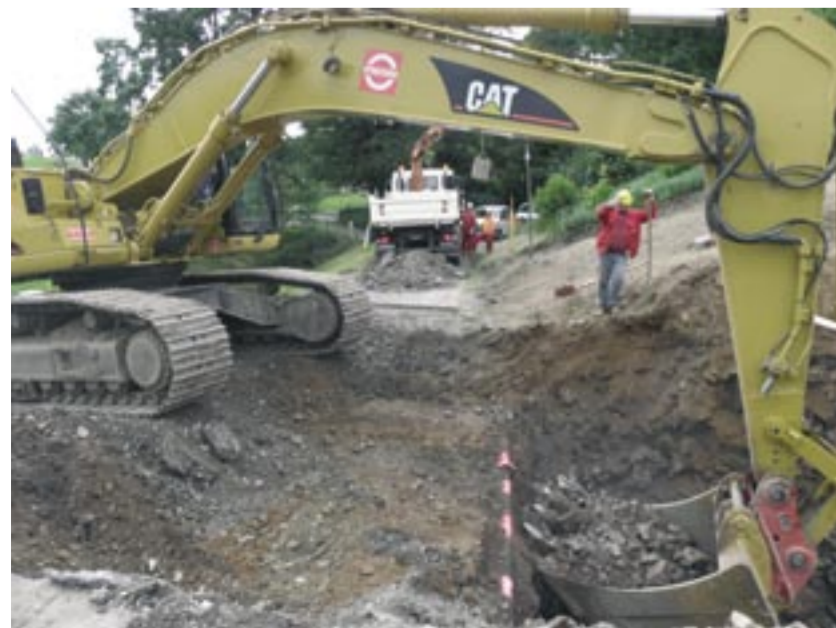
Der Oberboden wird mit einem Hydraulikbagger abgetragen.
