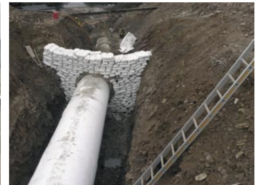
Die Pipeline ist mit einer Felsschutzmatte umhüllt.
