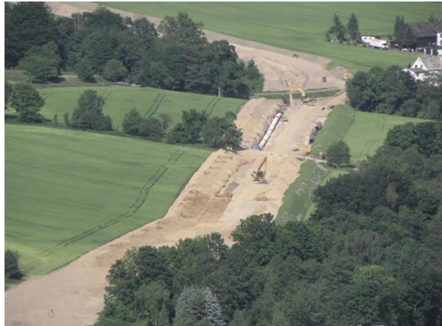
In den einzelnen Abschnitten müssen die Bauarbeiter einen Arbeitsstreifen von 36 Metern Breite anlegen. Dieser bietet gerade genug Platz, um die Baufahrzeuge zu manövrieren und den ausgehobenen Boden zu lagern, der später wieder komplett eingebaut wird. Fotos: Max Streicher
