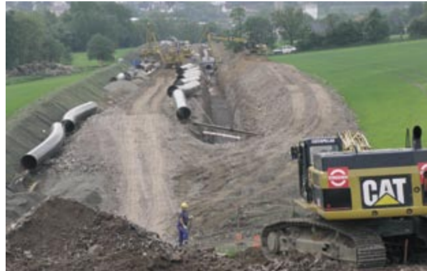
Die Pipeline wird mit einem Meter Deckung unter der Erde liegen, zum Teil auch tiefer.
