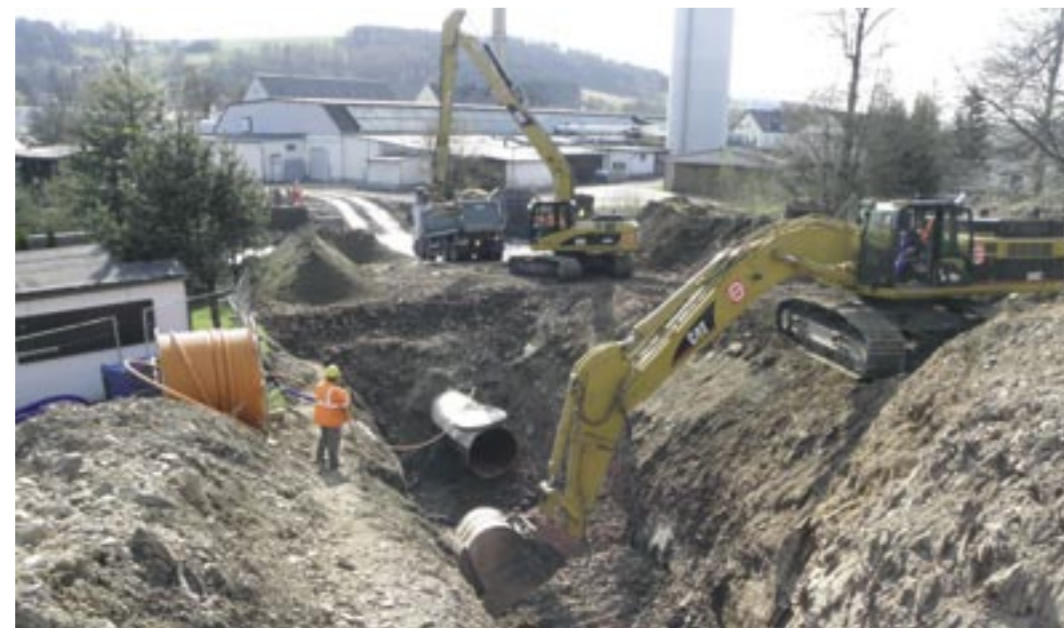
Hydraulikbagger heben den eigentlichen Rohrgraben aus.
