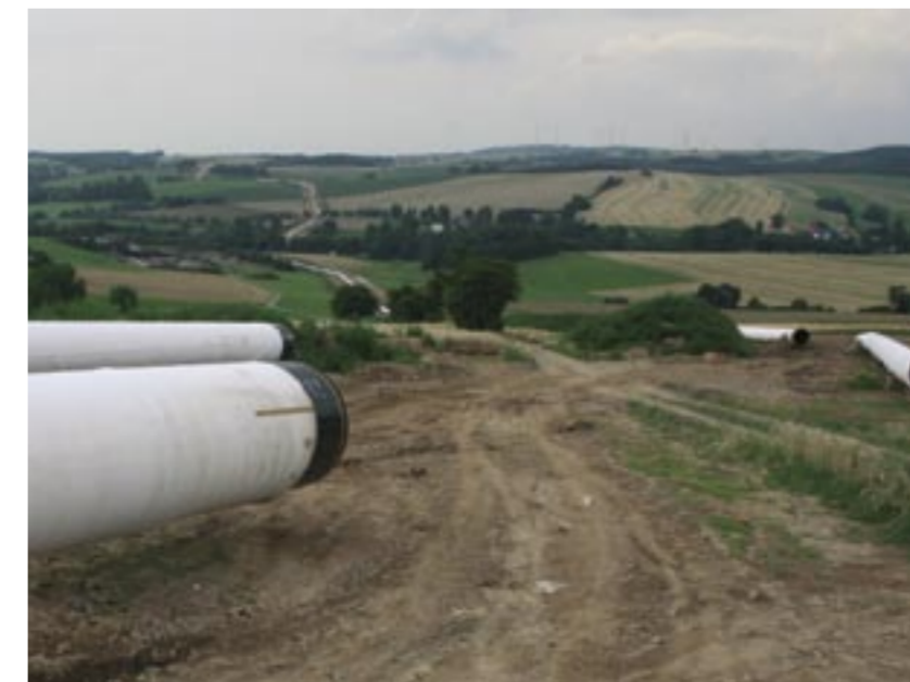
Die Leitung wird aus 18 Meter langen Einzelrohren zusammengesetzt.
