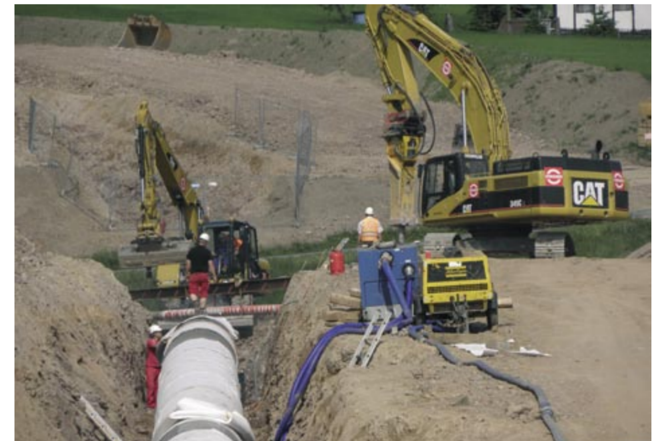
Um den Rohrgraben zu öffnen, sind Hydraulikbagger im Einsatz.
