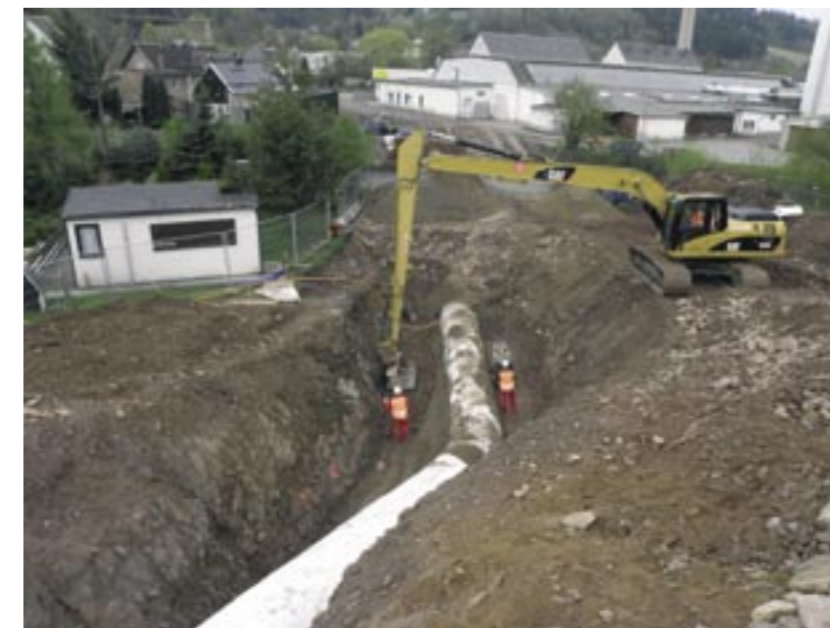
Der Graben wird teilgefüllt.
