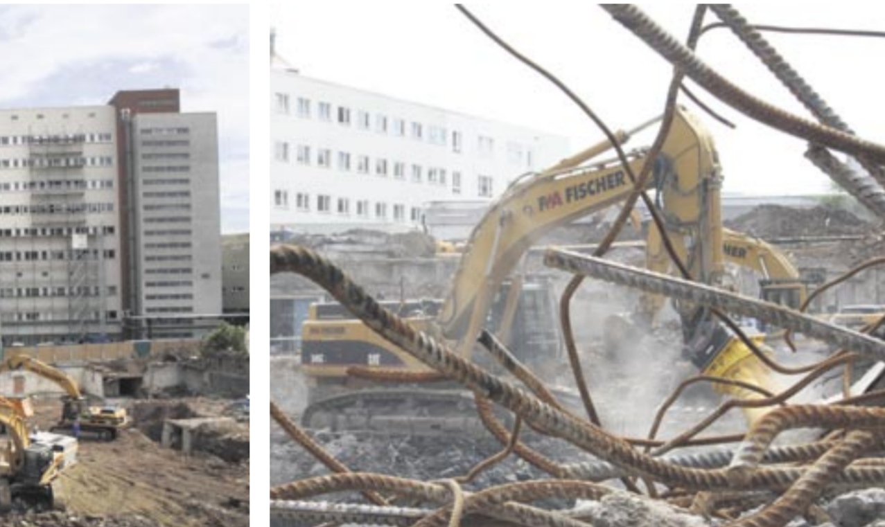
In zwei Abschnitten müssen sechs Gebäude, allesamt stark bewehrt, abgebrochen werden.
