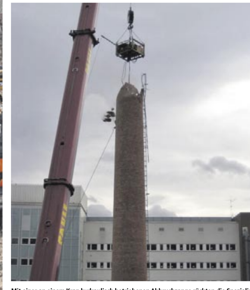
Mit einer an einem Kran hydraulisch betriebenen Abbruchzange rückten die Spezialisten dem Kamin in einer Höhe von 54 Metern über dem Gelände zu Leibe. Foto: Fischer
