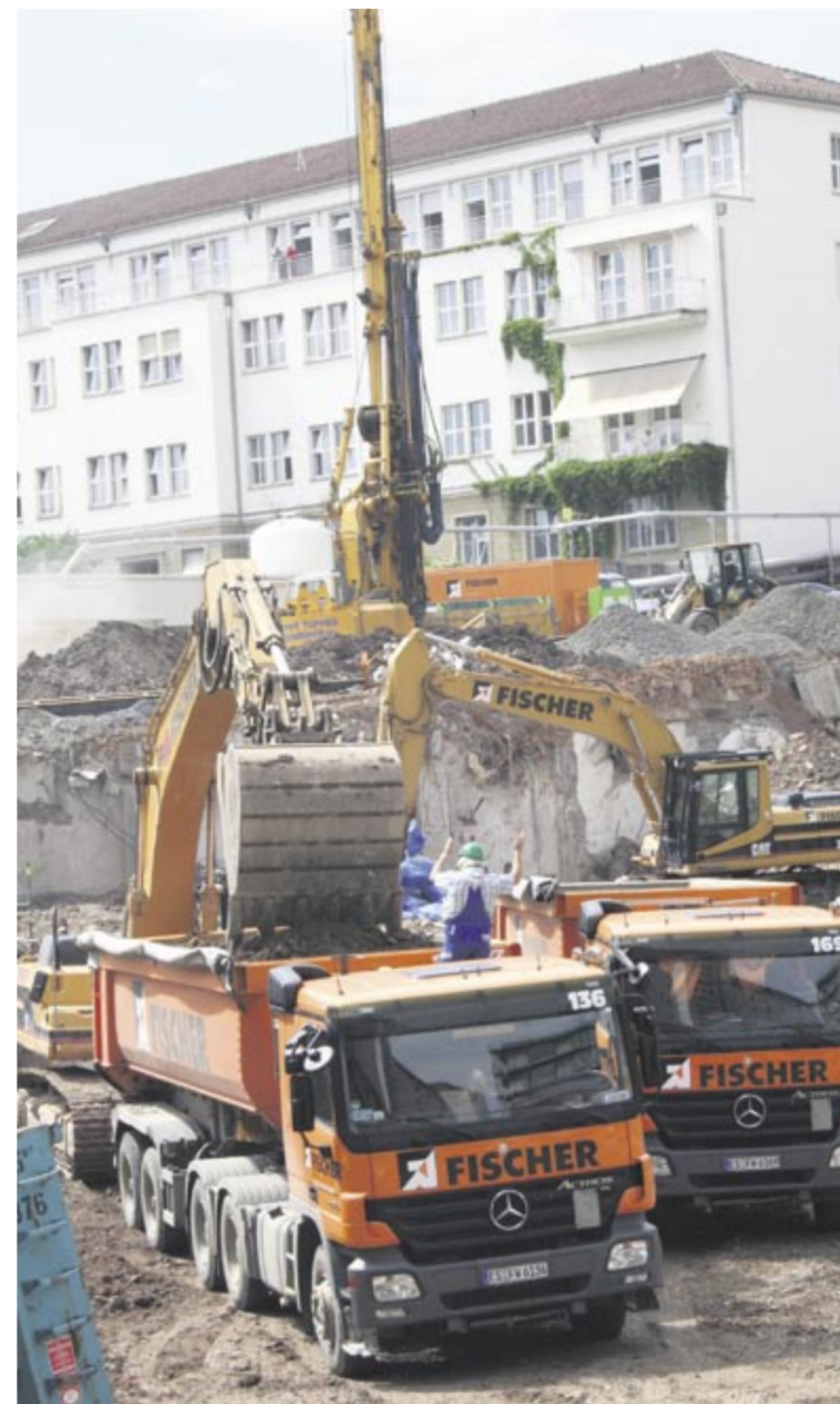
70 000 Kubikmeter Material müssen nun in Bauphase II bis September 2010 ausgehoben und abgefahren sein.
