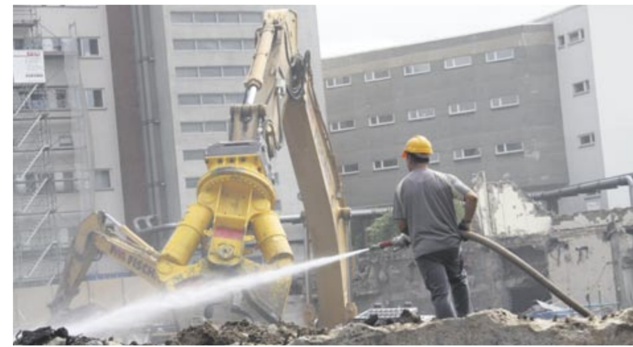
Um die Staubeentwicklung einzudämmen, muss das Abbruchunternehmen besonders häufig den Wasserstrahl auf die Abbruchwerkzeuge an den Cat Baumaschinen richten.
