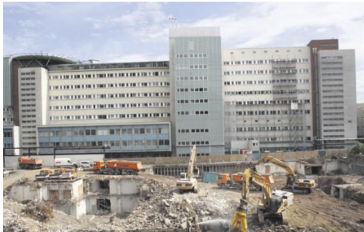
Während der gesamten Baumaßnahme muss der Klinikbetrieb ungestört in vollem Umfang weiterlaufen.
