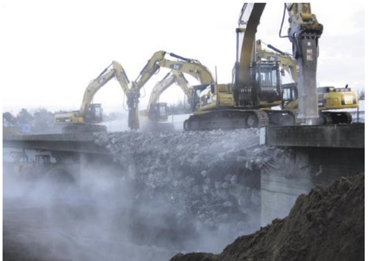
Maschineneinsatz beim Abbruch von Brückenbauwerken.
