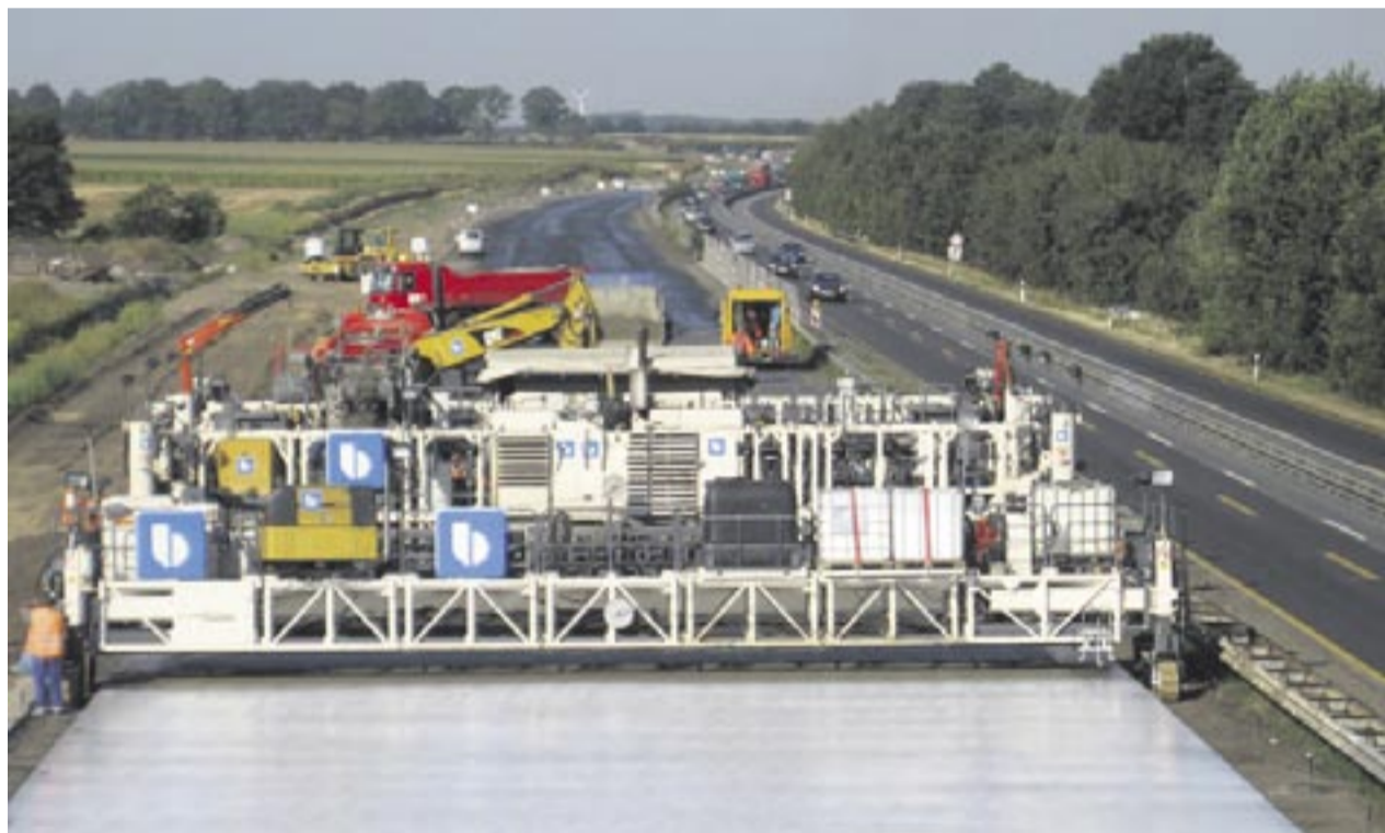
Betonfertiger im Einsatz.
