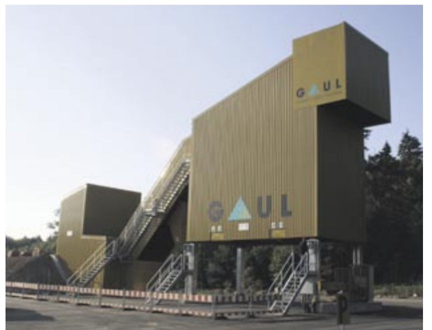
Das 2009 errichtete Asphaltpuffersilo in Idstein ermöglicht bis zu drei Tage lang die luftdichte, hochisolierte Lagerung von Asphalt ohne Qualitätseinbußen.
