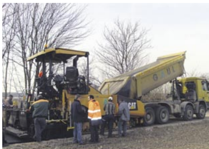
Eine solide Einbauleistung erwartet das Unternehmen Steffes-Mies von seinem neuen Cat Fertiger AP 655D.
