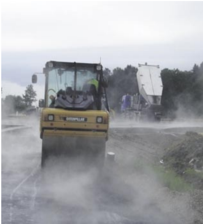
Auf Baustellen in ganz Deutschland im Testeinsatz: die neue Cat Walze CD54.
