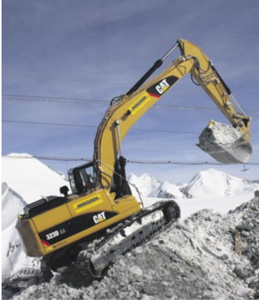
Baumaschineneinsatz 3 800 Meter über dem Meeresspiegel.
