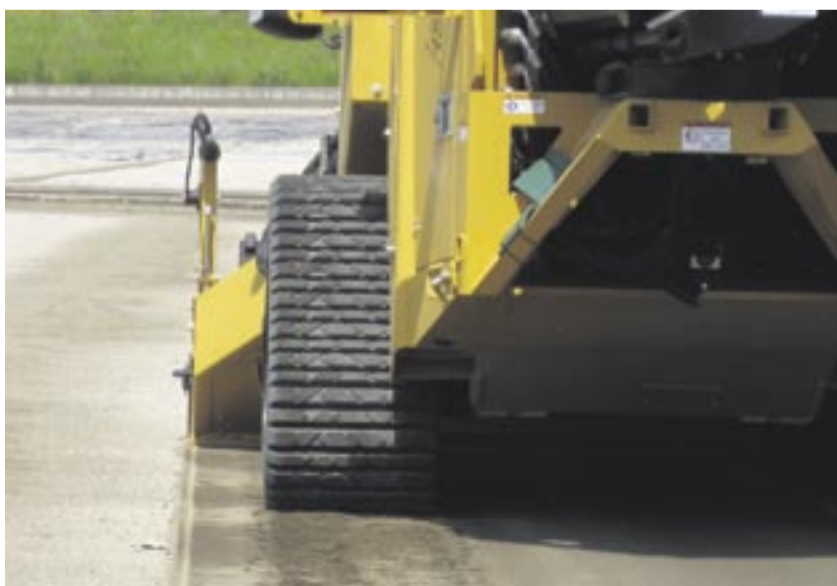
Mit einer Genauigkeit von plus/minus zwei Millimeter wird der Sand zum Reinigen eingebaut.
