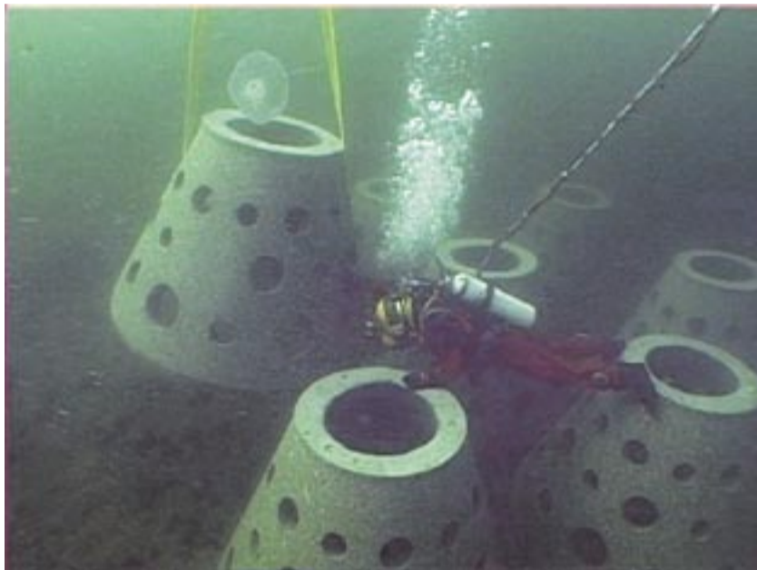
Über 1 400 Betonelemente wurden in der Ostsee auf dem Meeresgrund versenkt.
