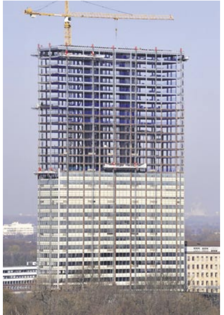
Nach der vollständigen Freilegung seines konstruktiven Kerns wird das Bayer-Hochhaus rundum mit Edeltstahlgewebe bespannt. Foto: Stahl-Informations-Zentrum/ Bayer AG
