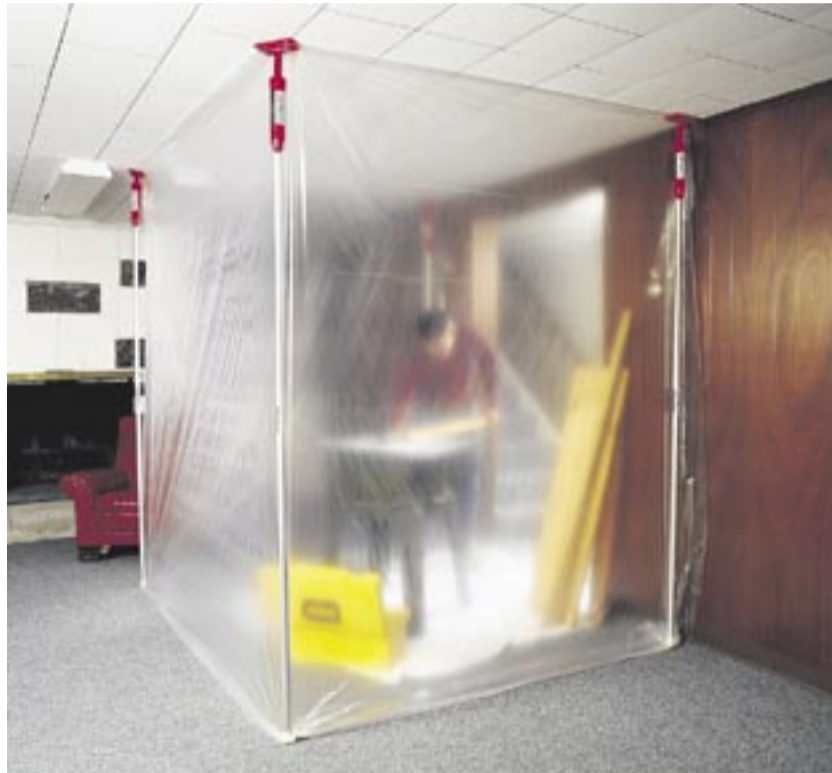
Ein Folien-Wandsystem schützt angrenzende Räume vor Staub.
