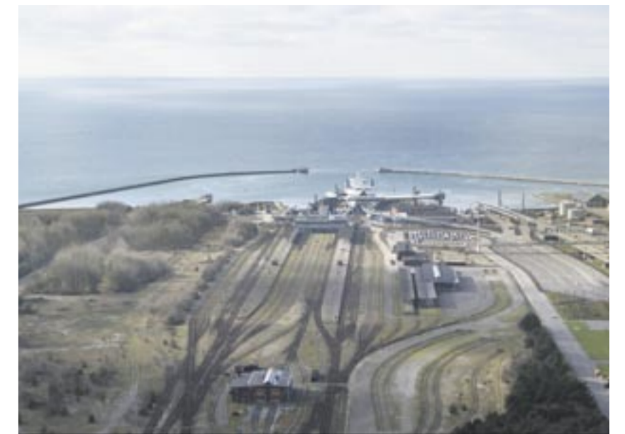
Bestehender Bahnterminal und Fährhafen im dänischen Rødby.
