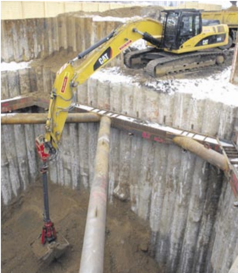
MVS Zeppelin bietet eine Speziallösung: Dank der Greiferverlängerung konnte der Cat 325D LN Erde bis auf eine Tiefe von 14 Metern ausheben. Fotos: MVS Zeppelin
