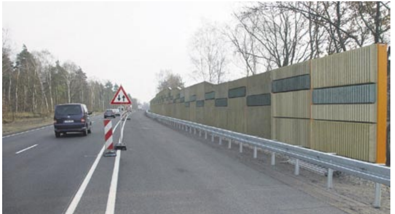
An den Testwänden entlang der Bundesstraße B87 werden die Wissenschaftler auch zukünftig messen, wie viel Lärm der vorbeifahrenden Autos die neuen Schutzwände abfangen können. Foto: Dr. Sandra Gelbrich
