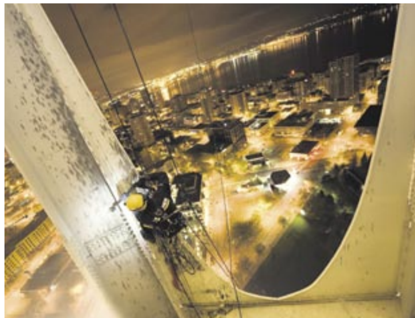
Um den laufenden Betrieb des Gebäudes mit seinen 1,3 Millionen Besuchern im Jahr nicht zu stören, wurde in Nachtschichten gearbeitet. Fotos: Kärcher
