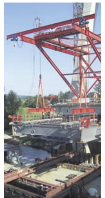
Einheben eines Schusses.
