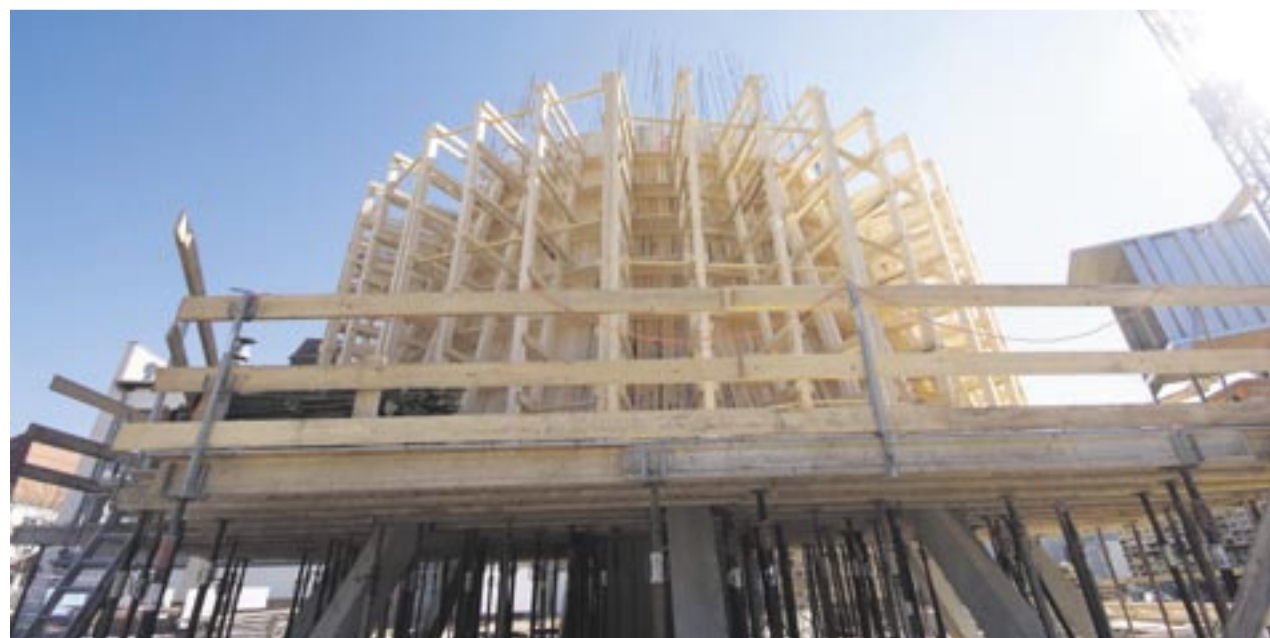
Schon die Schalung des 35 Meter hohen Turmes war spektakulär.
