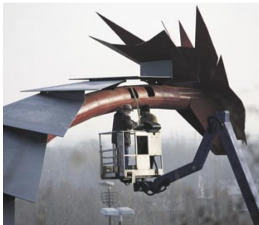
Montiert wurden die Schwingungstilger bereits bei der Fertigung des stählernen Drachenhalses. Vor Ort erfolgte die Feinjustierung und über „Kiemenklappen“ künftig auch die Wartung.
