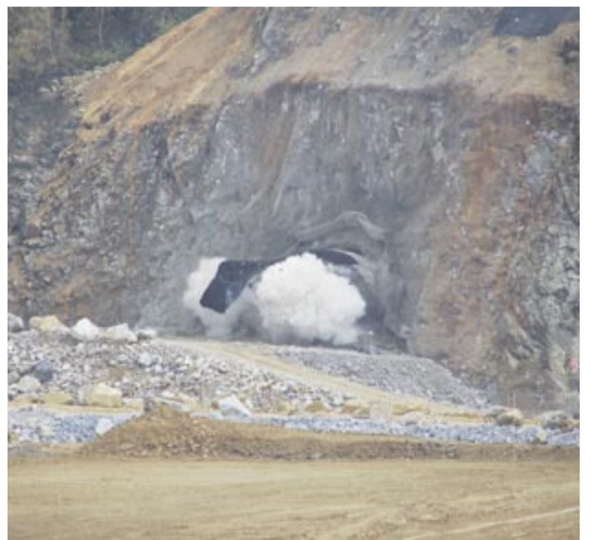
In unmittelbarer Nähe zum bestehenden Steinbruch Rohdenhaus erschließt Rheinkalk kurzzeitig einen zweiten Steinbruch. Um mit den Gewinnungsgeräten nicht über die Kreisstraße fahren zu müssen, welche die beiden Steinbrüche trennt, baut das Unternehmen einen rund 140 Meter langen und zehn Meter hohen Tunnel. Im Bild: Sprengungsarbeiten für die Kalotte.
