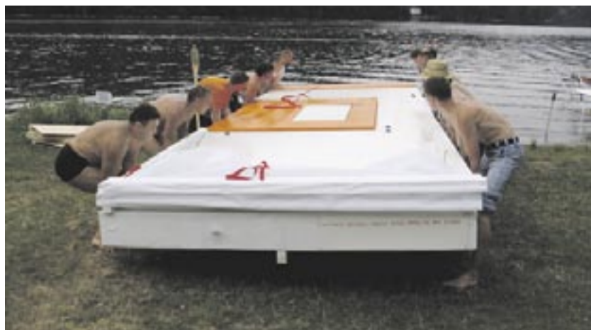
Im Sommer 2006 bauten die Architekturstudenten den ersten Prototypen an der Talsperre Kriebstein. Fotos: Fachhochschule Frankfurt am Main - Studiengang Architektur
