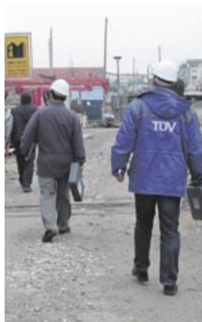
Mitarbeiter vom Baubegleitenden Qualitätscontrolling treffen auf der Baustelle ein. Foto: Tüv Süd Industrie Service
