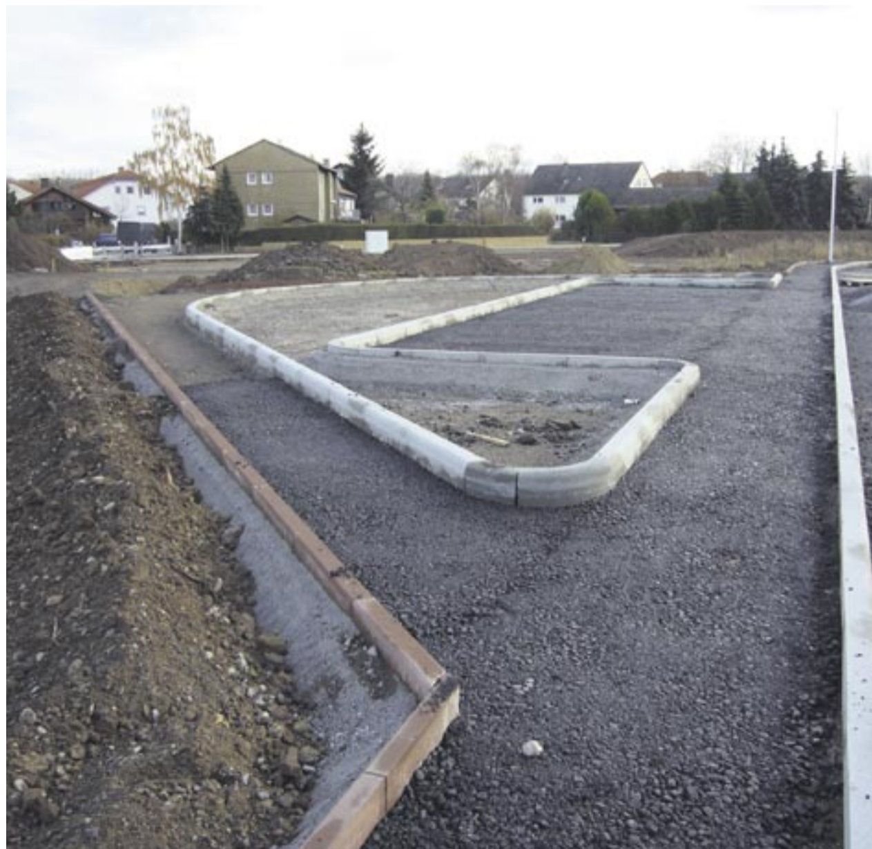
Für die Gemeinde Nackenheim war Stefan Fauß im Rahmen des Projekts „Am Wiesendeich“ gefordert, die zur Ausführung beauftragte Leistung vorab als Pauschale zu ermitteln. Foto: RIB
