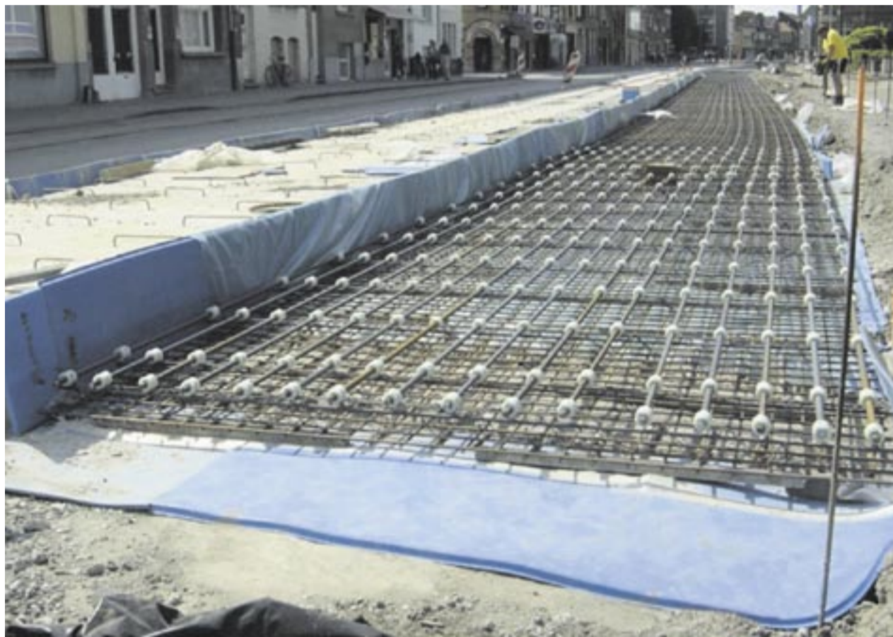
Schutz vor Lärm und Erschütterungen bietet der Einsatz von Masse-Feder-Systemen. Der Gleiskörper kann durch die Verwendung von Boden- und Seitenmatten aus PUR komplett von seiner Umgebung entkoppelt werden, wie hier im belgischen Gent, wo auf einer 1 360 Meter langen, zweiseitigen Straßenbahnstrecke diese Technik eingesetzt wurde. Foto: Schaffer PurFormTechnik
