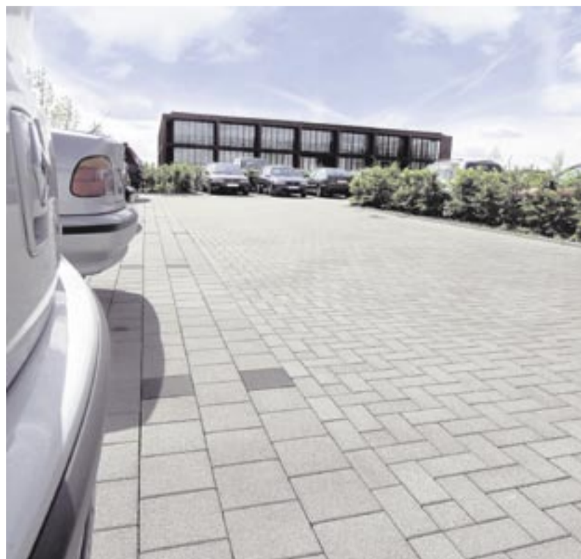
Das Niederschlagswasser versickert, die Schadstoffe jedoch nicht.
