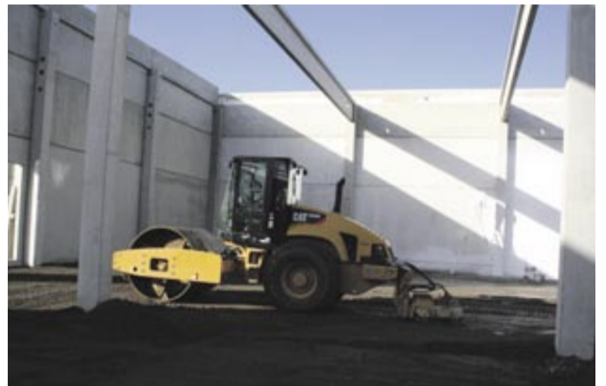
Die Norbert Kamps GmbH ist beauftragt für die kompletten Erdbauarbeiten und die Entwässerung auf 60 000 Quadratmeter für ein neues Logistikzentrum eines Heizungs- und Sanitärhandels in Grevenbroich-Kapellen. Mit dem Cat-Walzenzug CS 563 mit Glattmantelbandage und TCD Datenerfassungsgerät für FDVK setzt das Unternehmen neueste Technologie ein.
