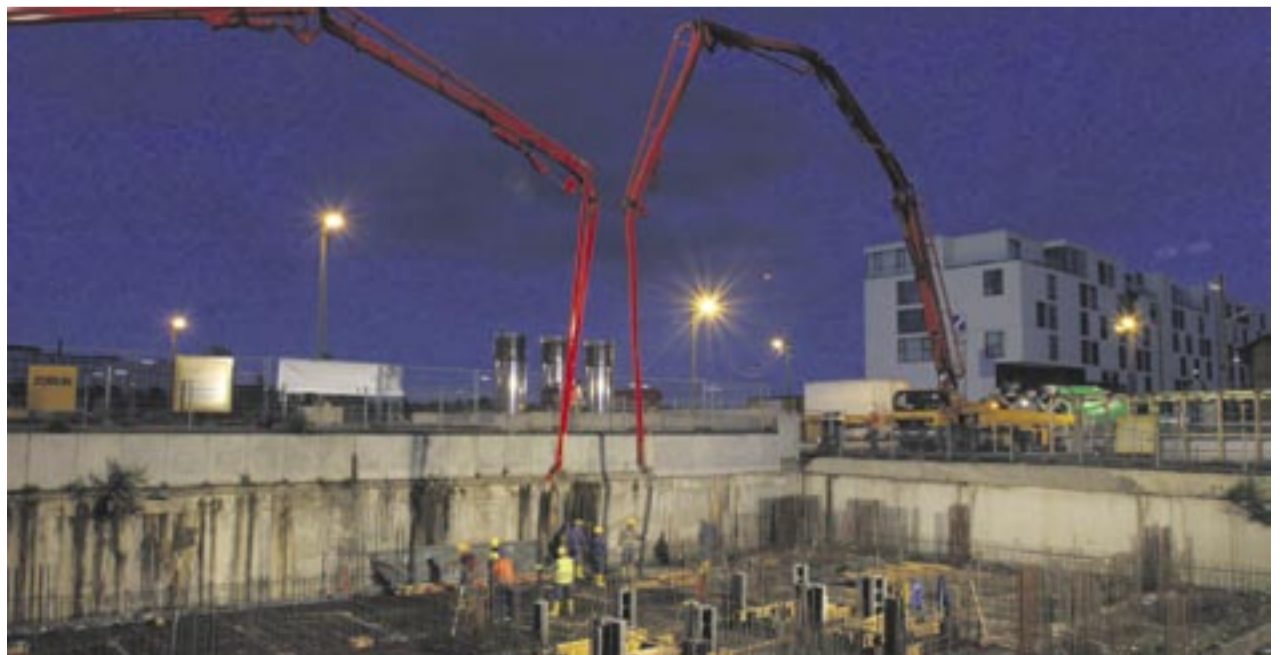
Die Betonagen der Fundamente für das südliche Kranhaus im Kölner Rheinauhafen wurden vor allem nachts durchgeführt.
